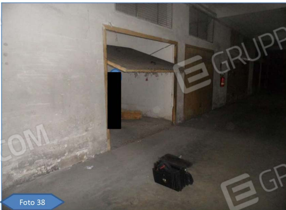
Lotto 2 – Vista dell'accesso al bene in questione.
