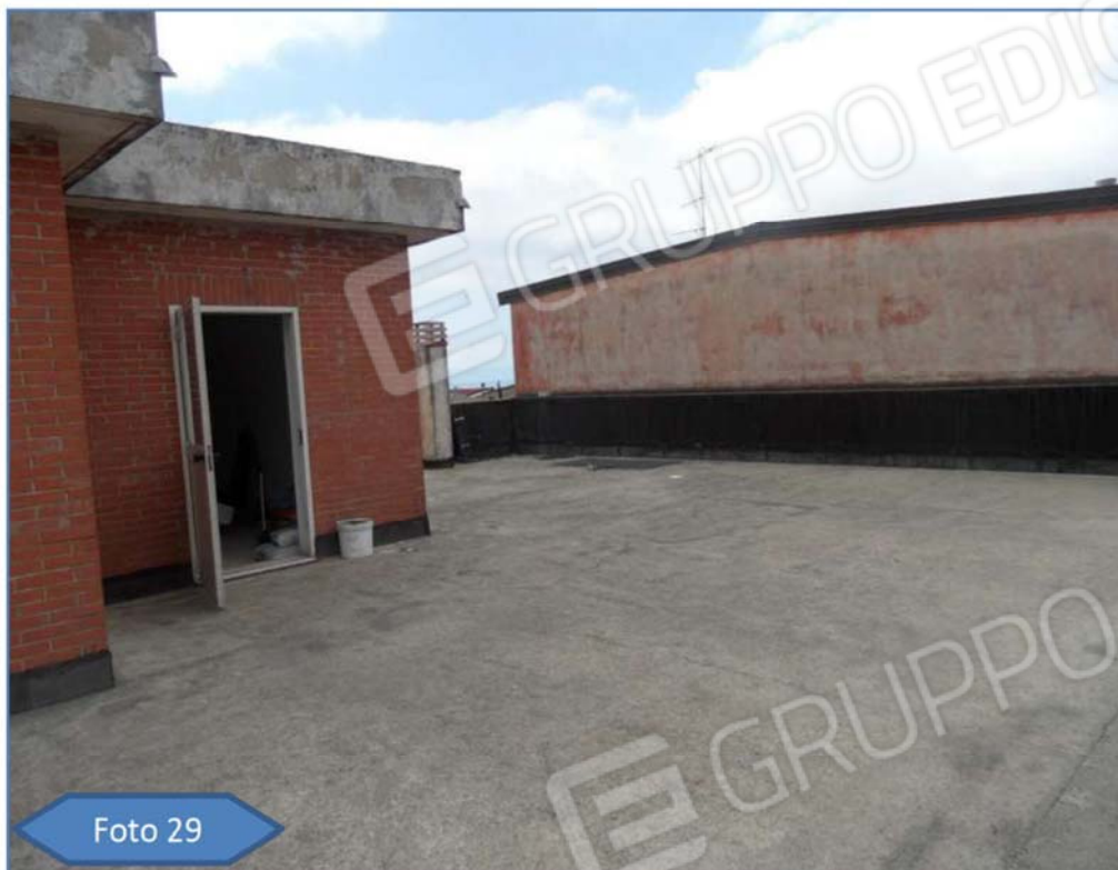
Lotto 1 – Lastrico solare.
