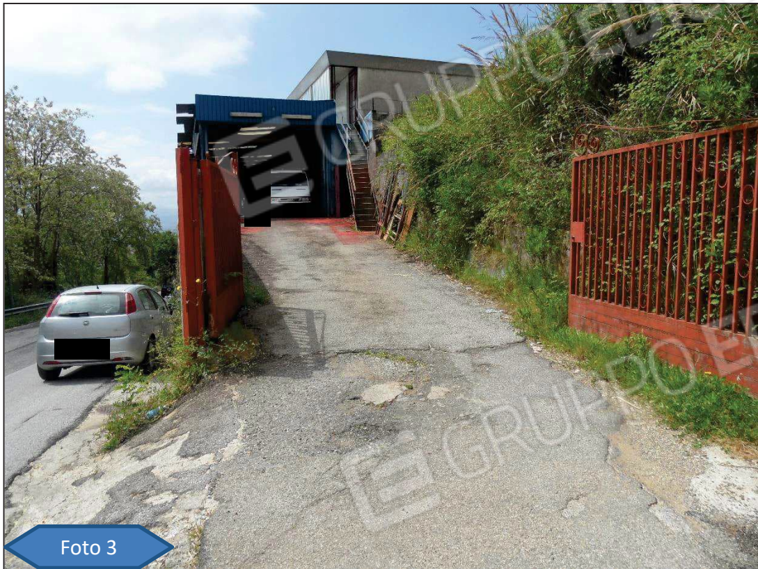
Rampa di accesso al capannone, la proprietà è delimitata da un cancello in ferro.
