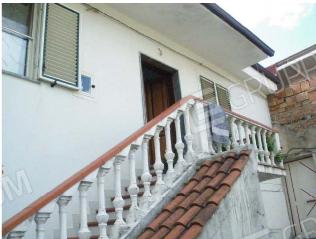
Foto N° 10 – SCALA D'ACCESSO AL PRIMO PIANO
