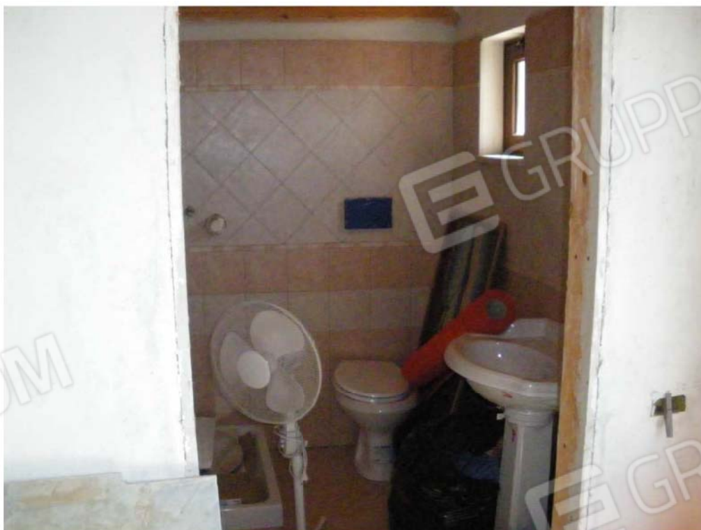
Foto N° 22 – BAGNO IN CORSO DI COSTRUZIONE
