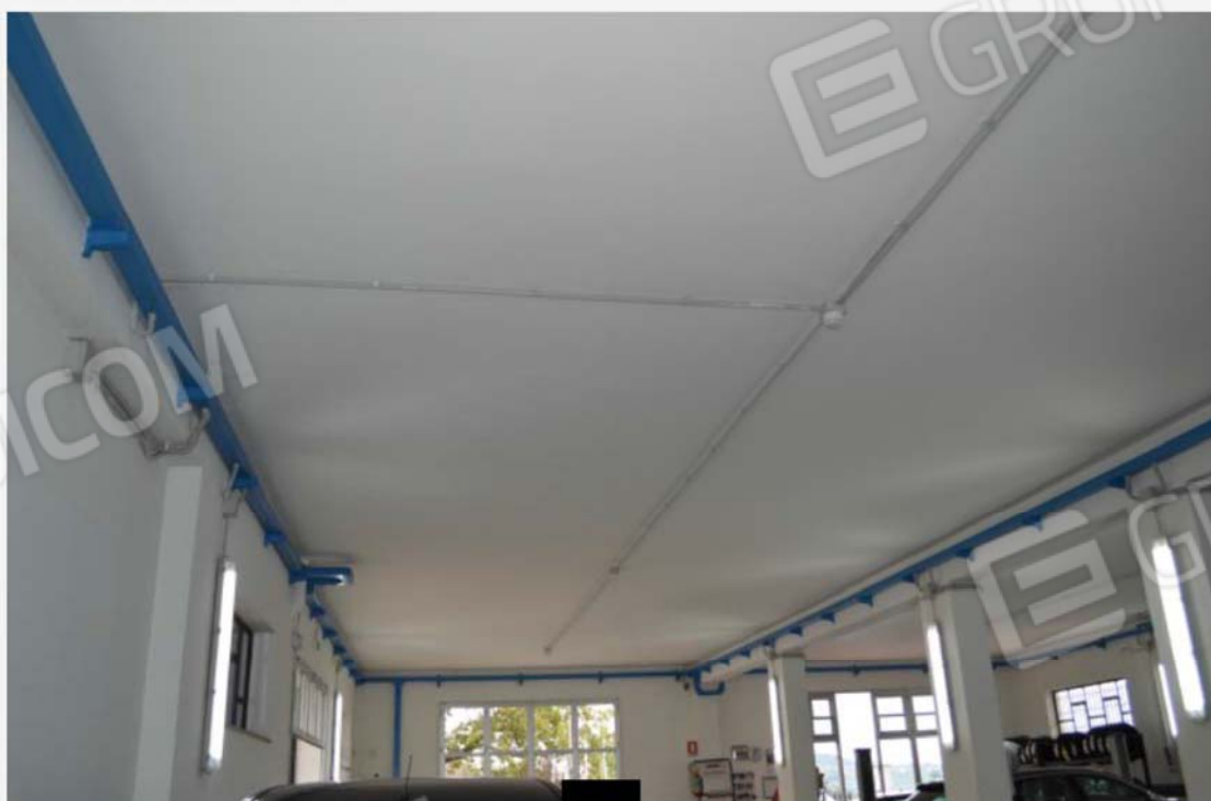
8 - Particolare del soffitto, sub. 3
