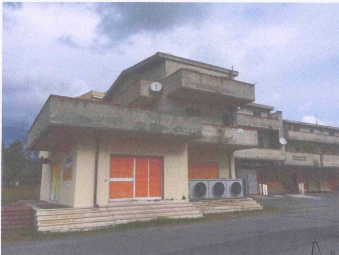
Foto 1 – Vista del fabbricato lato ingresso magazzini
