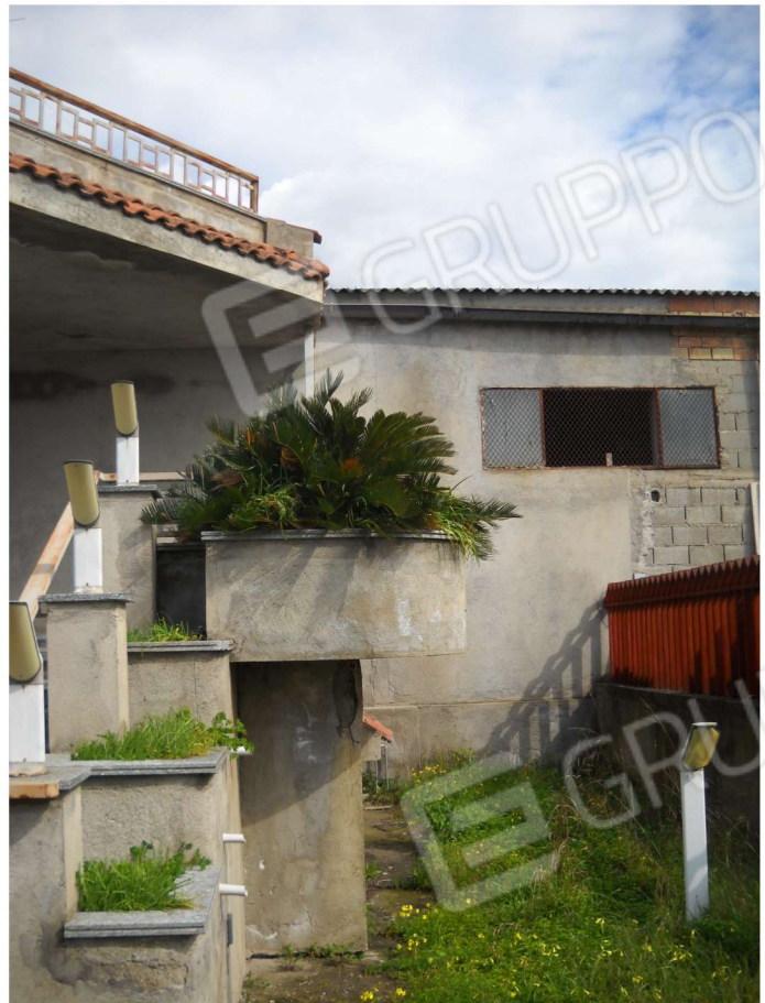
foto n. 2 – fabbricato particella 867 f. di m.32 e fabbricato in aderenza
