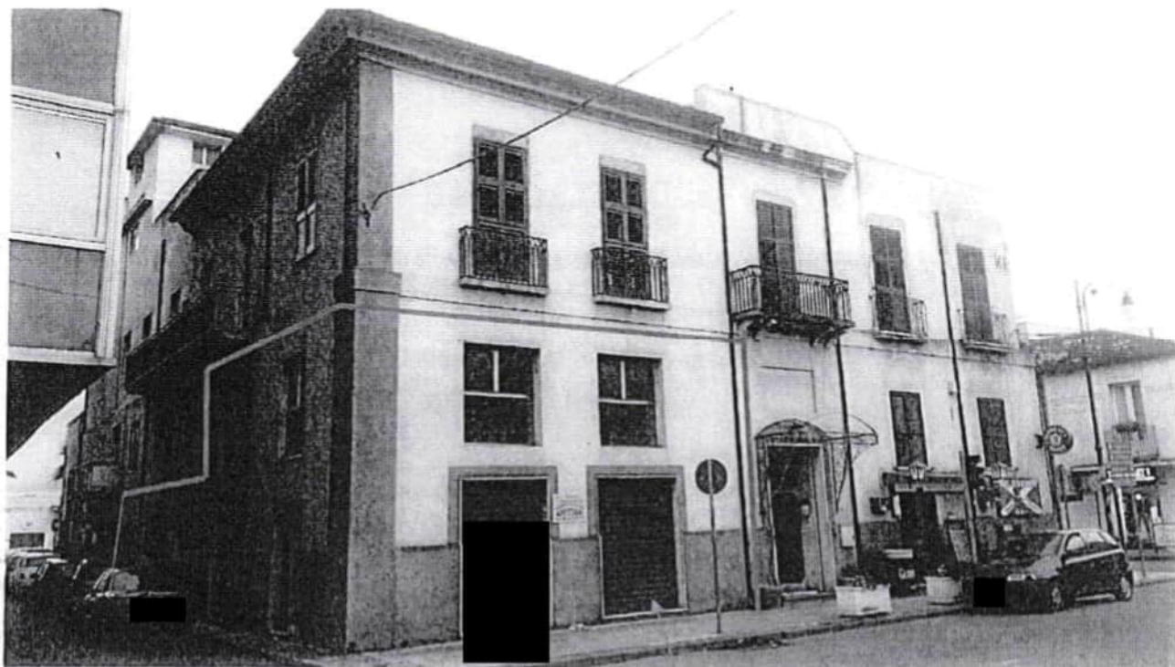
Vista esterna fabbricato - porzione di fabbricato in oggetto
