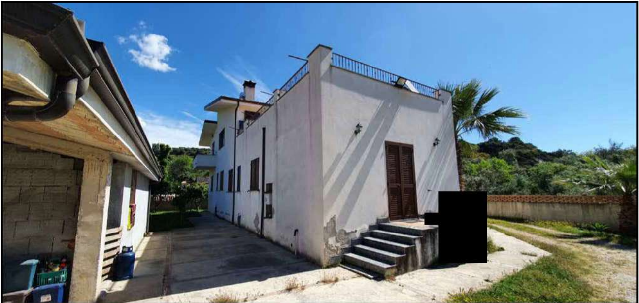
Vista esterna dal lato garage
