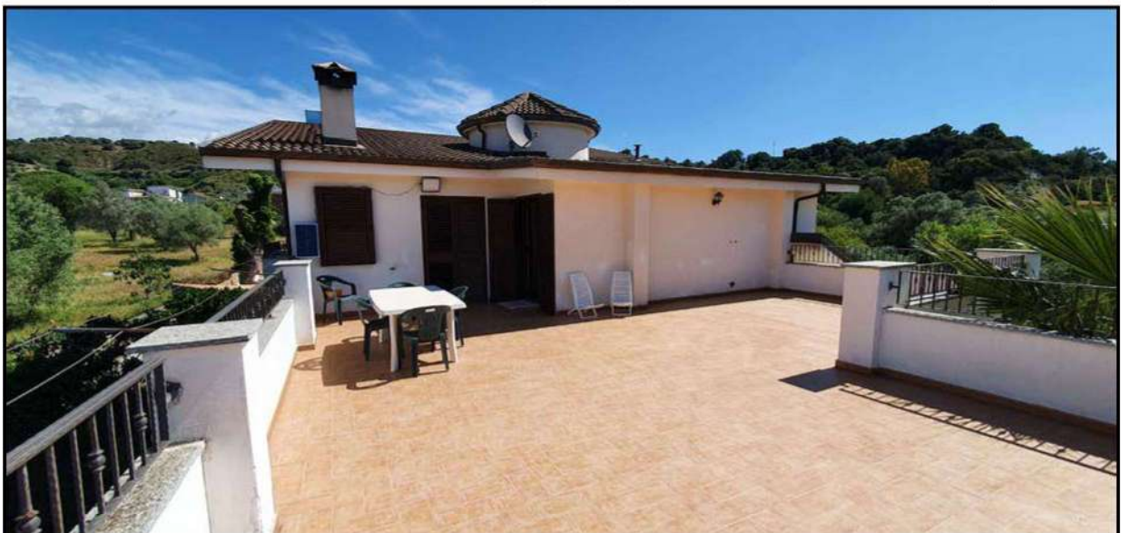
Vista terrazzo al piano primo identificato al sub 8 (ex sub 4)
