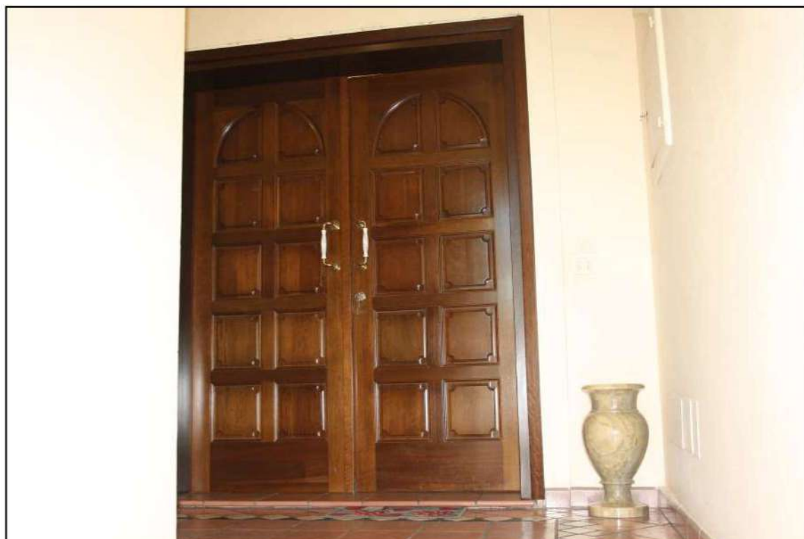
Foto 2 - Portone d'ingresso appartamento sub 38
