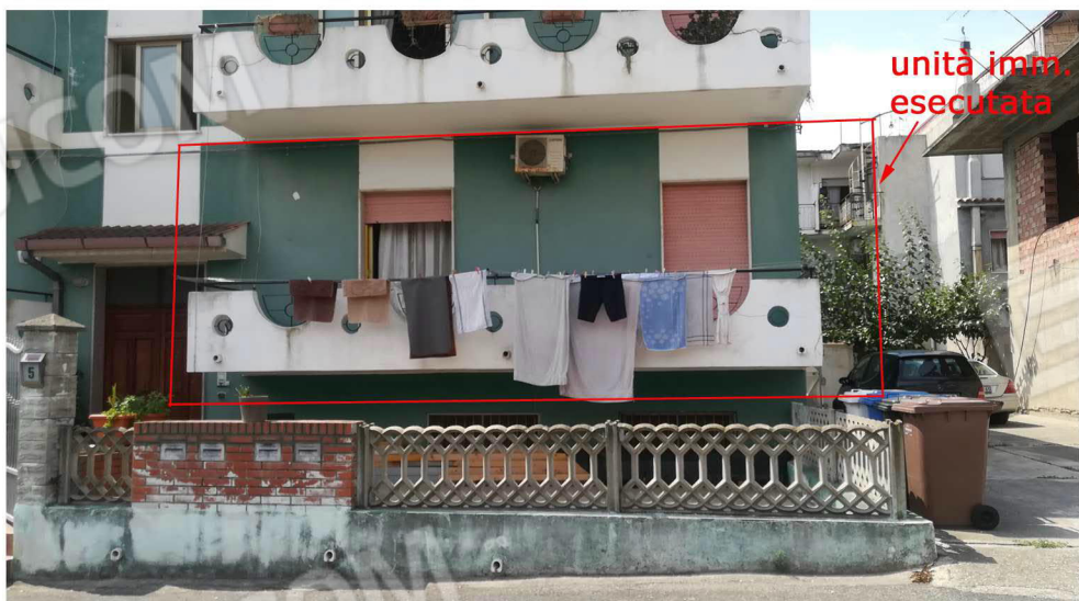
Foto 3 - Particolare facciata Plla 158 sub 3
