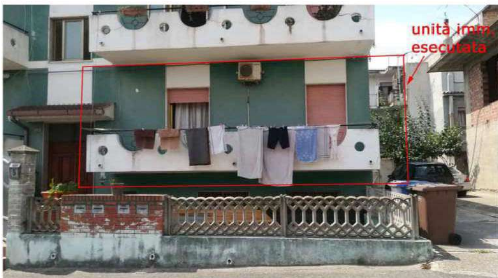
Foto 3 - Particolare facciata Plla 158 sub 3
