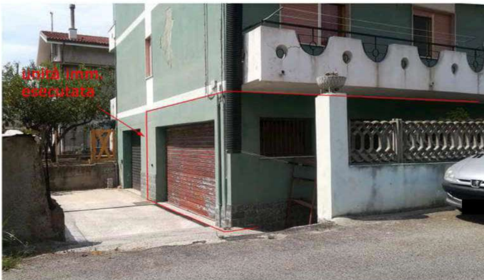
Foto 2 - Particolare ingresso Plla 158 sub 16
