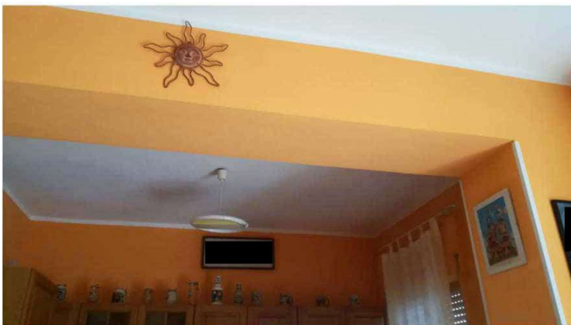
Foto 4 - Particolare architrave ambiente soggiorno/cucina/pranzo
