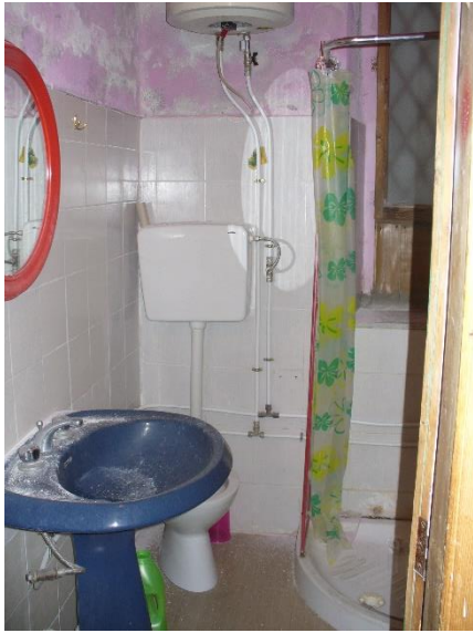
FOTO N. 34 – WC piano T sub 3–
