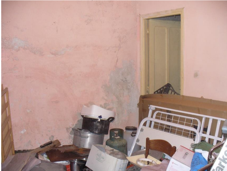
FOTO N. 32 – vano piano S1 sub 2-
