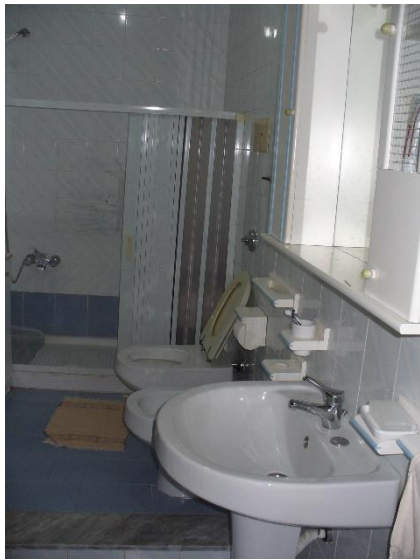
FOTO N. 32 – WC piano 1 sub 2-
