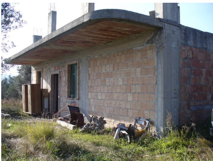
FOTO N. 37 –fabbricato ricadente sul terreno in esame –
