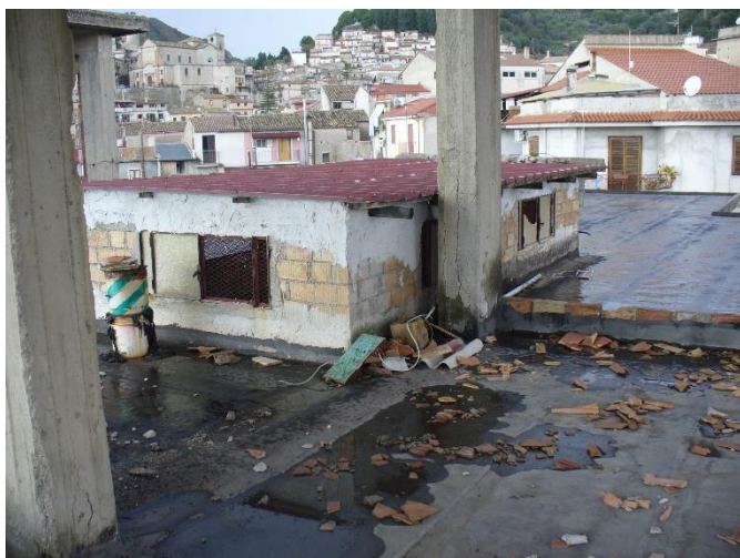
FOTO N. 55 – lastrico solare e manufatti -
