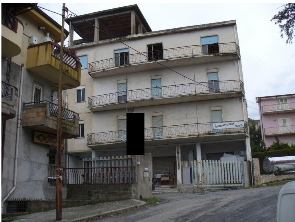
FOTO N. 1 – Prospetto fabbricato part. 1725 lato corte -
