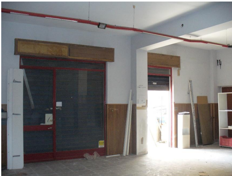
FOTO N. 3 – Piano terra fabbricato part. 1725 -interni –
