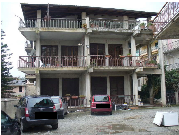
FOTO N. 11 – Prospetto fabbricato part. 1713 lato corte –
