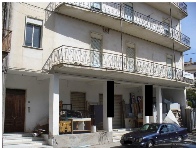
FOTO N. 2 – Piano terra fabbricato part. 1725 -portico sopraelevato - accessi –
