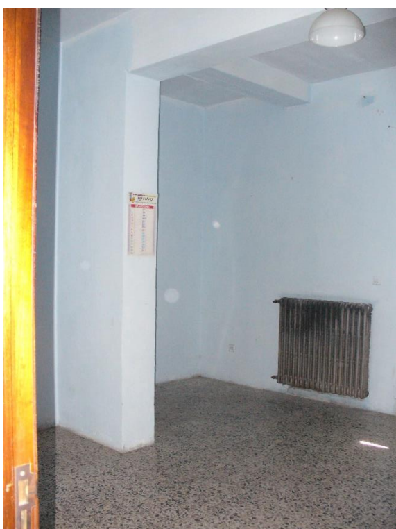
FOTO N. 7 – Piano secondo part. 1725 sub 4 -interni –
