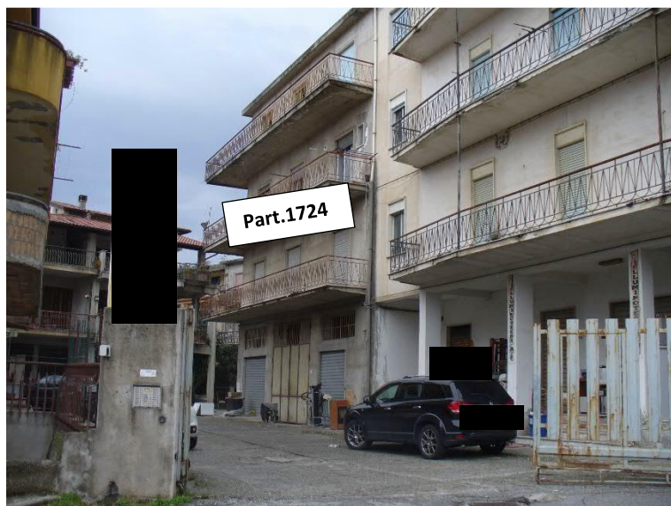
FOTO N. 41 – Prospetto fabbricato part. 1724 lato corte –
