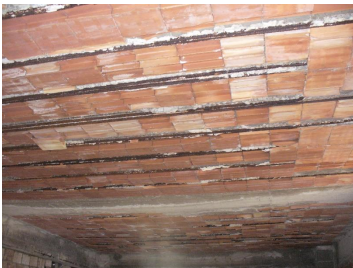
FOTO N. 40 –condizioni del solaio di copertura –
