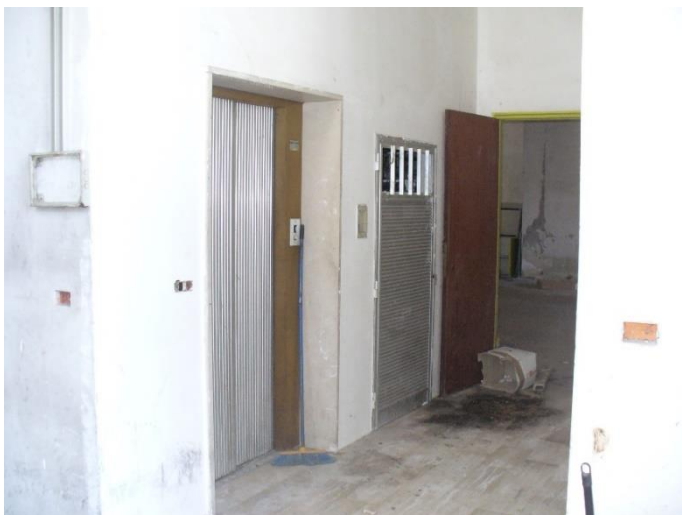
FOTO N. 43 – Piano terra vano scala-ascensore-
