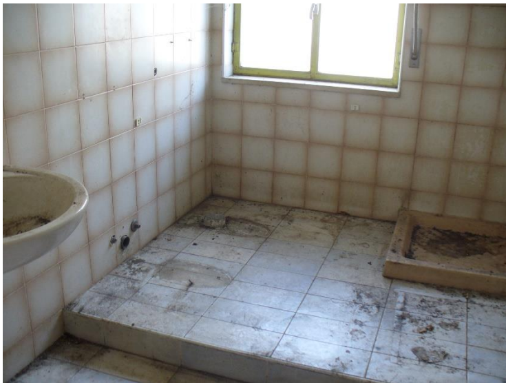
FOTO N. 6 – Piano secondo part. 1725 sub 3 -interni –
