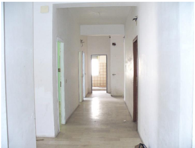
- FOTO N. 52 – corridoio disimpegno-
