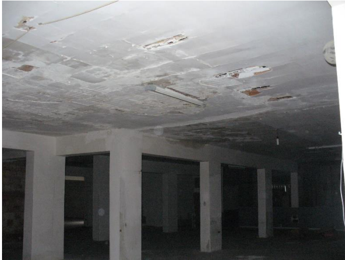
FOTO N. 49 – solaio di copertura piano primo-
