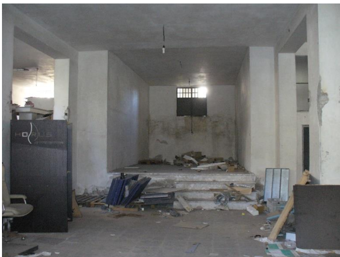
FOTO N. 46 – Interni del Piano terra-
