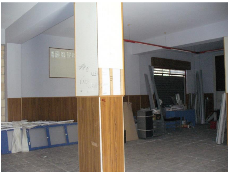
FOTO N. 3 – Piano terra fabbricato part. 1725 -interni –
