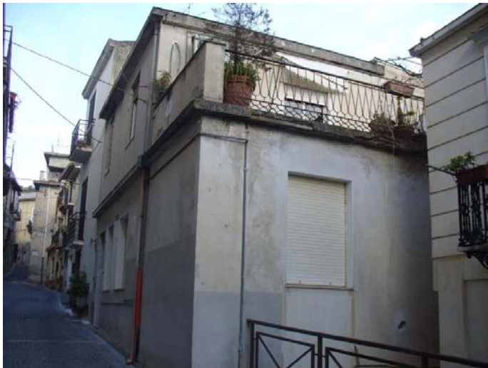
FOTO N. 24 – vista su via Cairoli –
