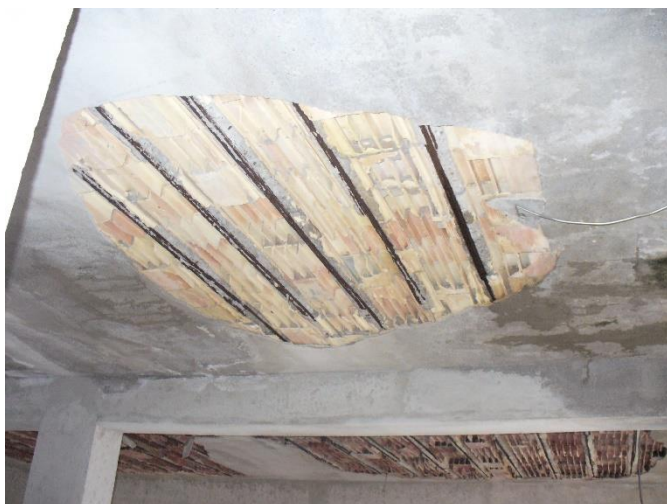
FOTO N. 57 – solaio di copertura -
