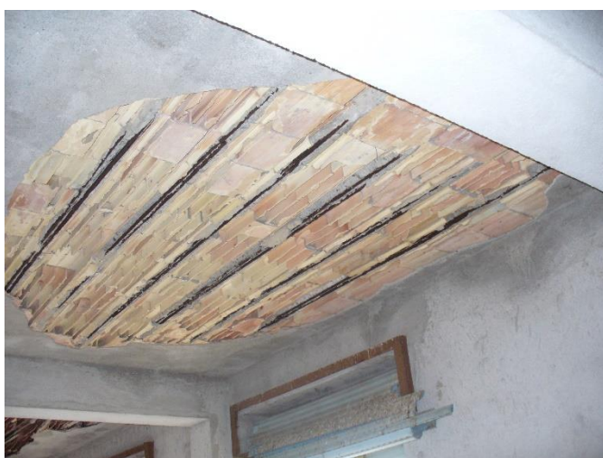
FOTO N. 56 – solaio di copertura -
