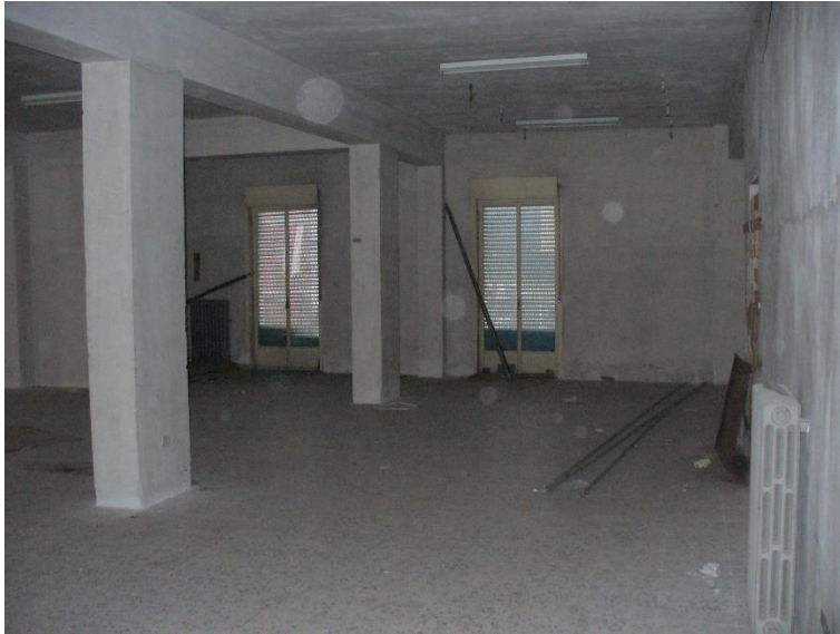
FOTO N. 4 – Piano primo fabbricato part. 1725 sub 2 -interni –
