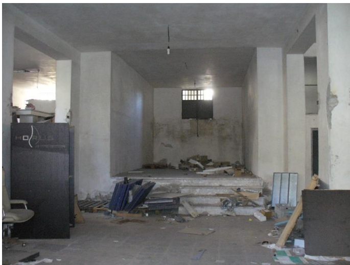
FOTO N. 45 – Interni del Piano terra-
