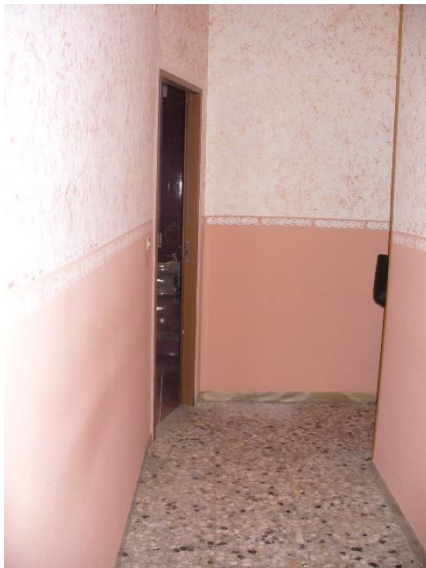
FOTO N. 25 – interni sub 2 PT–
