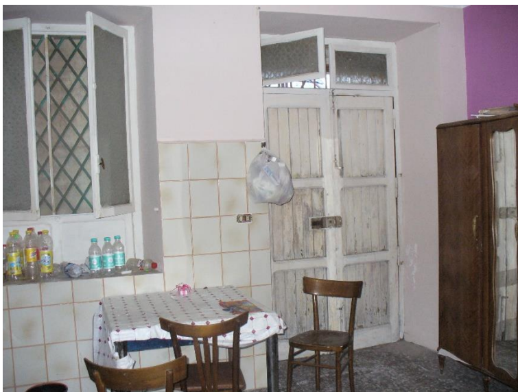
FOTO N. 31 – vano piano S1 sub 2–
