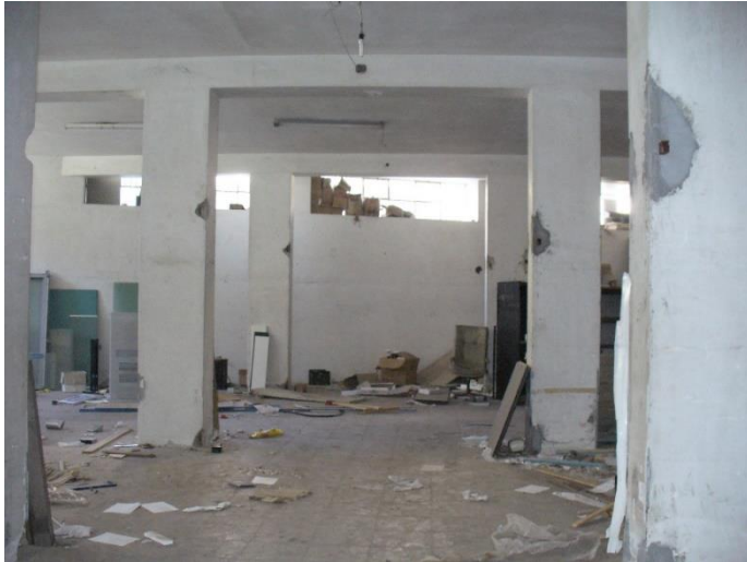
FOTO N. 44 – Interni del Piano terra-
