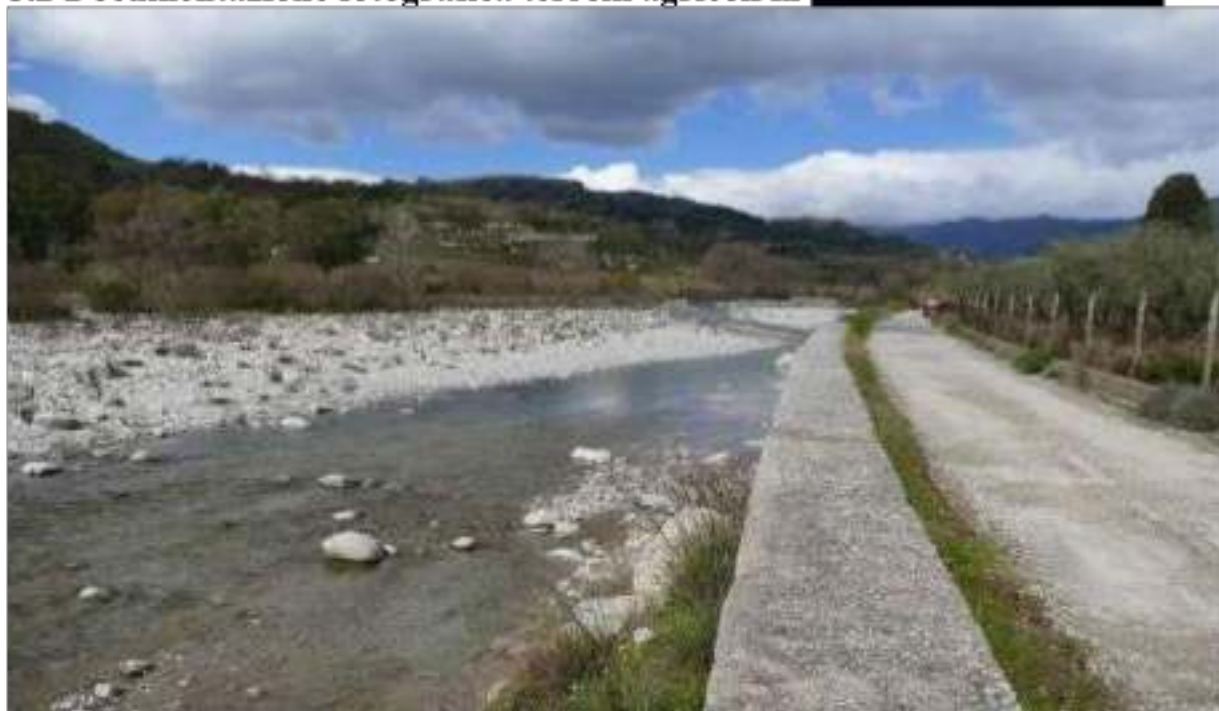
Rapp. Fotografica alveo torrente [REDACTED] e strada sterrata al confine dei Terreni agricoli (F. [REDACTED]) Comune di [REDACTED]
