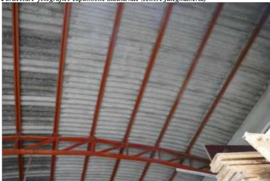
Particolare fotografico capannone industriale (strutture di copertura)
