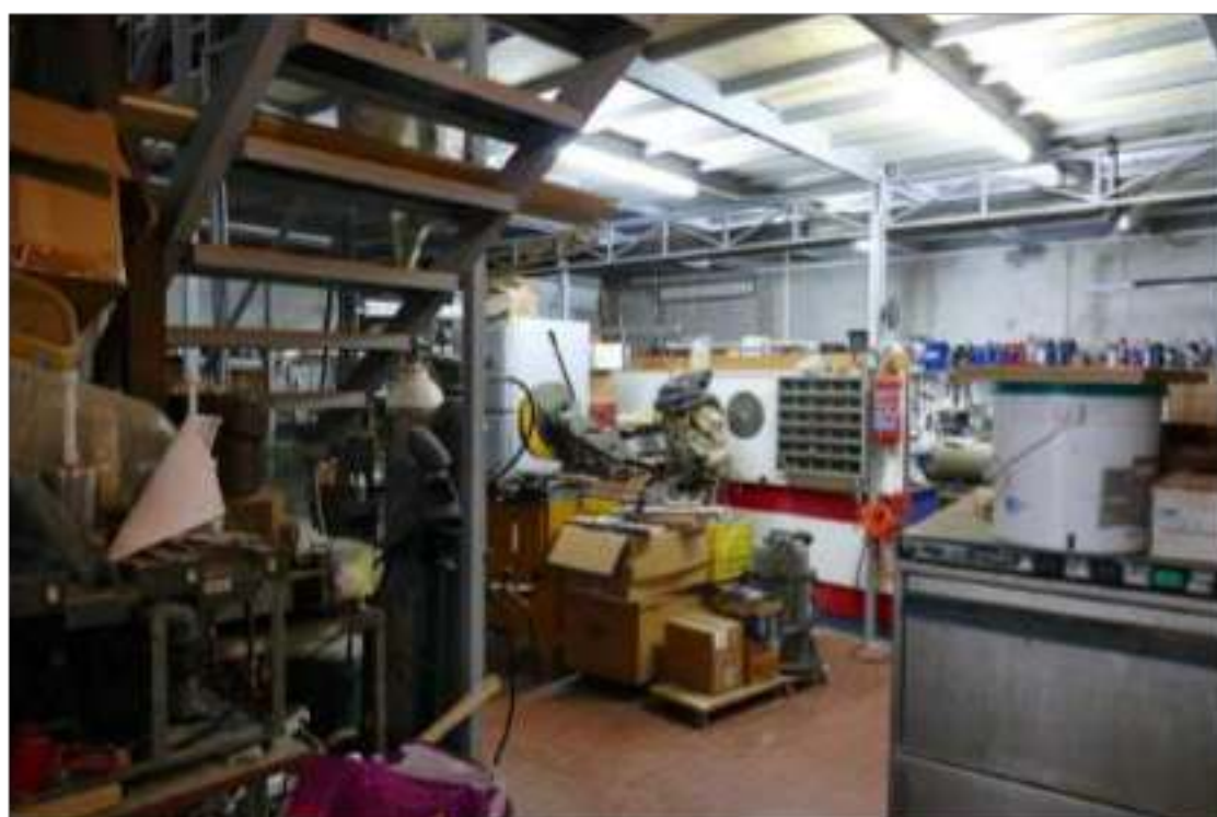
Particolare fotografico interno capannone industriale (settore laboratorio tecnologico)
