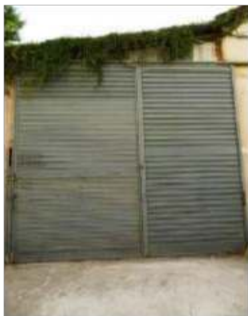
Part. fotografico corpo aggiunto al capannone
