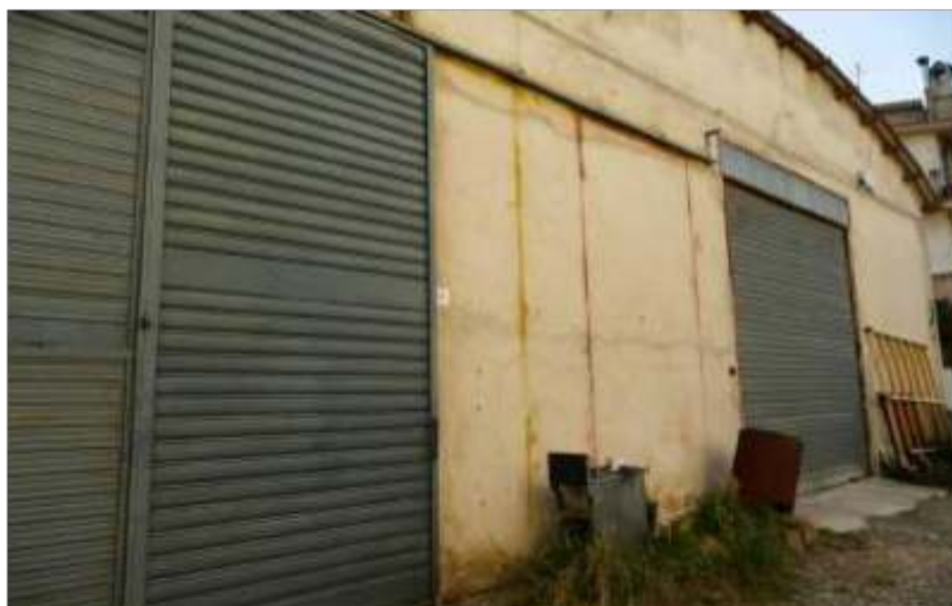
Particolare fotografico locale adiacente (serranda ingresso)
