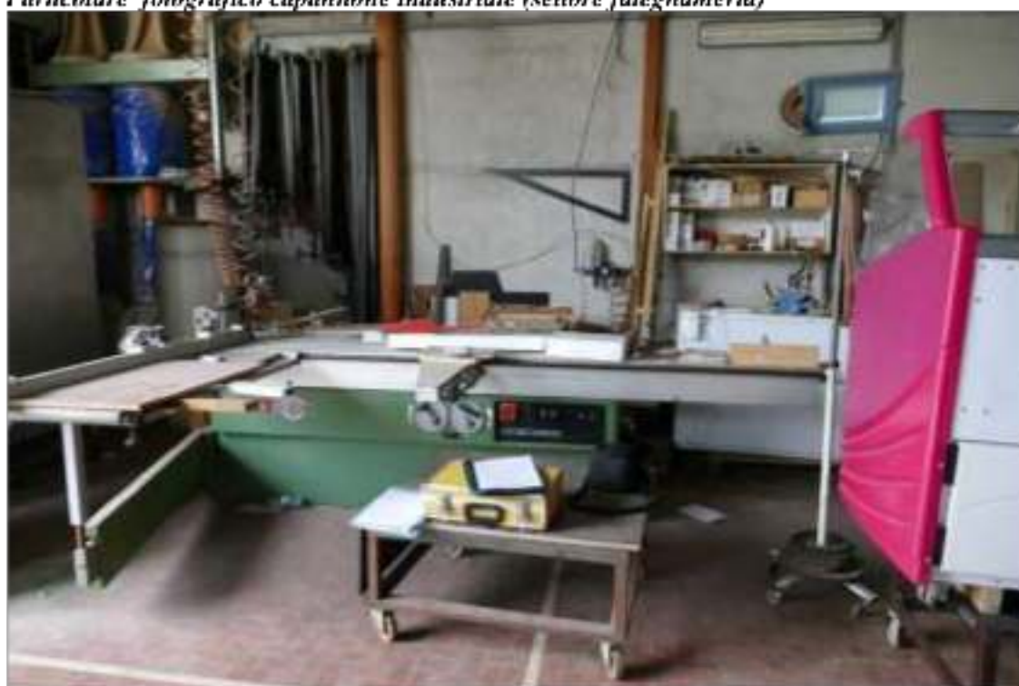
Particolare fotografico capannone industriale (settore falegnameria)
