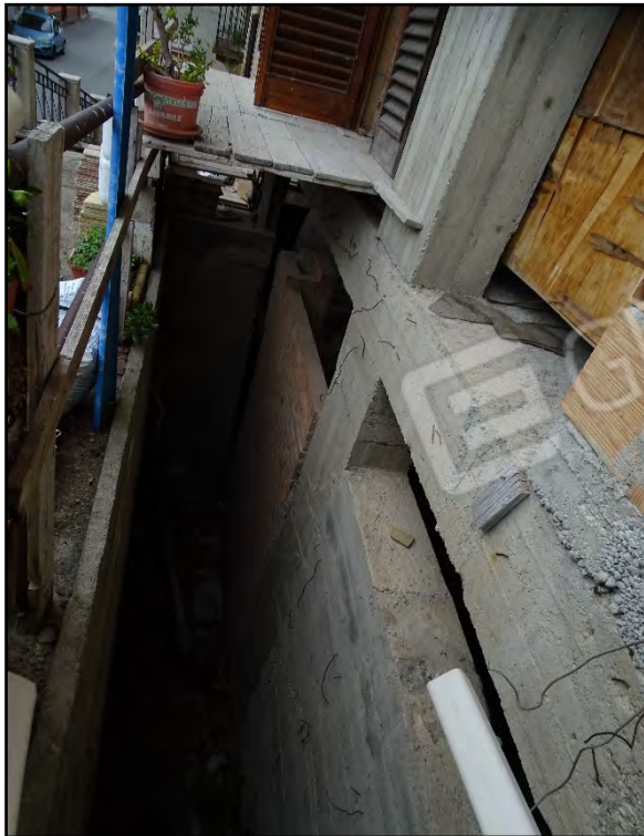
Imm. 5 - Quota ingresso Scannafosso. Si vede il ballatoio, Imm. 6 - Quota piano interrato. Scannafosso Ballatoio in tavole da carpenteria di accesso al piano terra.
