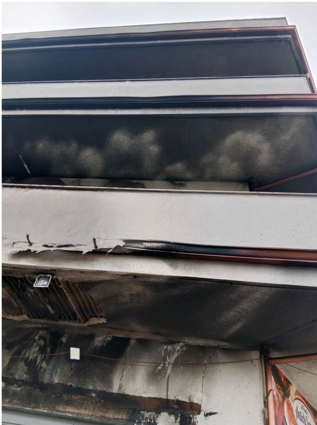
Solaio interessato da eventi di crollo
