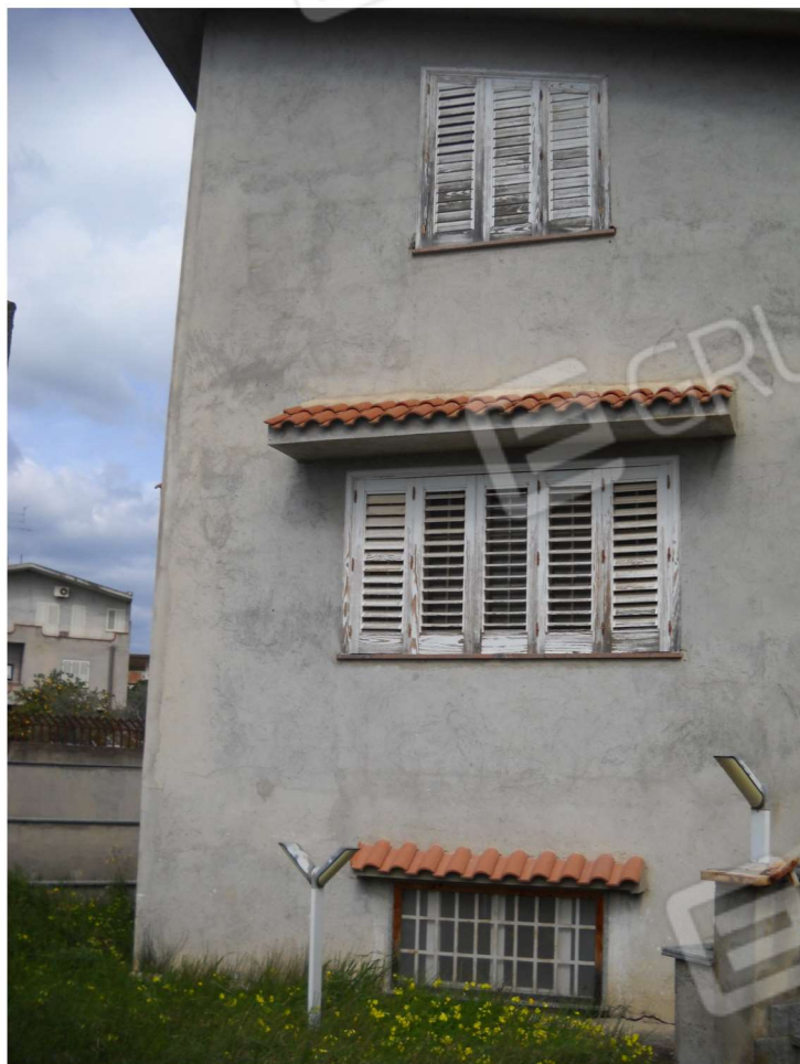
foto n. 1 – fabbricato particella 867 dalla corte
