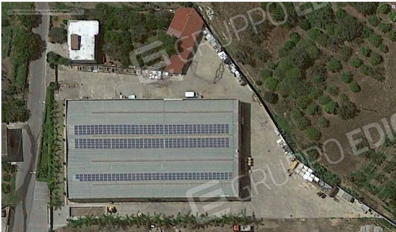
VISTA ESTERNA PARTICELLA 631 SUBALTERNO 2 (IMPIANTO FOTOVOLTAICO) E SUBALTERNO 3 (PIANTACOPERTURA)
