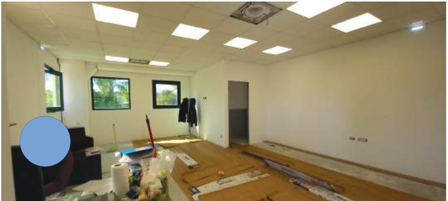
Figura 29: vista ufficio piano terra
