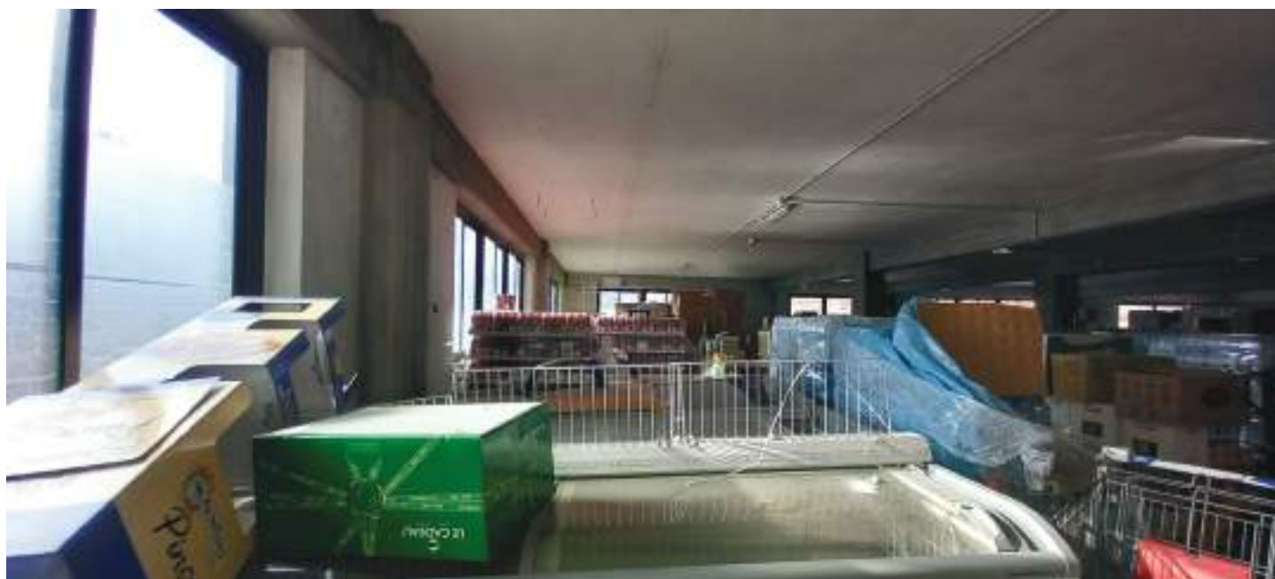
Figura 63: vista della zona deposito al piano primo (sub 3)
