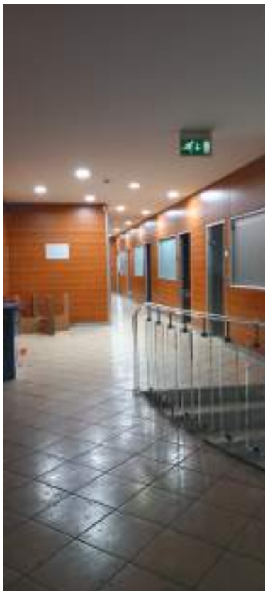
Figura 20: vista del disimpegno 1 al piano primo
