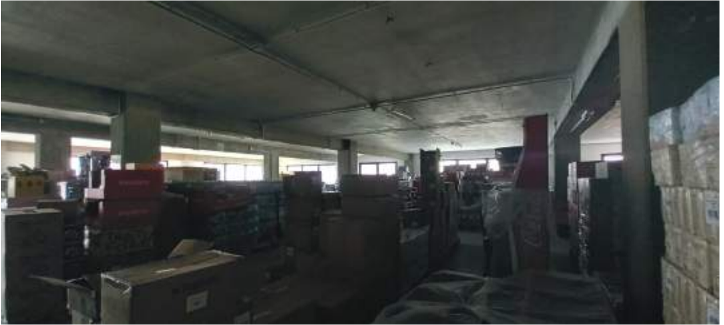
Figura 64: vista della zona deposito al piano primo (sub 3 e sub 8)
