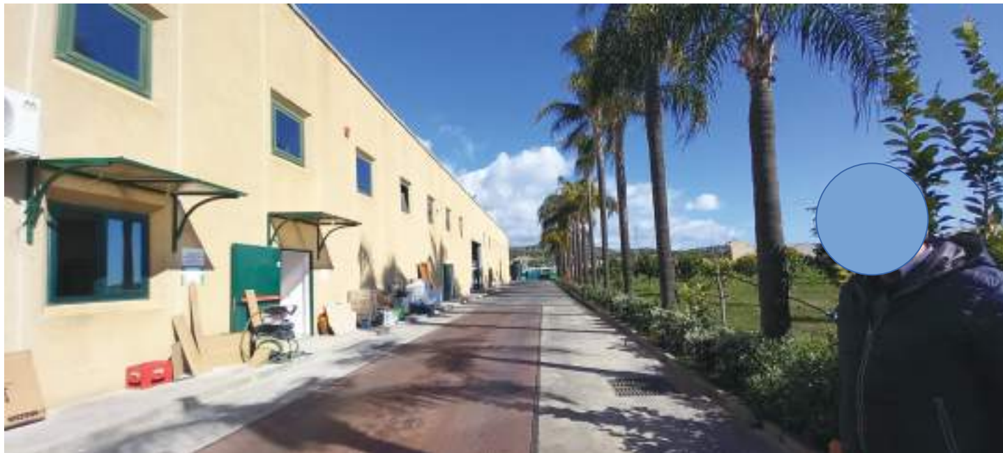
Figura 5: vista esterna del cespite ingresso al piazzale della [REDACTED]
