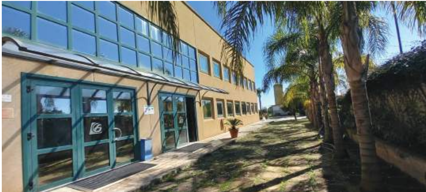
Figura 6: vista esterna del cespite, ingresso alla reception di [REDACTED] (sub 4), lato sud - ovest
