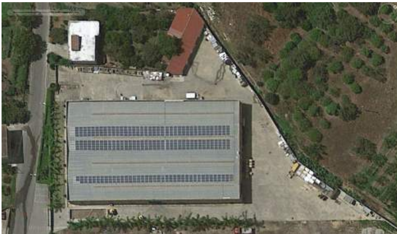
Figura 10: vista della pianta copertura (sub 3) con l'impianto fotovoltaico (sub 2)
