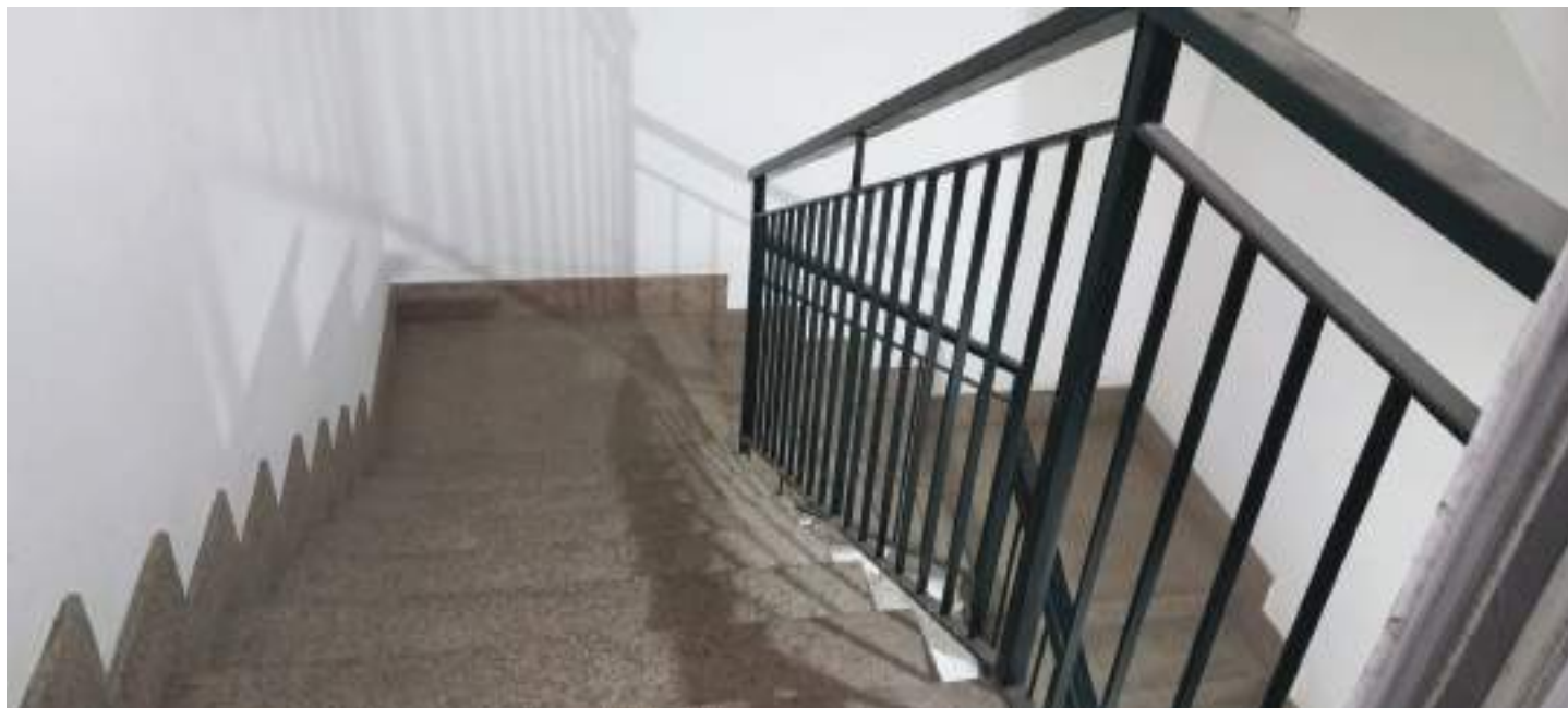
Figura 60: vista della scala 1 che scende al piano interrato (subalterno 30)
