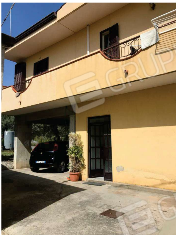
Particolare fotografico immobile a PT – Ingresso
