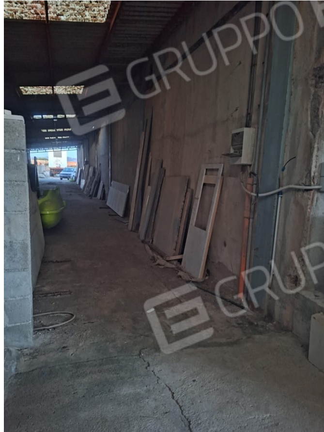
Foto 25 , 26 – TETTOIA ingresso al capannone lato destro
