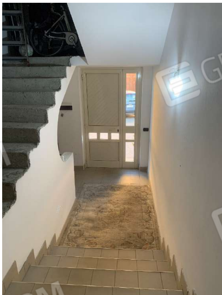
Ingresso e vano scala
