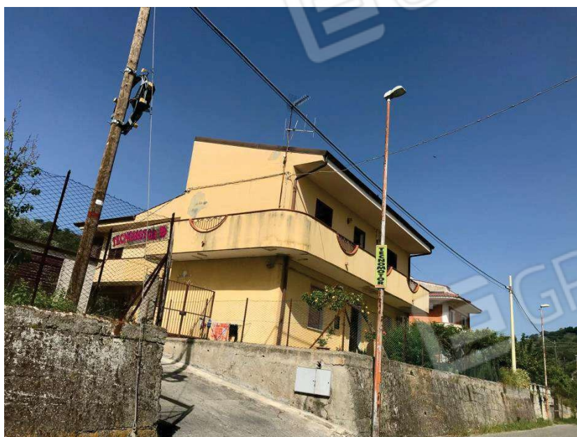
Veduta fotografica prospettica - Comune
