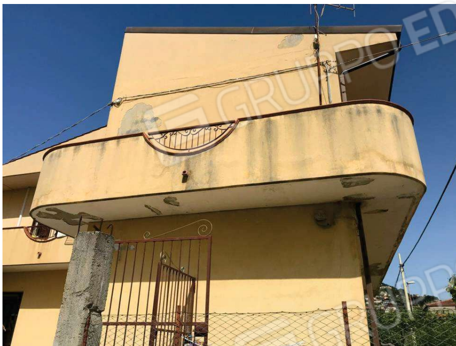
Particolare fotografico immobile a PT – Ingresso
