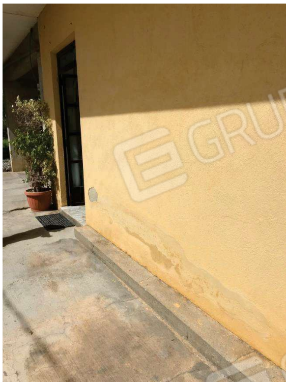
Particolare fotografico immobile a PT – Ingresso
