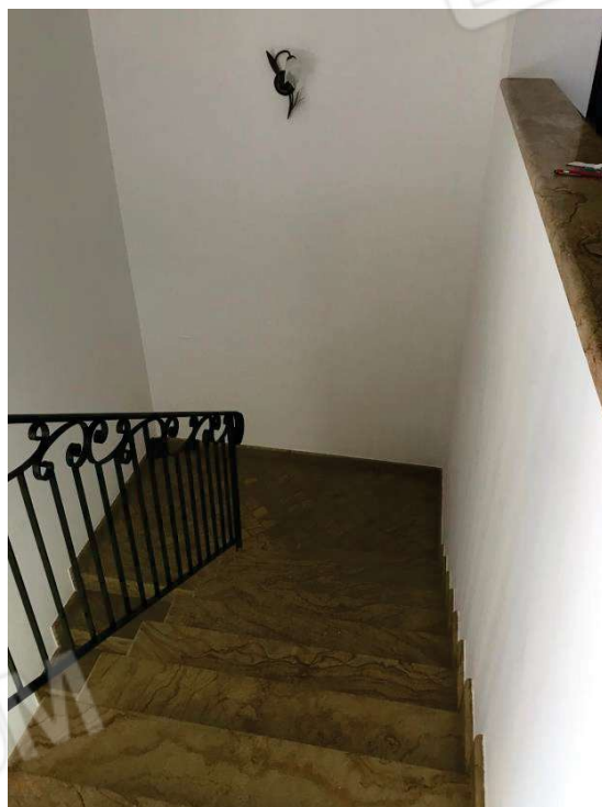
Particolare fotografico scala accesso all'immobile a Piano I°
