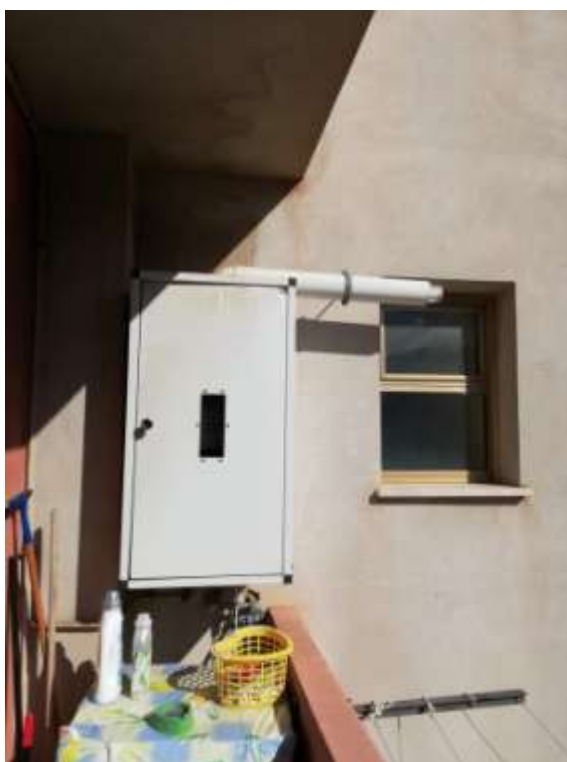
Foto 13: Balcone con affaccio sul prospetto secondario
