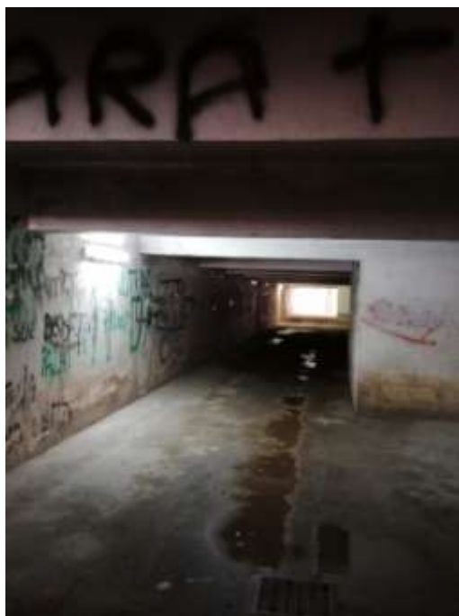
Foto - 3: Tunnel coperto per accedere al locale garage
