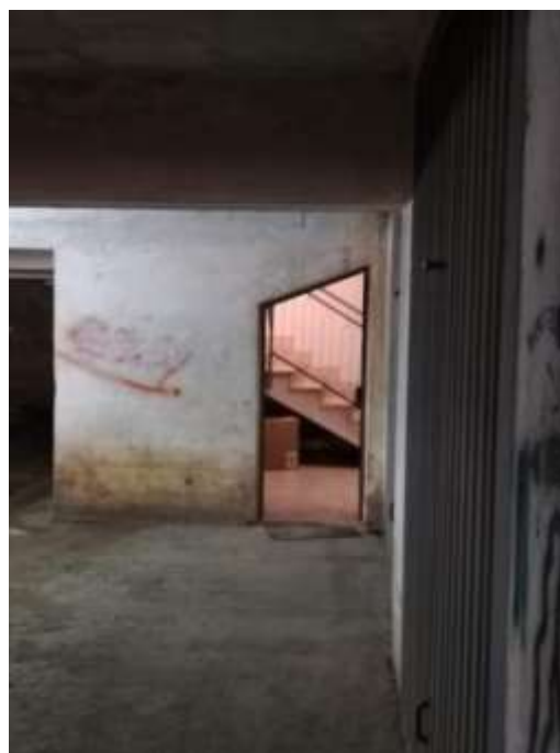
Foto 4: Accesso pedonale dal vano scala ascensorato
