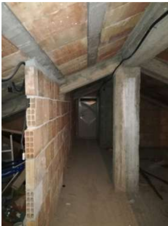
Foto 15: corridoio di accesso al locale cantina posizionato nel sottotetto del fabbricato
