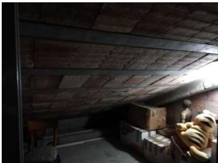
Foto 16: Locale cantina d rifinire e sanare una porzione di ampliamento che occupa il corridoio.
