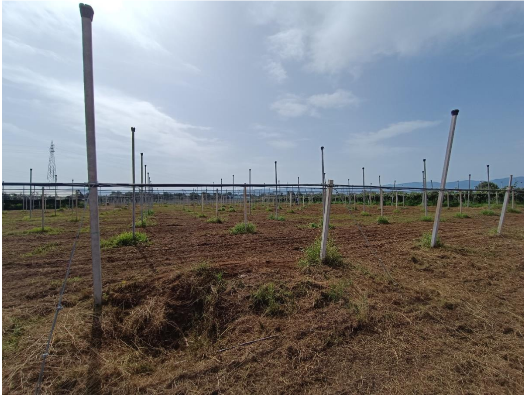
Foto 5: Catasto Terreni di Rizziconi, foglio 40, particella 143 – struttura di sostegno a servizio di un nuovo impianto frutticolo da allevare a tendone.
