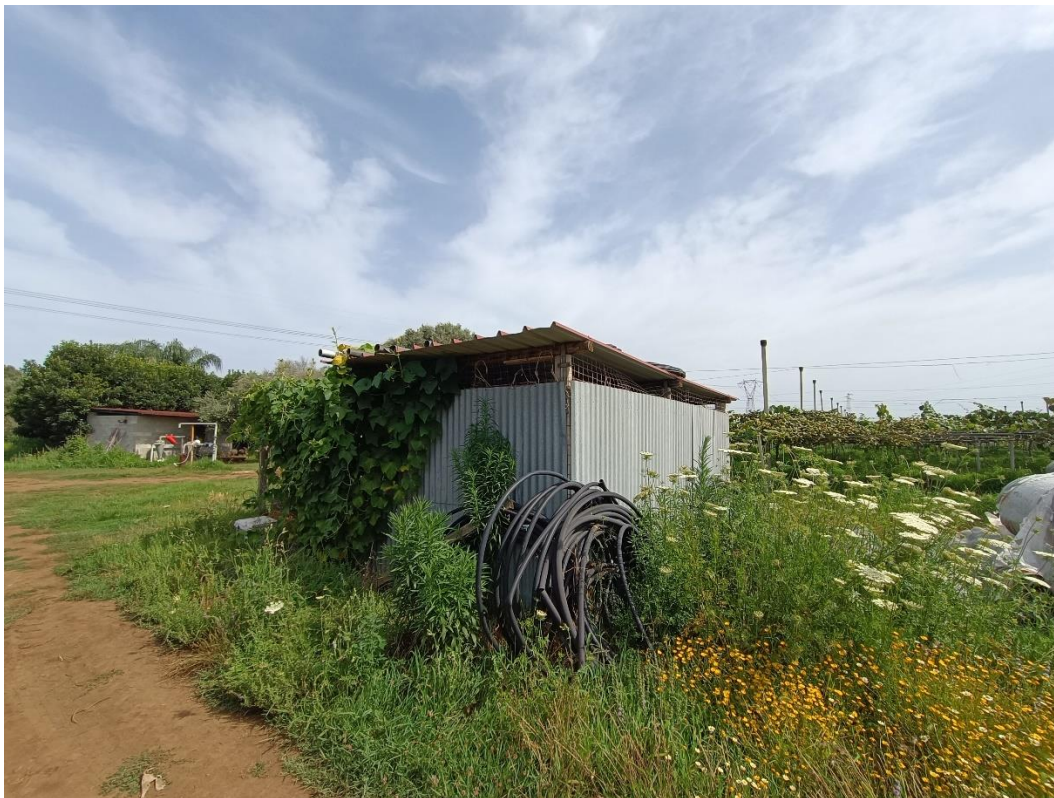
Foto 8: baracca posizionata lungo il margine nord della particella 145.
