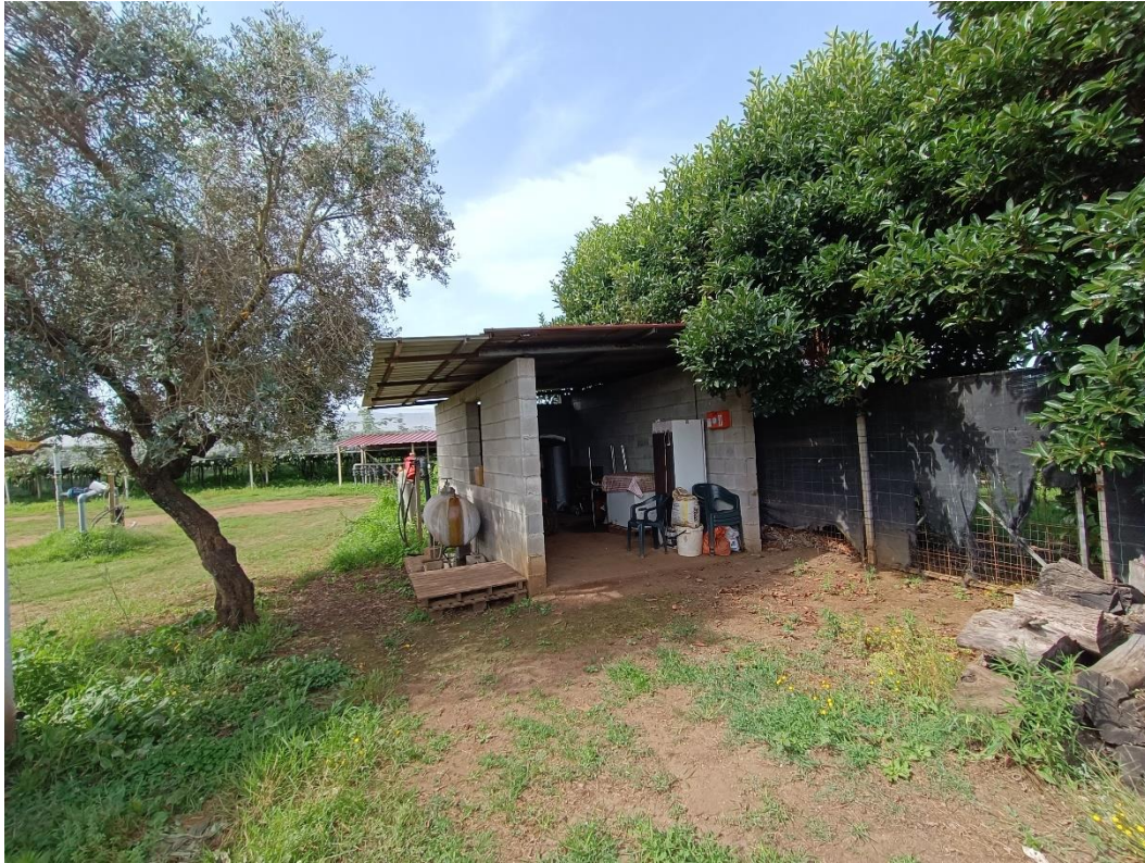
Foto 9: deposito posizionato sulle particelle 145 e 144, lungo il confine con la particella 126.
