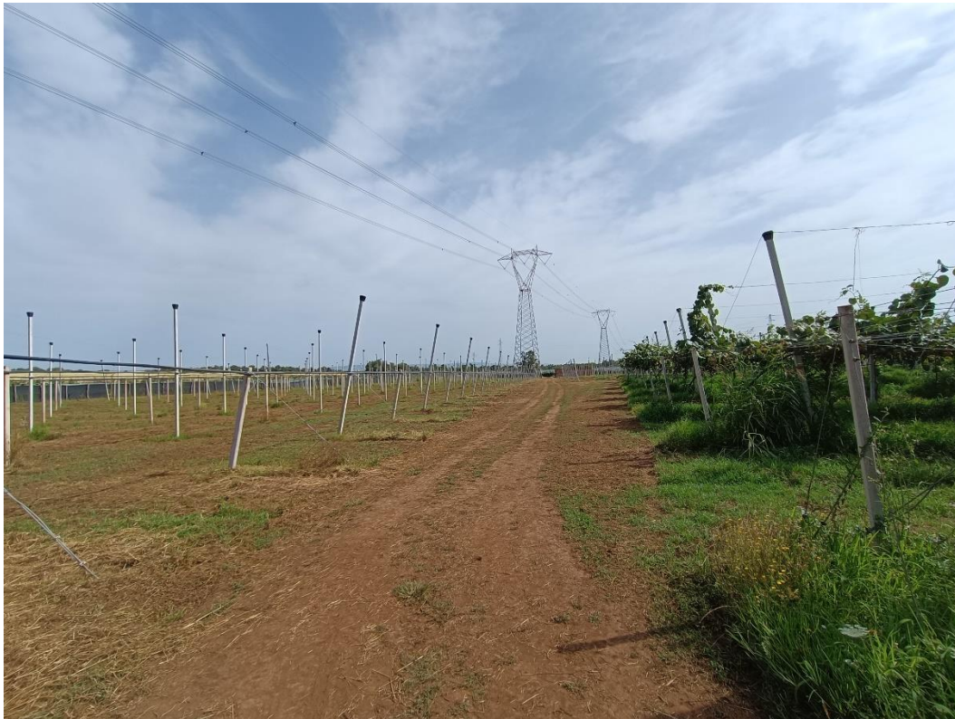
Foto 4: Catasto Terreni di Rizziconi, foglio 40, particelle 142 e 71 – struttura di sostegno a servizio di un nuovo impianto frutticolo da allevare a tendone.
