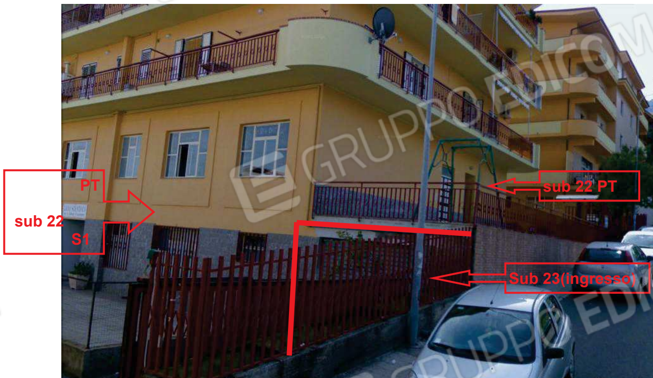
FOTO 17 – Particella 674 subalterni 22 e 23 (originario sub 21) – vista dalla via Arena
