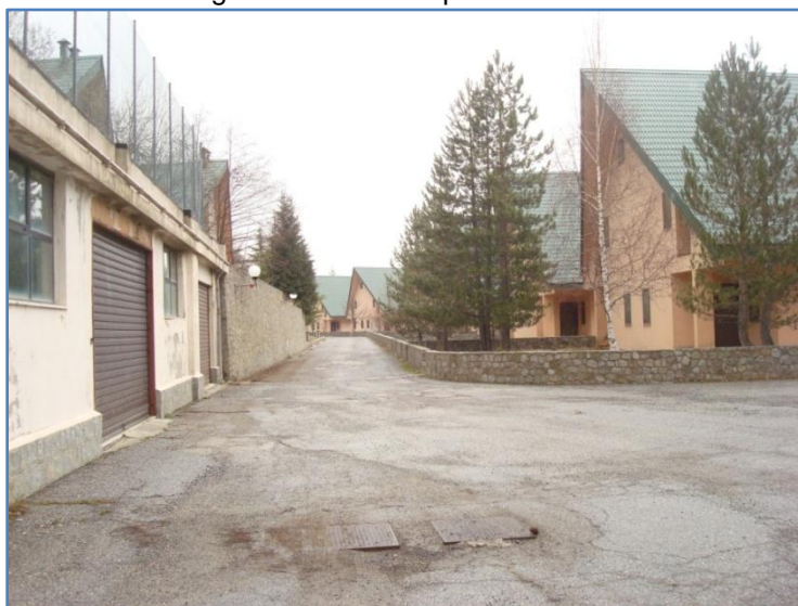
- Ingresso ai locali deposito -
