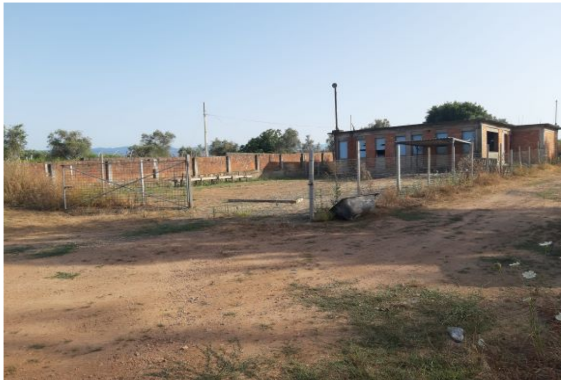
Il Paddock in rete elettrosaldata esterno al fabbricato
