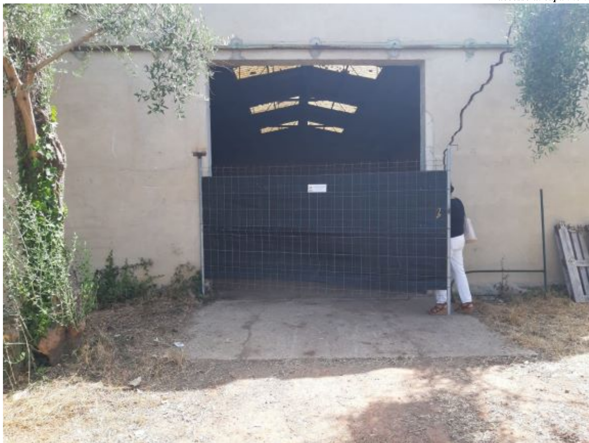
L'accesso al capannone
