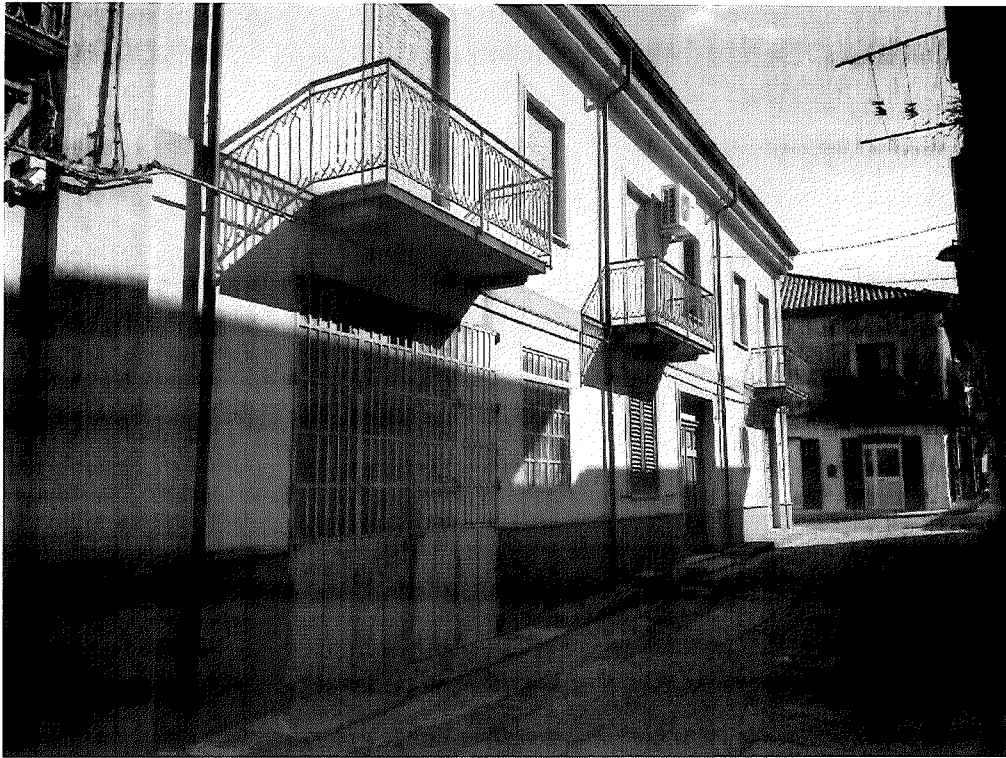
Foto 1: Catasto Fabbricati di Citanova, foglio 73, particella 1237 sub 1, via Santa Caterina. Autorimessa al piano terra.
