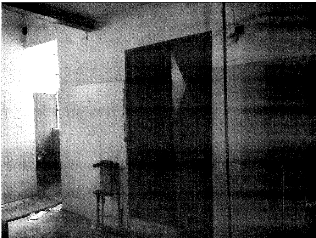
Foto 6: Catasto Fabbricati di Cittanova, foglio 73, particella 1428 sub 1 – porta al piano terra comunicante con altra unità immobiliare.
