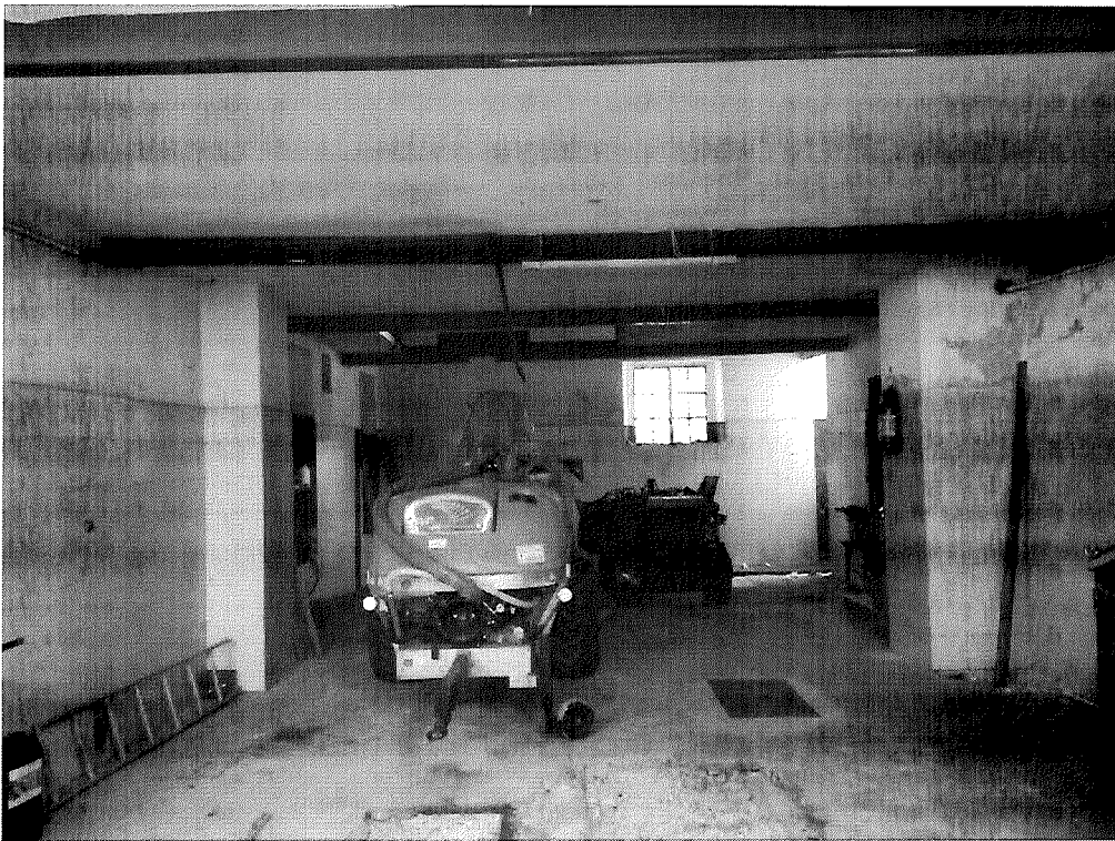
Foto 3: Catasto Fabbricati di Cittanova, foglio 73, particella 1428 sub 1 – interno del piano terra.
