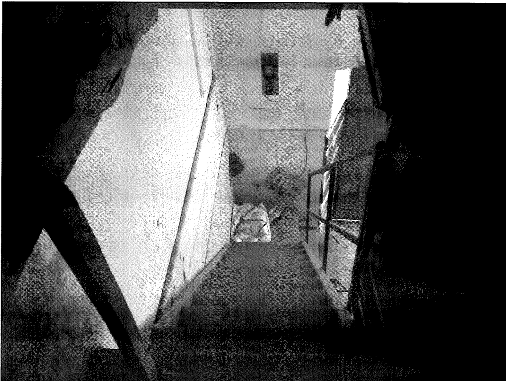
Foto 5: Catasto Fabbricati di Cittanova, foglio 73, particella 1428 sub 1 – scala d'accesso al soppalco.
