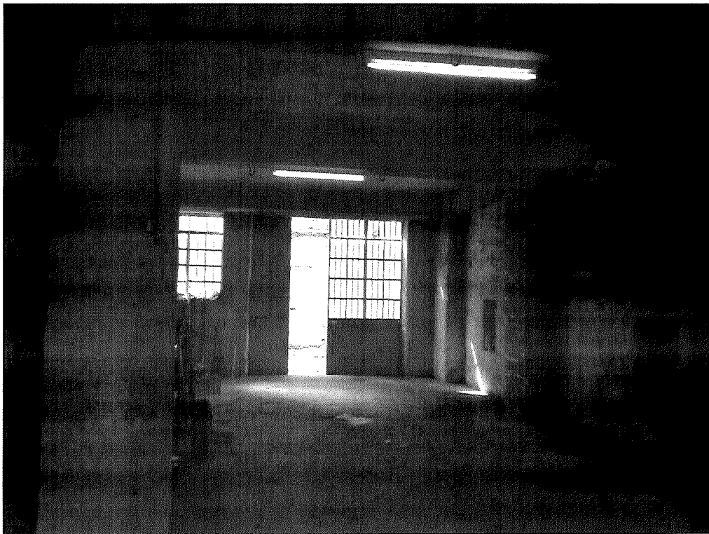
Foto 3: Catasto Fabbricati di Cittanova, foglio 73, particella 1237 sub 1, via Santa Caterina. Interno dell' autorimessa.
