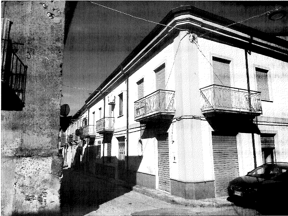
Foto 1: Catasto Fabbricati di Cittanova, foglio 73, particella 1237 sub 3, via Santa Caterina angolo via Roma. Abitazione su tre livelli.
