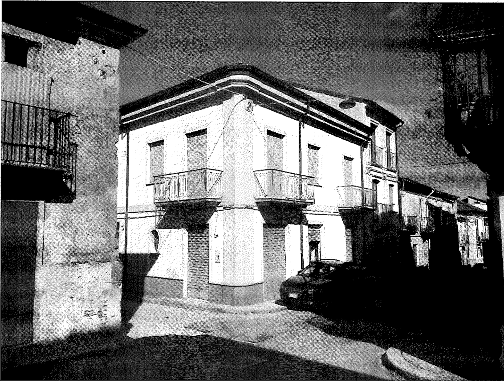
Foto 1: Catasto Fabbricati di Cittanova, foglio 73, particella 1237 sub 200, via Roma. Laboratorio al piano terra.
