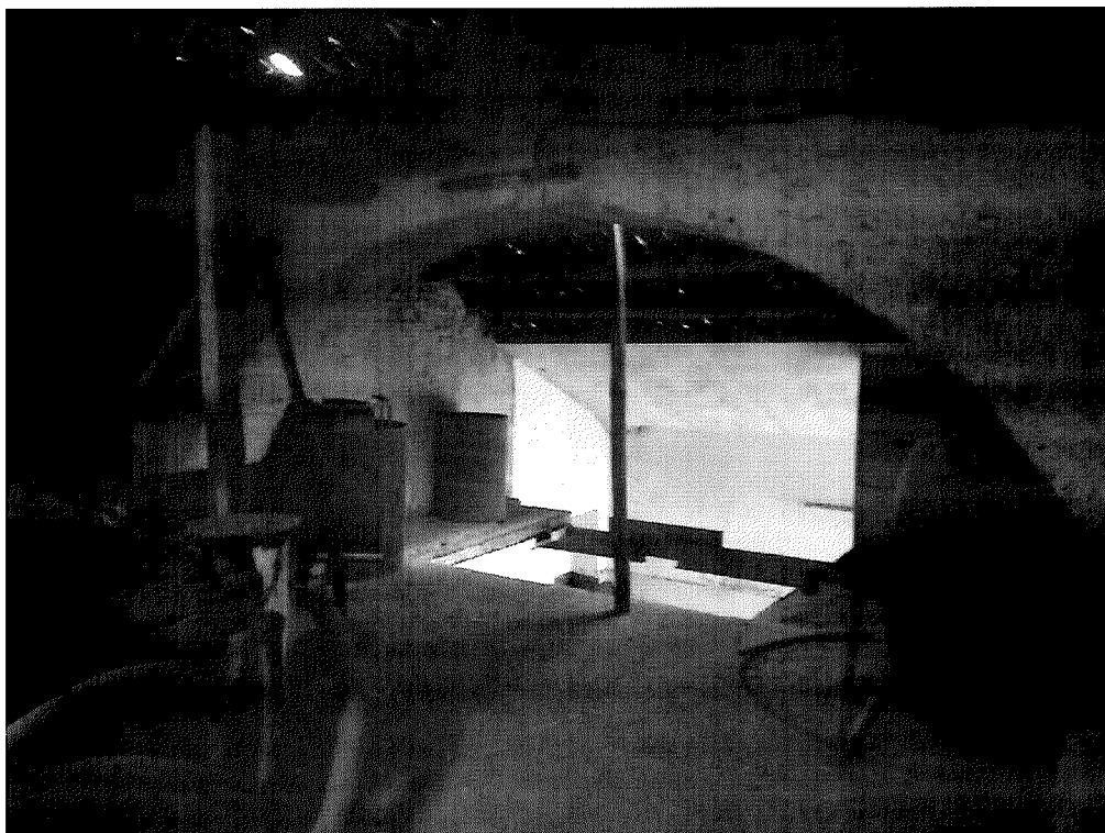
Foto 4: Catasto Fabbricati di Cittanova, foglio 73, particella 1428 sub 1 – soppalco.
