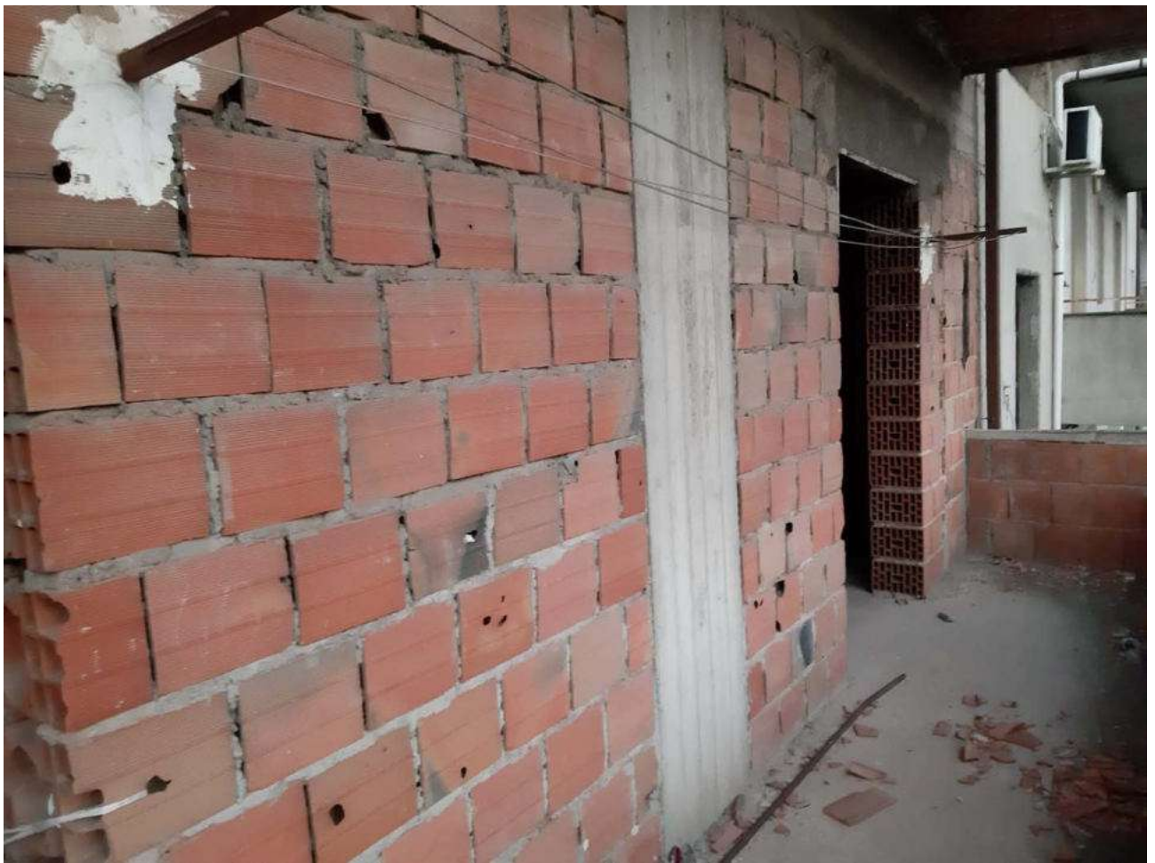
LOTTO 008 – FOTO 5 – La balconatura sulla facciata principale
