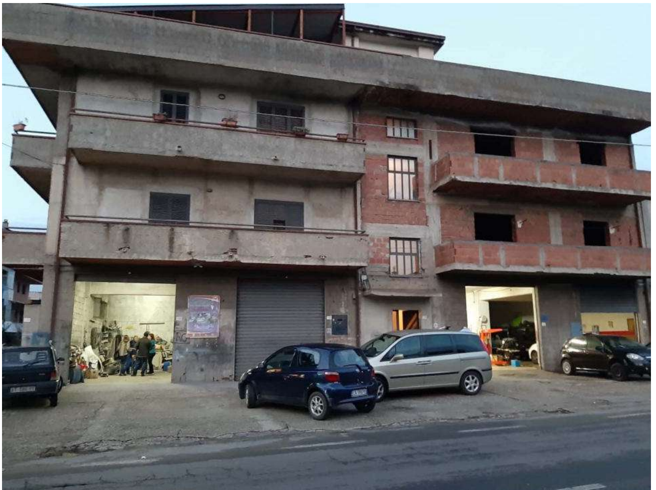
LOTTO 005– FOTO 1 – Vista d’insieme del fabbricato
