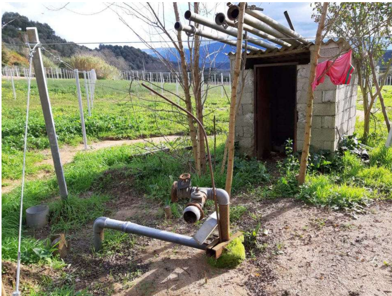
LOTTO 004 – FOTO 3 – Il manufatto di servizio al pozzo aziendale
