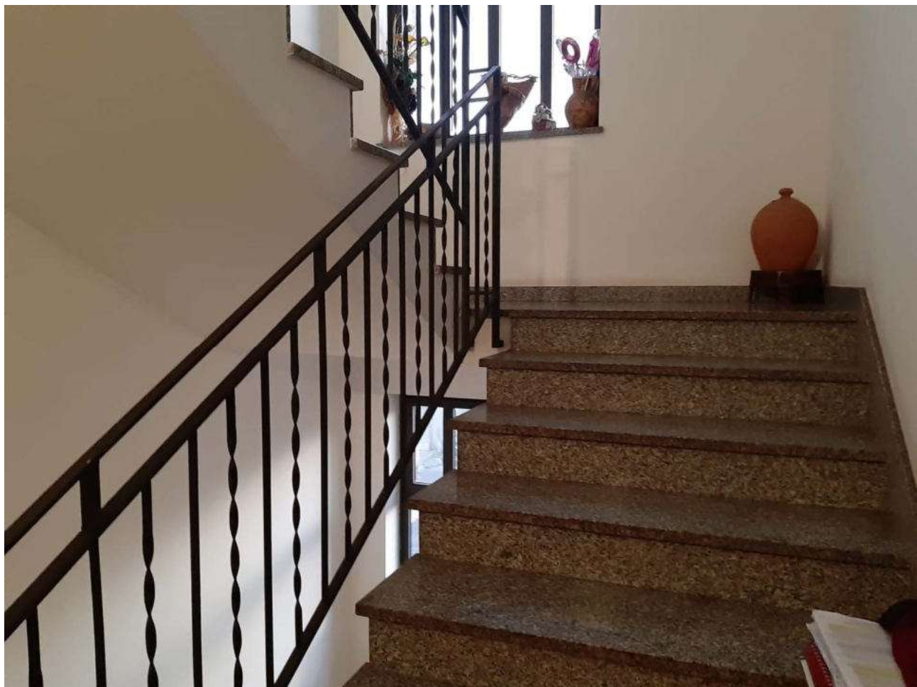
LOTTO 006 – FOTO 1 – Il vano scale che serve l'accesso
