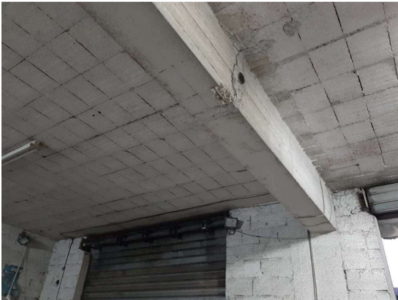
LOTTO 005 – FOTO 3 – La rusticità delle superfici murarie e del soffitto
