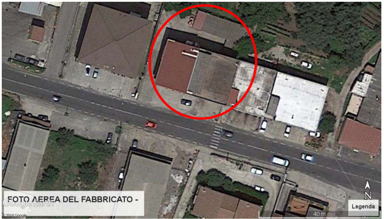
IL FABBRICATO RILEVATO CON GOOGLE EARTH
