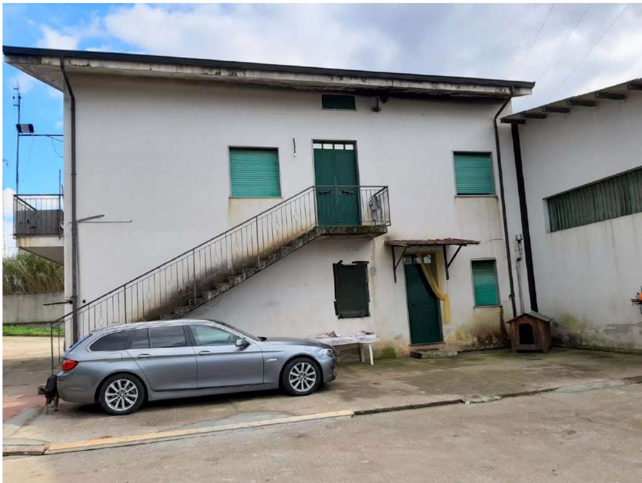
LOTTO 002 – FOTO 3 – Ingressi della struttura abitativa
