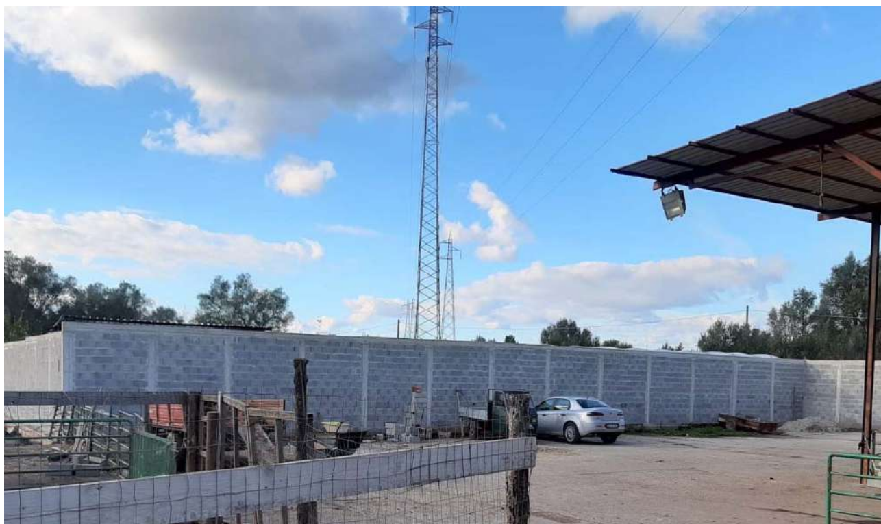
LOTTO 002 – FOTO 6 – Muratura divisoria in blocchi di calcestruzzo e le servitù di elettrodotto che attraversano il complesso
