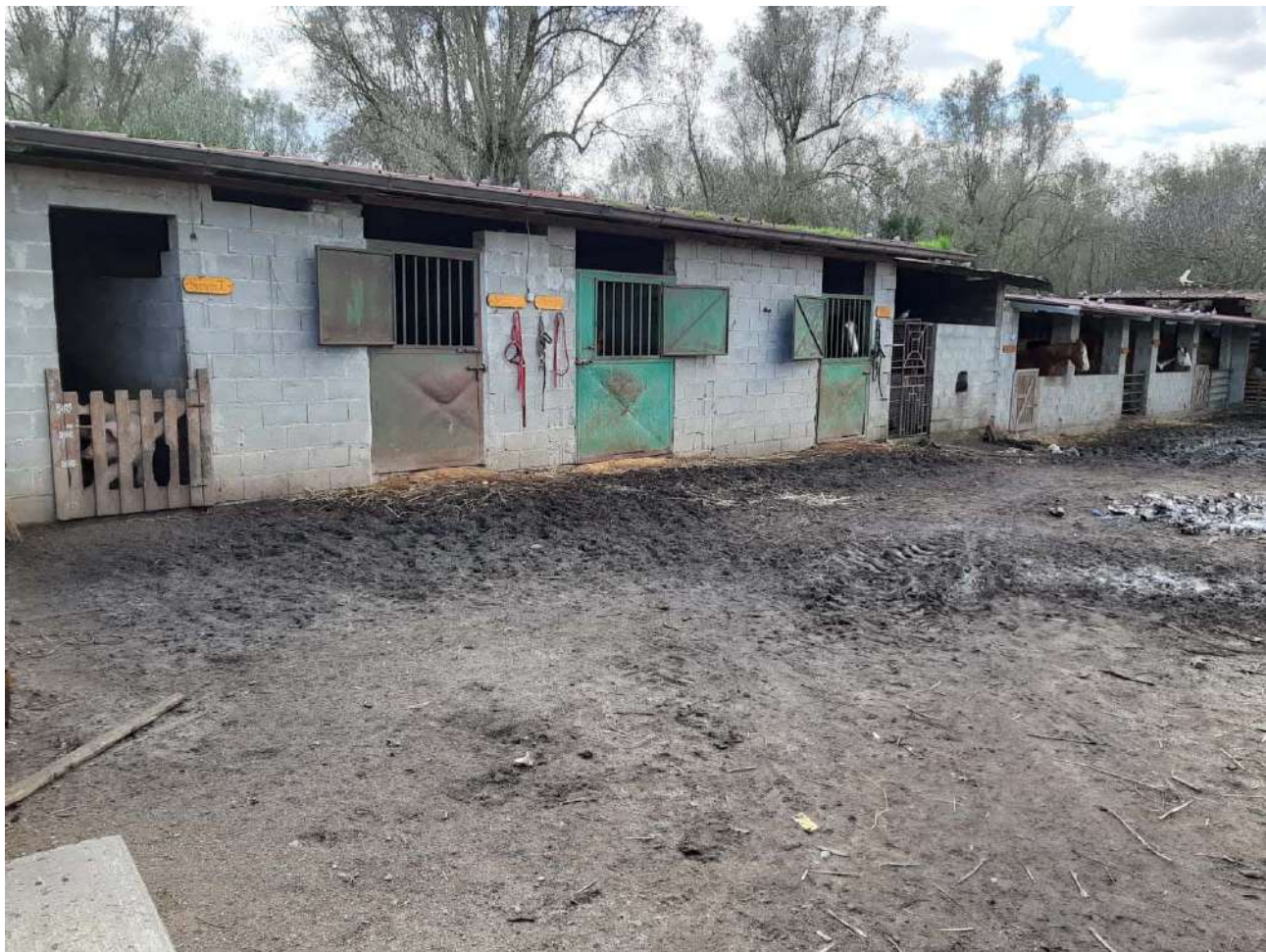
LOTTO 002 – FOTO 9 – box e paddok per allevamento equino adiacenti al muro delimitante il complesso a Sud
