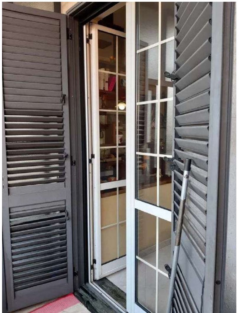
LOTTO 007 – FOTO 10 – Particolare degli infissi esterni
