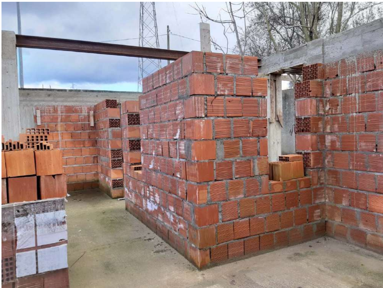
LOTTO 002 – FOTO 15 – Predisposizione per la veranda sul lato sud della dependance
