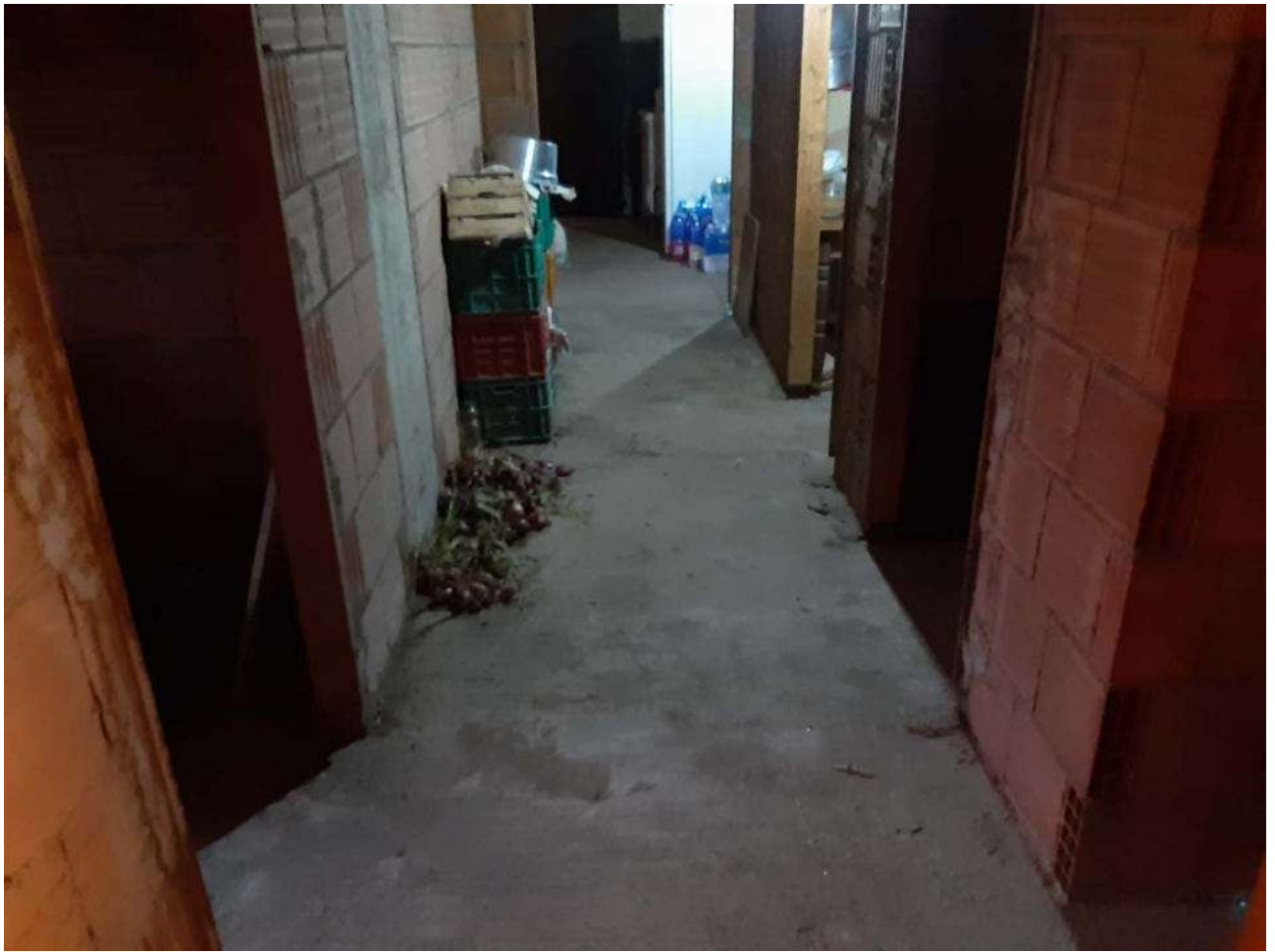
LOTTO 008 – FOTO 1 – L'interno dell'appartamento in costruzione
