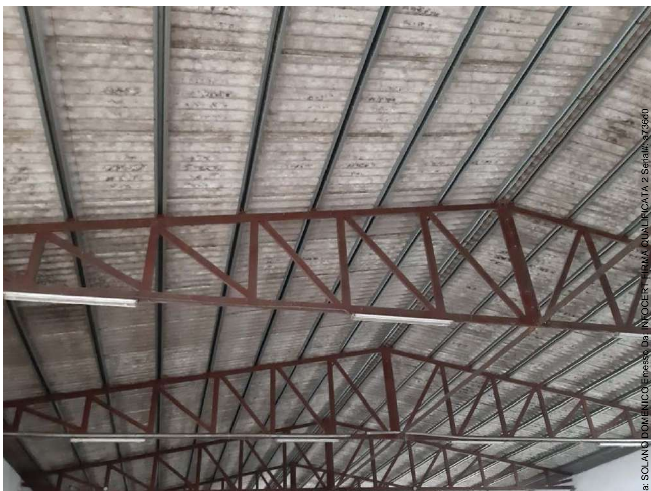
LOTTO 002 – FOTO 18 – Particolare del tetto, con struttura in profilato metallico e tamponatura in eternit
