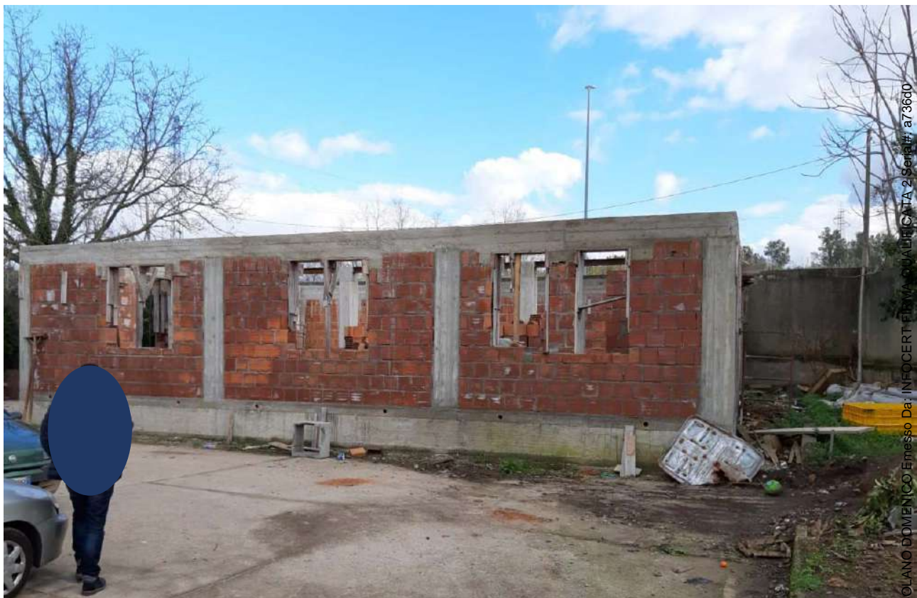
LOTTO 002 – FOTO 16 – Vista del lato Ovest della struttura
