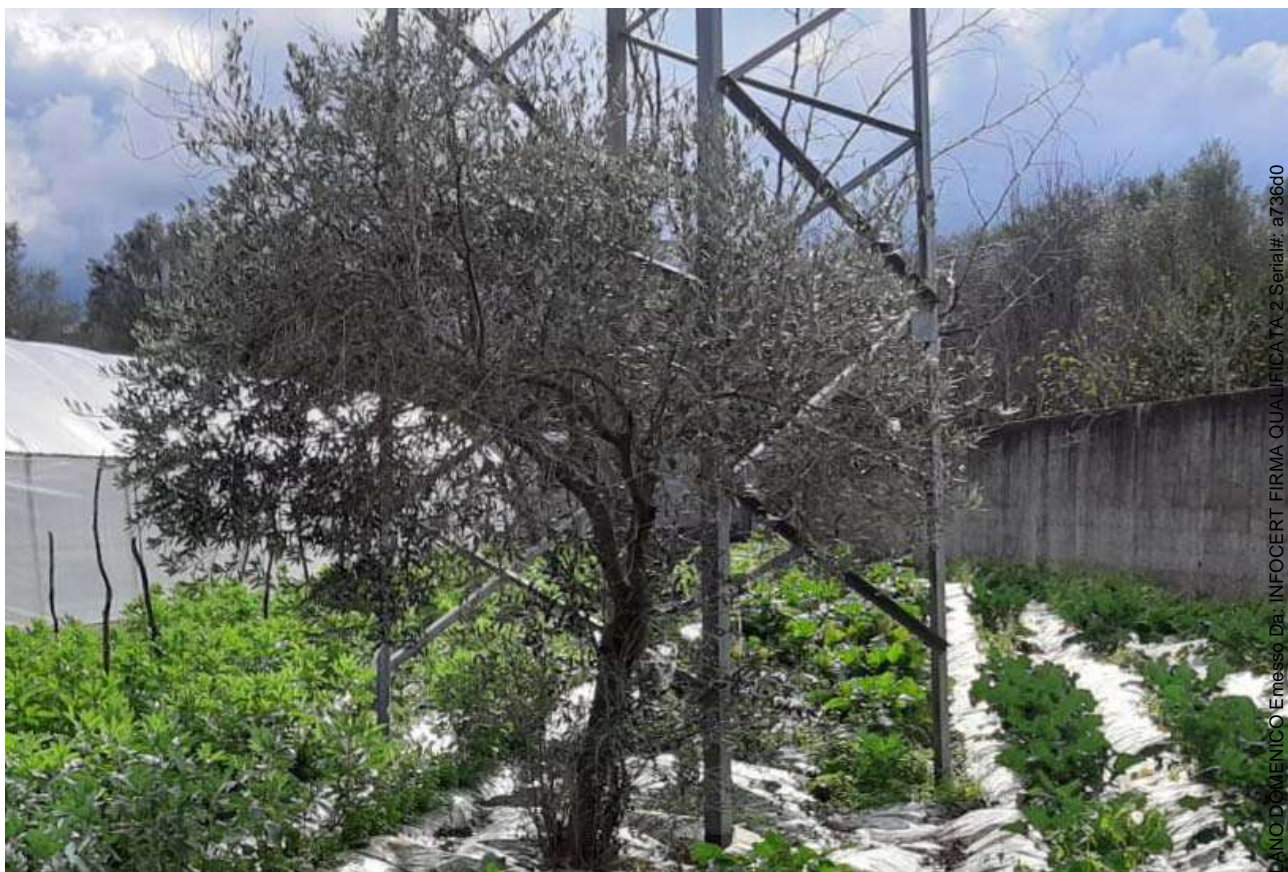
LOTTO 002 – FOTO 22 – Particolare della base del traliccio che insiste sulla p.lla 181
