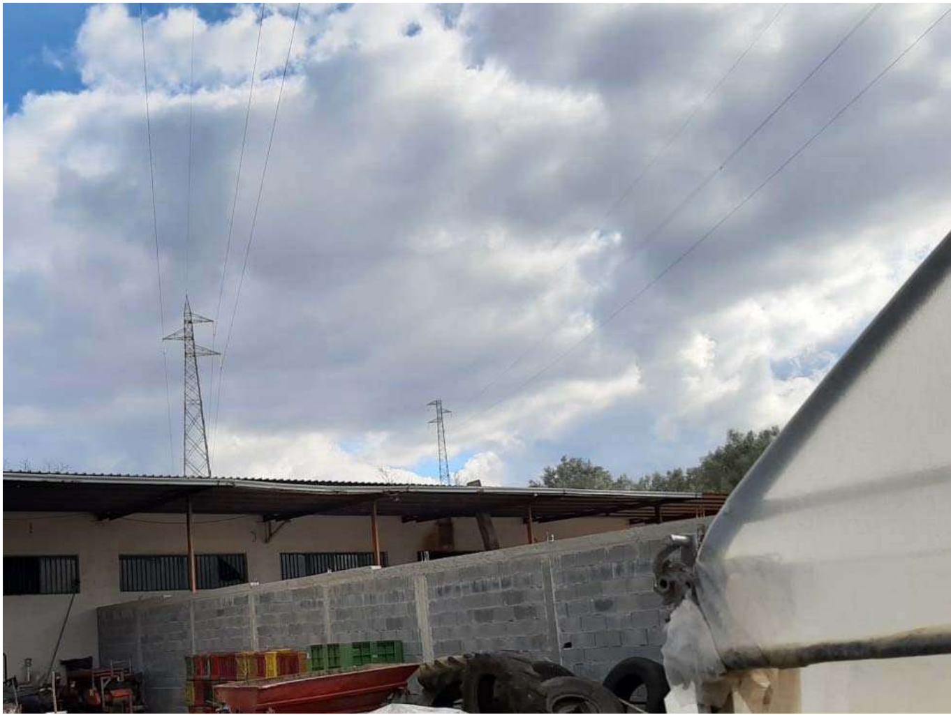
LOTTO 002 – FOTO 23 Particolare inerente la servitù di elettrodotto
