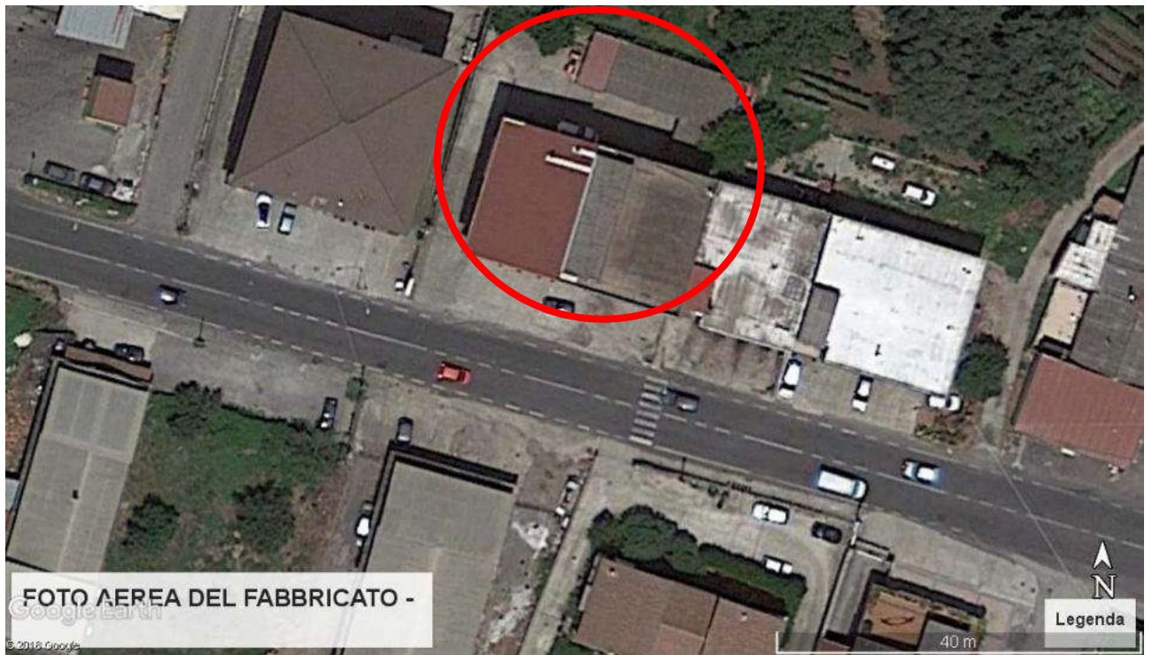
IL FABBRICATO RILEVATO CON GOOGLE EARTH
