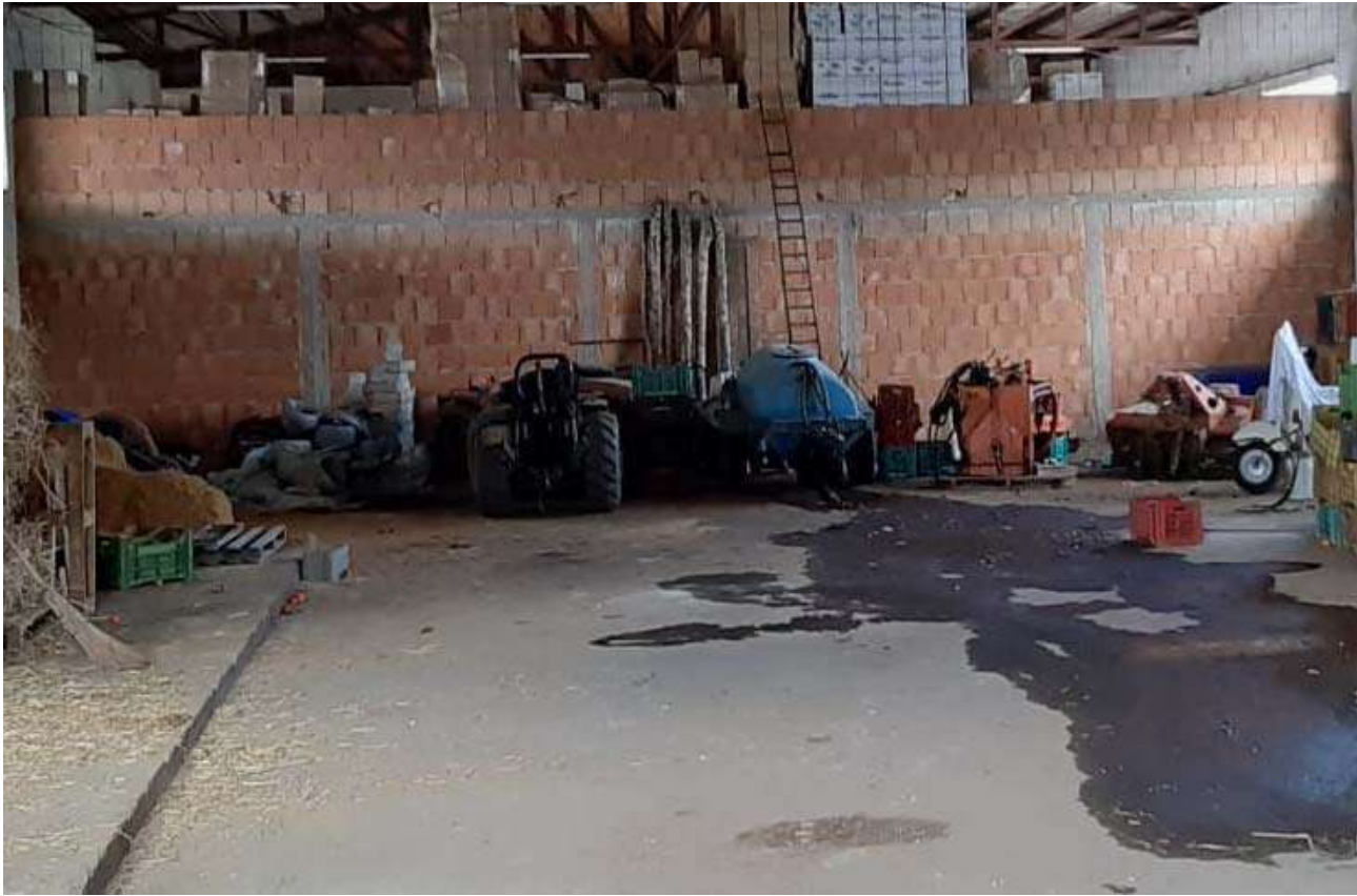
LOTTO 002 – FOTO 19 – Il setto divisorio in muratura tra le due parti del capannone
