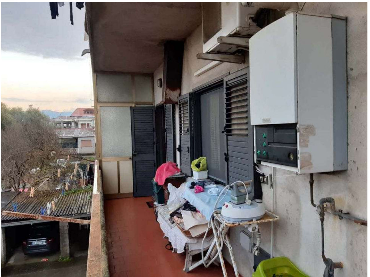
LOTTO 006 – FOTO 6 – Il balcone sul retro – particolare della veranda/lavatoio e della caldaia a muro
