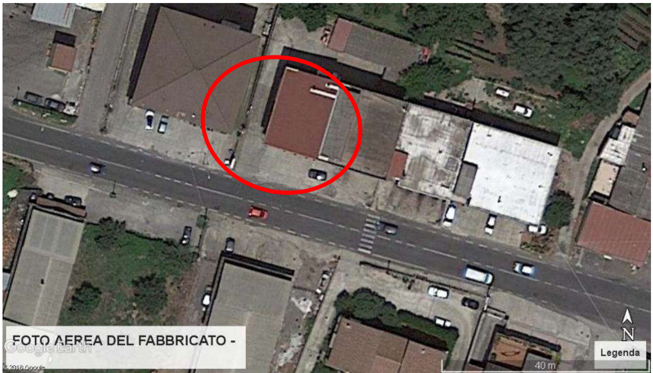
IL FABBRICATO RILEVATO CON GOOGLE EARTH
