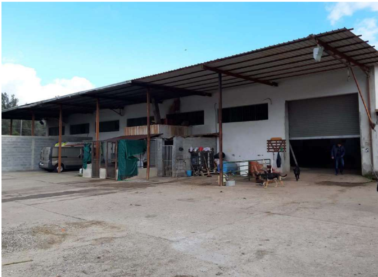
LOTTO 002 – FOTO 5 – Il capannone con il setto divisorio esterno in muratura a blocchi di calcestruzzo
