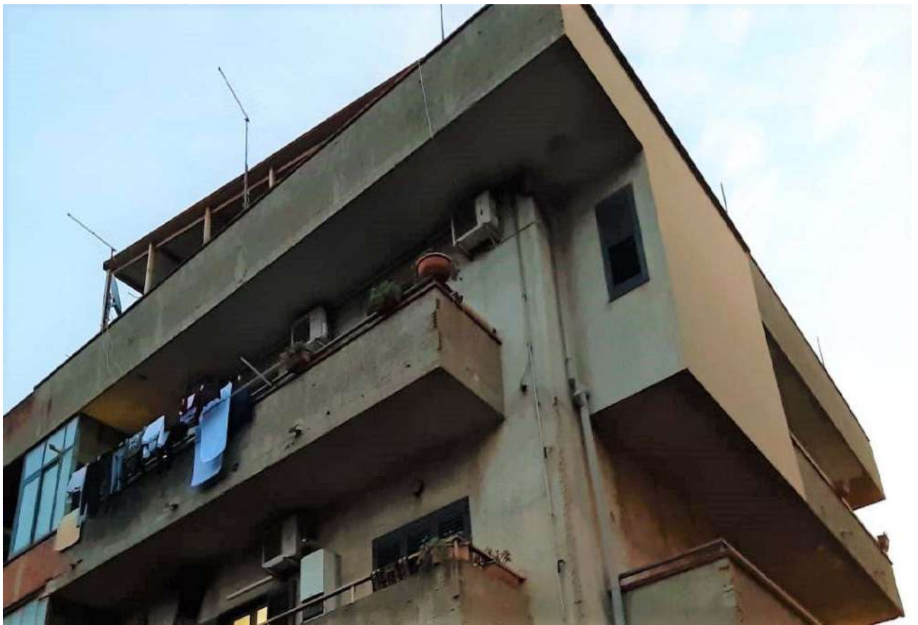
LOTTO 007 – FOTO 12 – Vista della balconatura sul retro – con la veranda/lavatoio - e sul lato – con la chiusura del vano adibito a bagno
