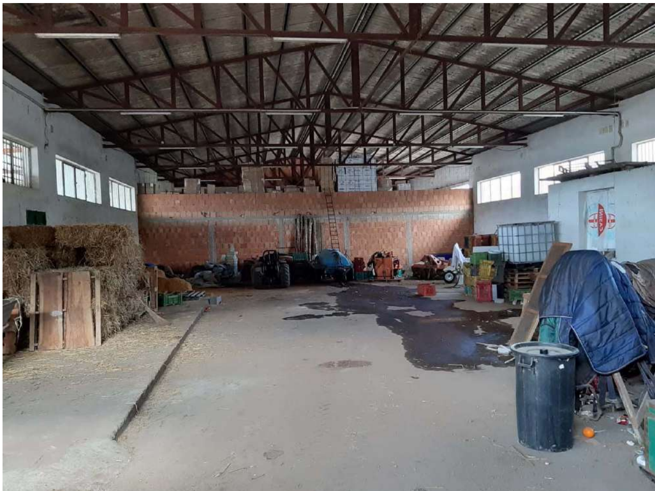
LOTTO 002 – FOTO 17 – L'interno del capannone
