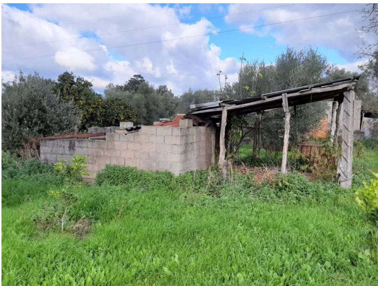
LOTTO 003 – FOTO 4 – Manufatto in blocchi di calcestruzzo per piccolo allevamento – in stato di abbandono
