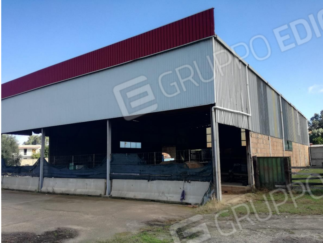
Foto 1: Catasto Fabbricati di Gioia Tauro, foglio 33, particella 392. Esterno del capannone con struttura metallica descritto al punto "a".
