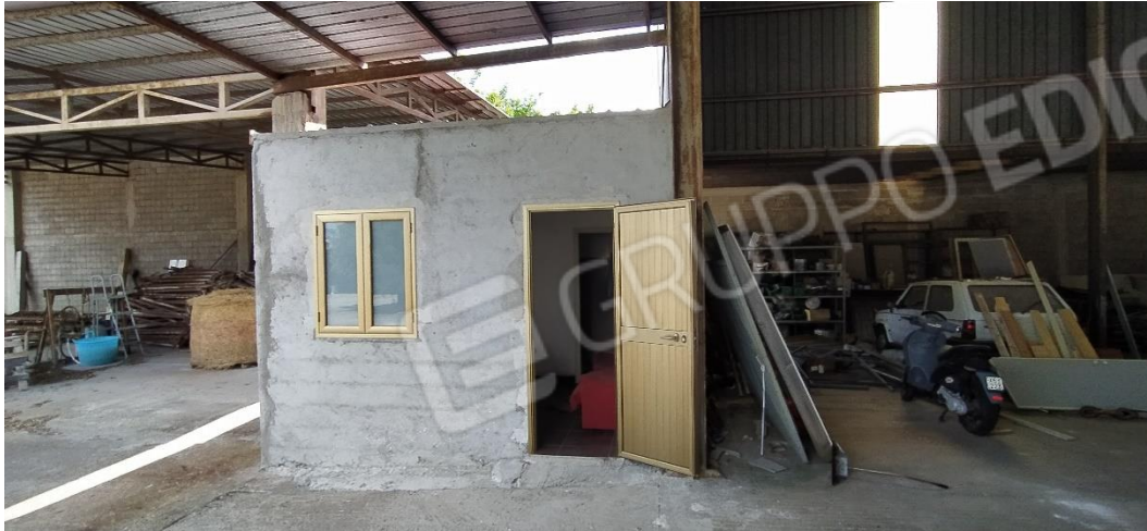
Foto 5: Catasto Fabbricati di Gioia Tauro, foglio 33, particella 392. Piccolo fabbricato descritto al punto "e".
