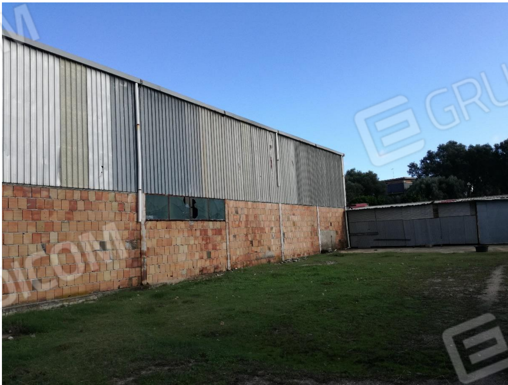
Foto 4: Catasto Fabbricati di Gioia Tauro, foglio 33, particella 392. Sulla sinistra, capannone descritto al punto "a"; sullo sfondo, baracca descritta al punto "c".
