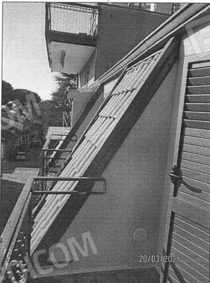
Particolare piano mansardato
