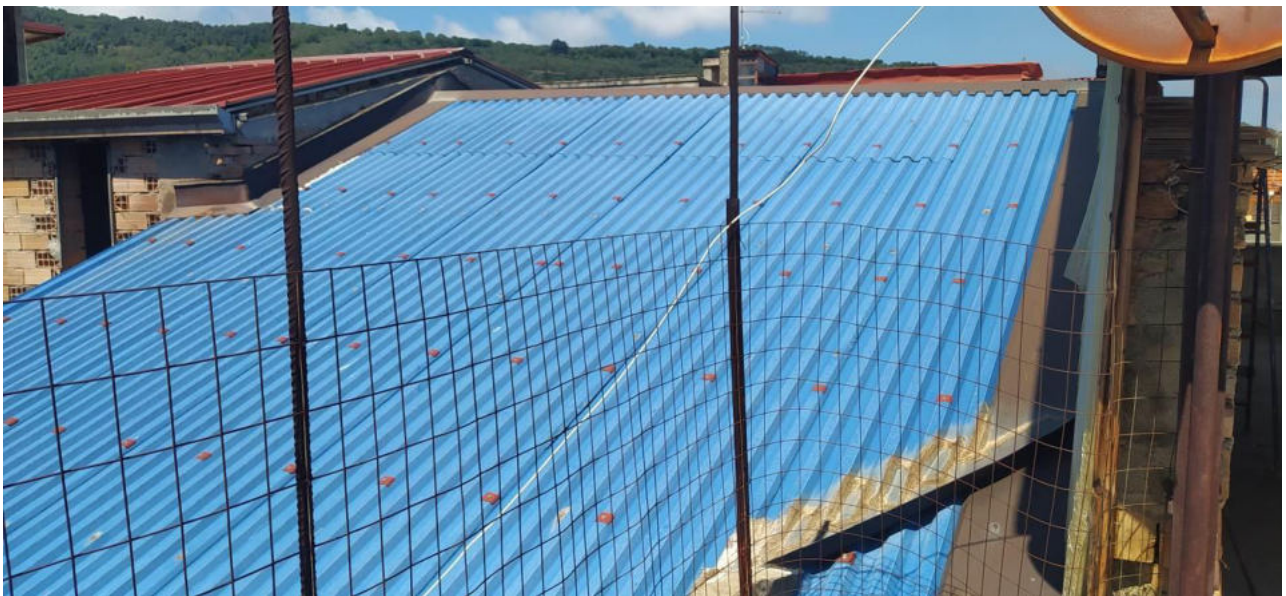
Copertura in lamiera ondulata
