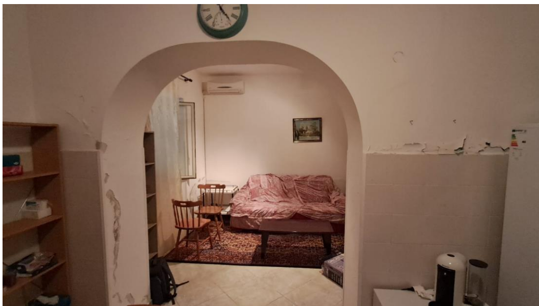
Foto 3: Catasto Fabbricati di Feroletto della Chiesa, foglio 11, particella 420 sub 3 – soggiorno.
