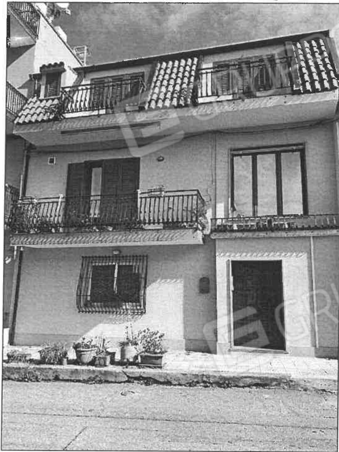
Prospetto sulla via F. Crispi
