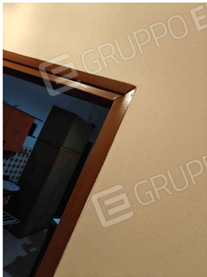
FOTO 12: Particolare dei telai delle porte interne
