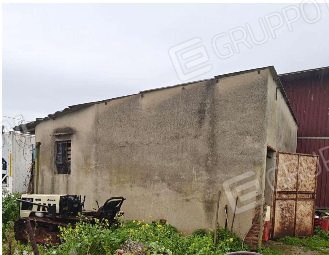
FOTO 10 : Il fabbricato visto da altra angolazione
