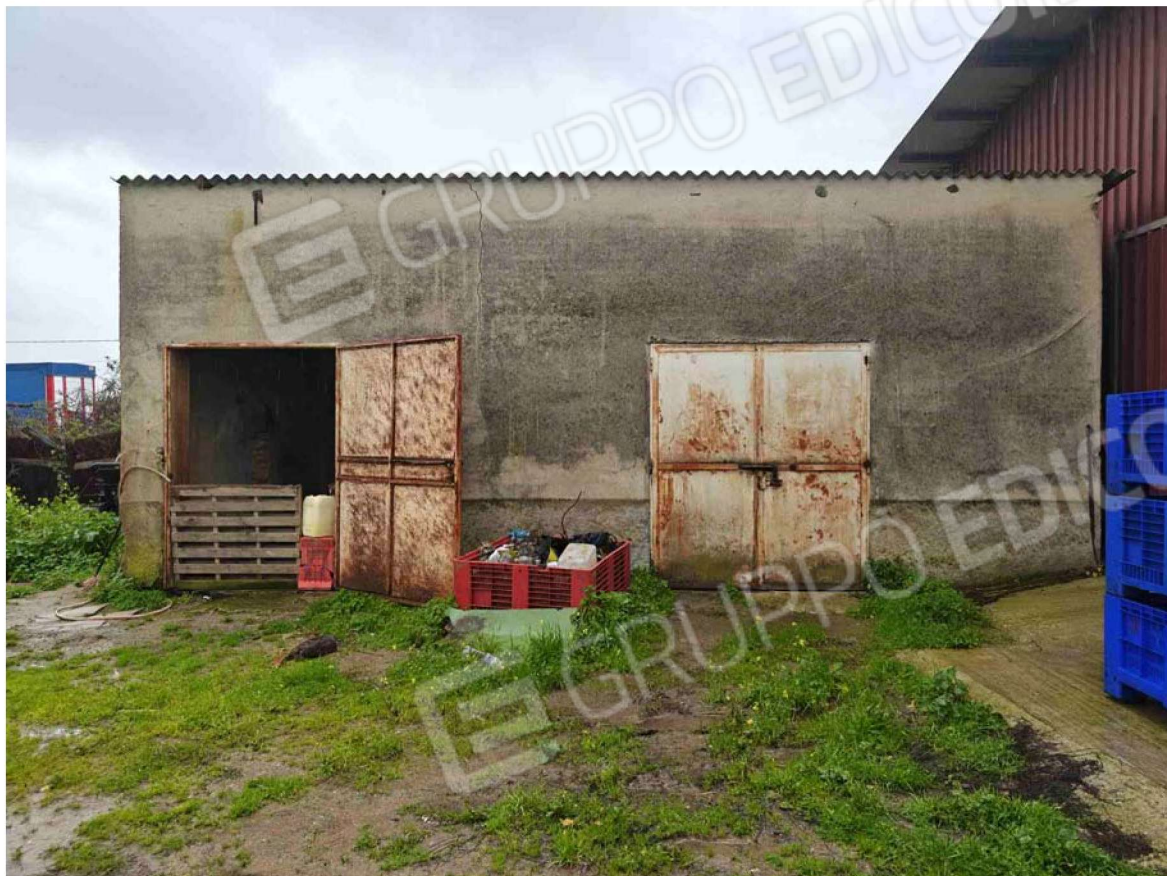
FOTO 9 : Gli accessi al fabbricato
