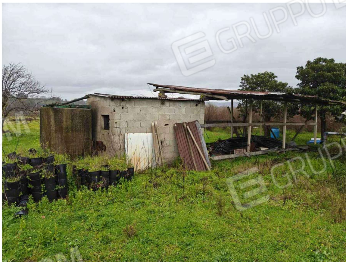
FOTO 8 : Il manufatto visto dal retro
