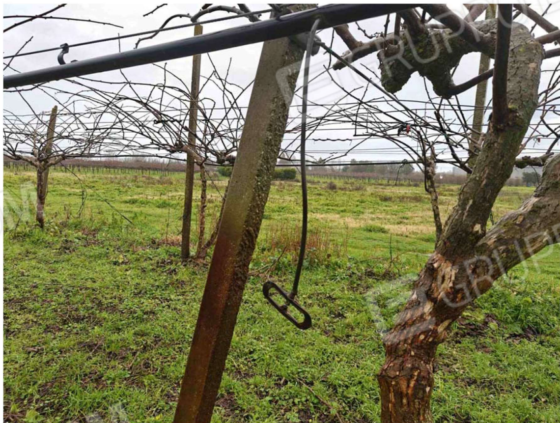
FOTO 6 : Particolari - impianto d'irrigazione e strutture di sostegno
