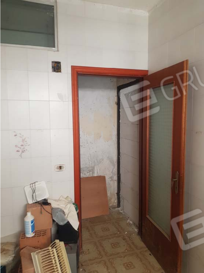
FOTO 47 - Sub.25 appartamento - piano seminterrato
