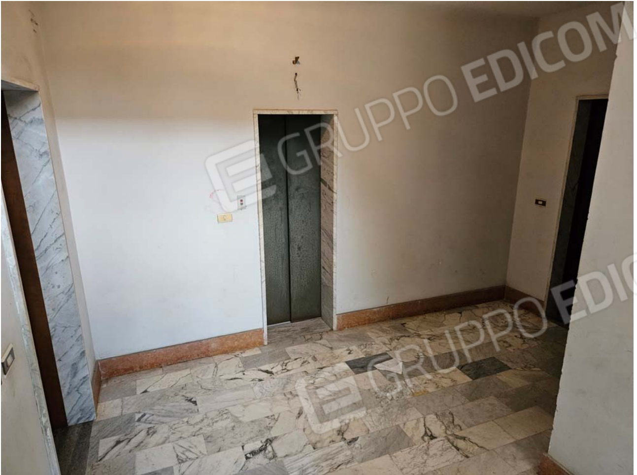
FOTO 13 vano scala fabbricato
