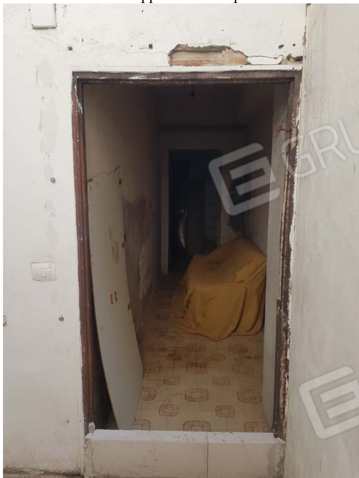
FOTO 31 - Sub.25 appartamento - piano seminterrato
