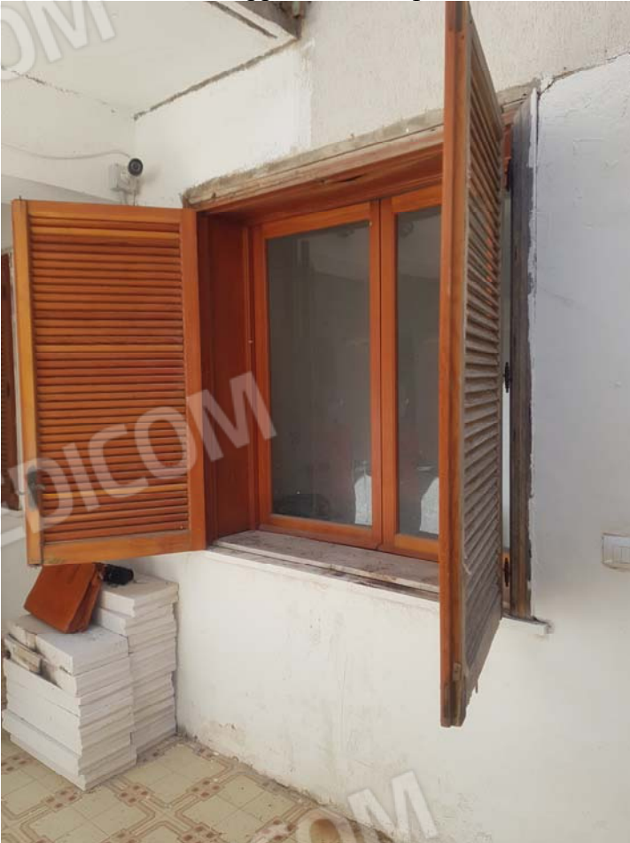
FOTO 46 - Sub.25 appartamento - piano seminterrato
