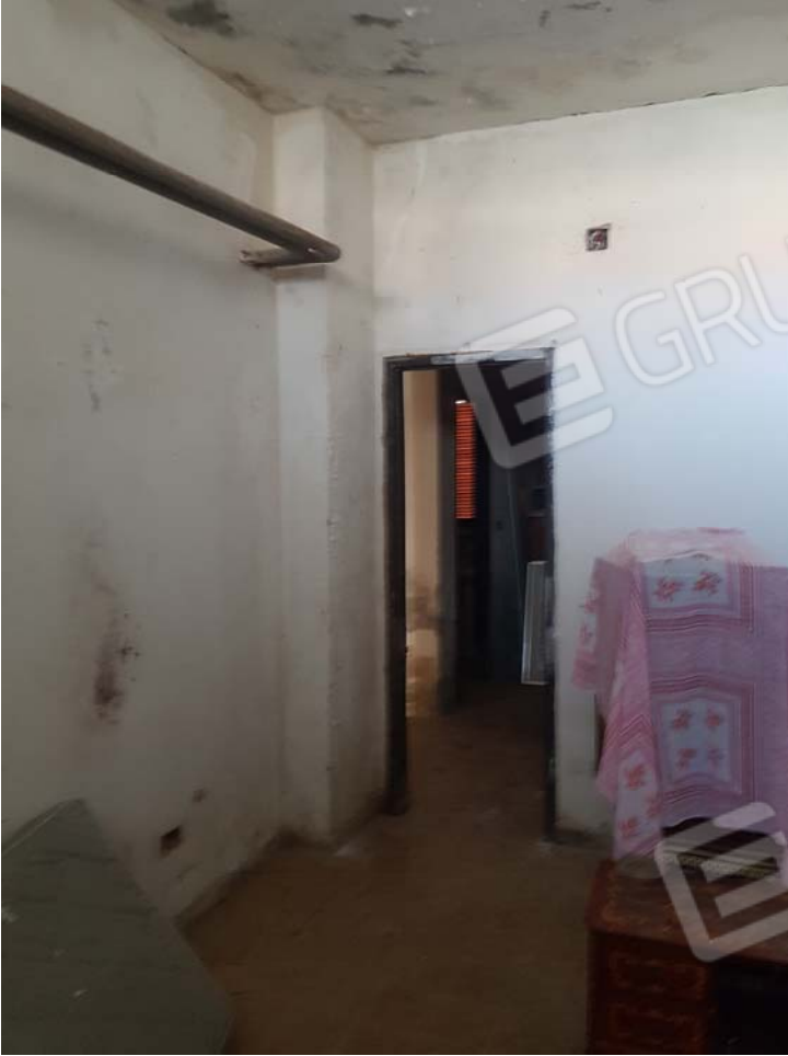
FOTO 37 - Sub.25 appartamento - piano seminterrato
