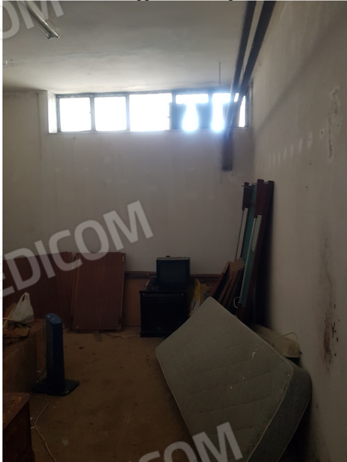
FOTO 36 - Sub.25 appartamento - piano seminterrato
