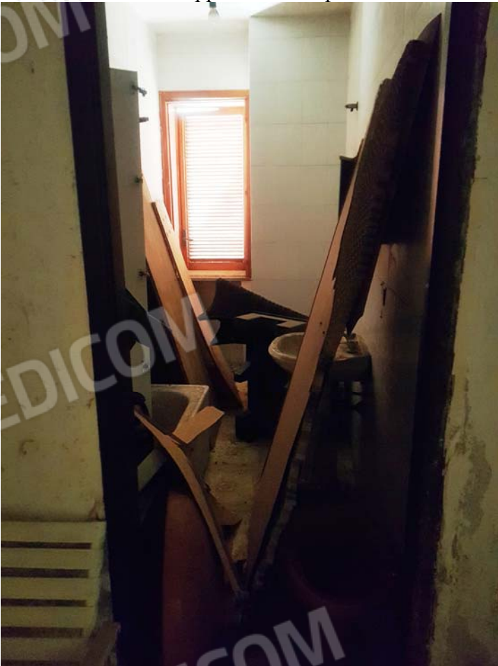
FOTO 50 - Sub.25 appartamento - piano seminterrato
