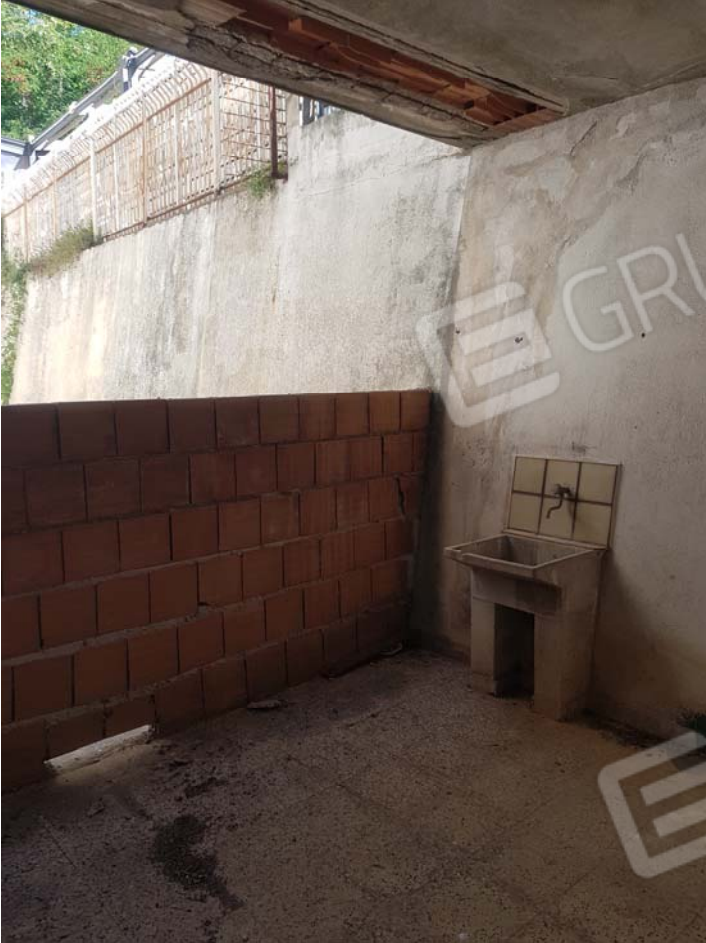
FOTO 43 - Sub.25 appartamento - piano seminterrato
