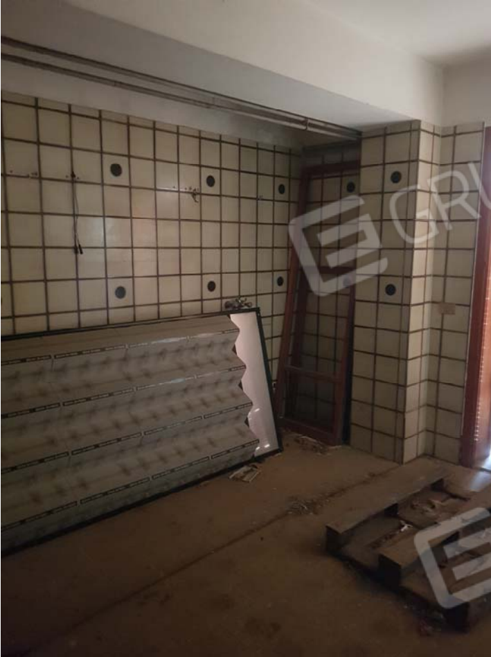
FOTO 39 - Sub.25 appartamento - piano seminterrato
