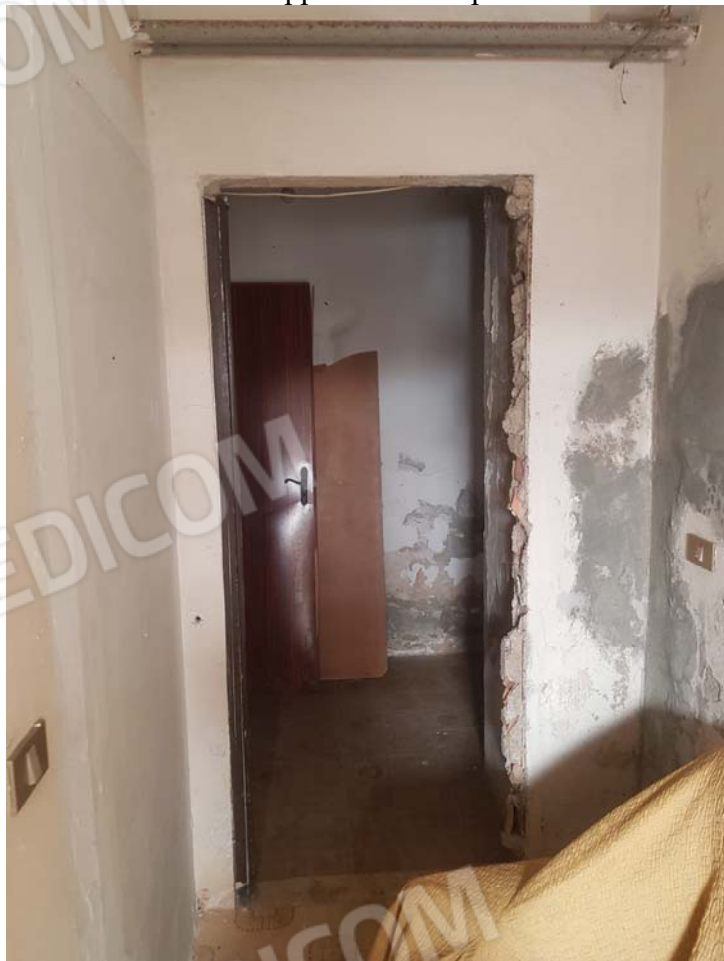
FOTO 32 - Sub.25 appartamento - piano seminterrato
