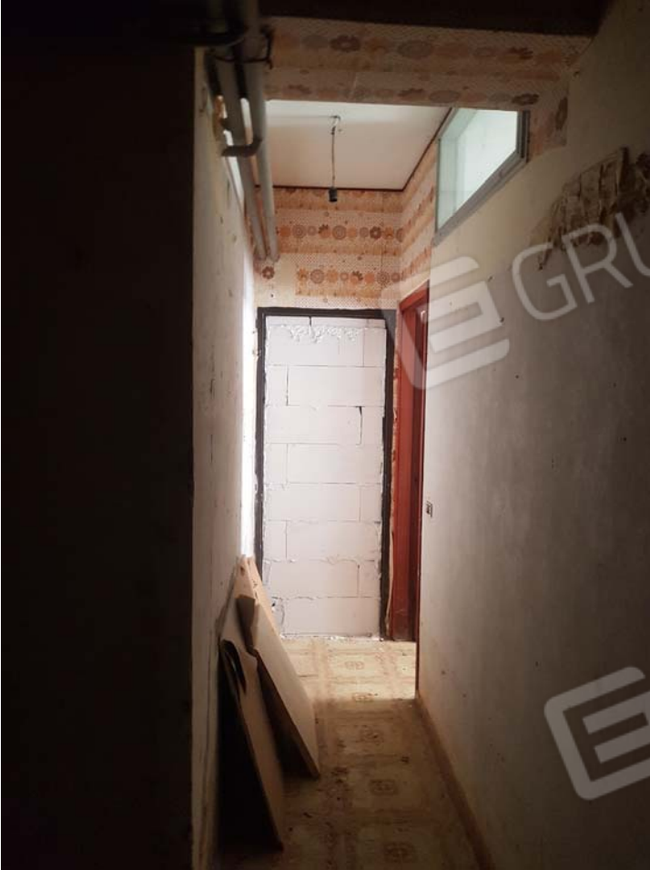
FOTO 49 - Sub.25 appartamento - piano seminterrato
