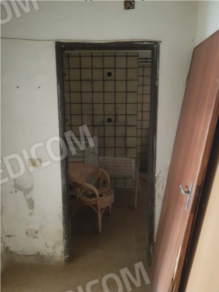
FOTO 38 - Sub.25 appartamento - piano seminterrato
