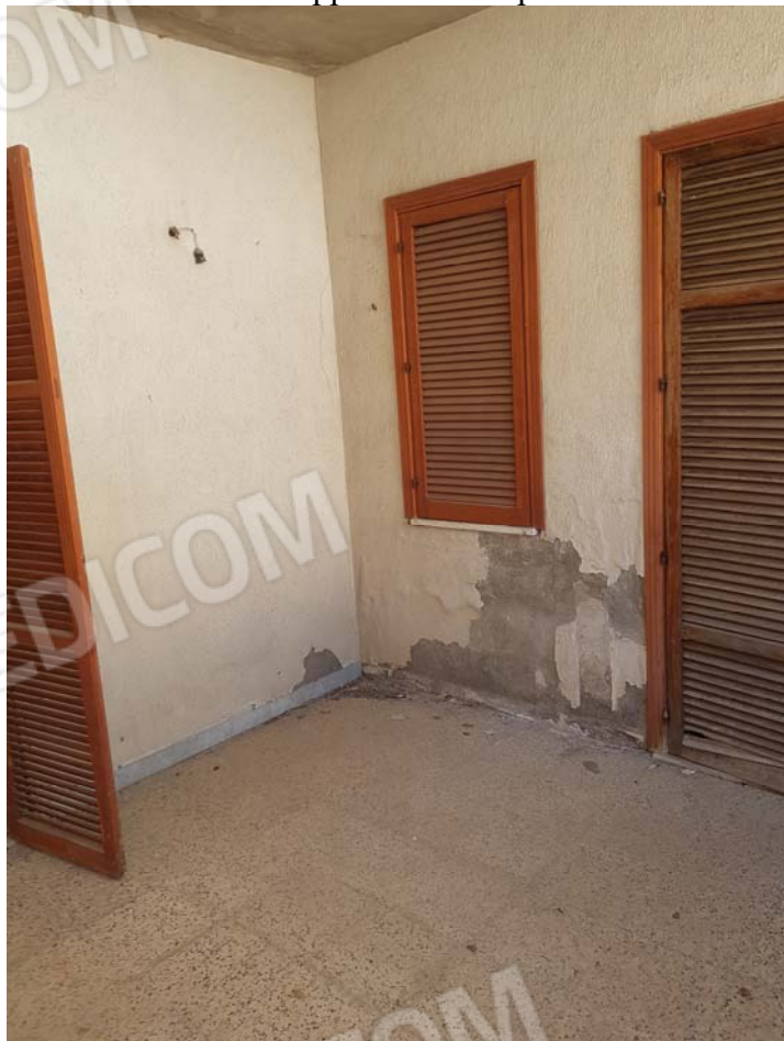
FOTO 42 - Sub.25 appartamento - piano seminterrato
