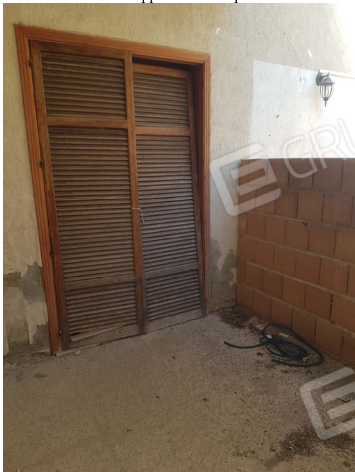
FOTO 41 - Sub.25 appartamento - piano seminterrato
