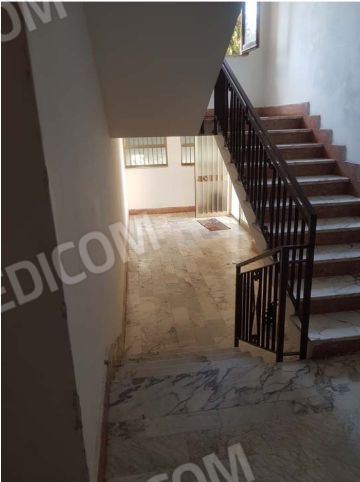
FOTO 12 vano scala fabbricato
