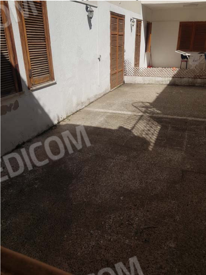
FOTO 44 - Sub.25 appartamento - piano seminterrato
