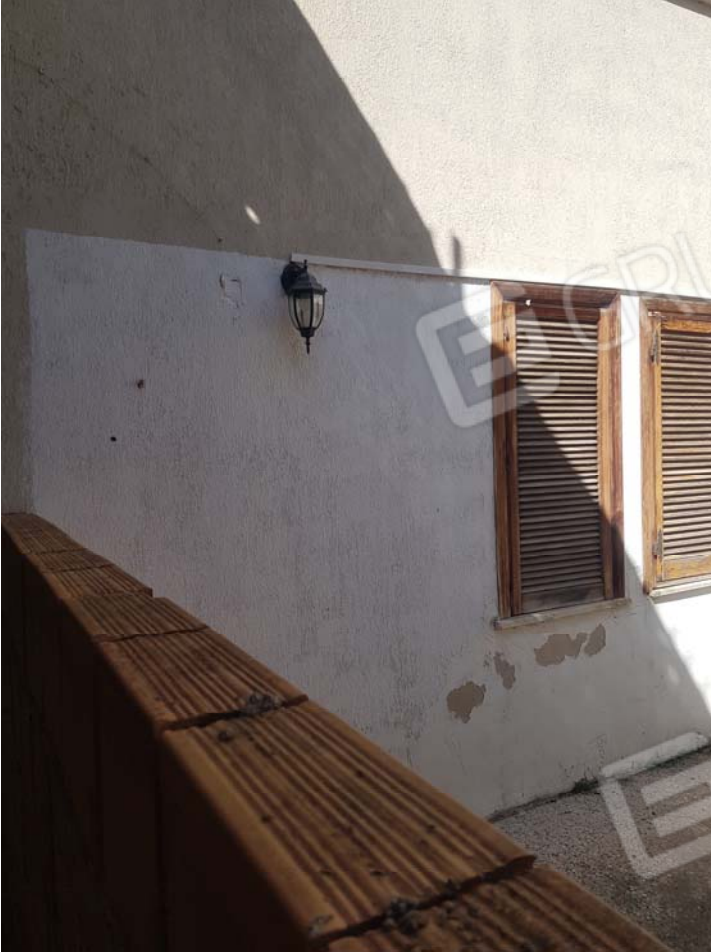
FOTO 45 - Sub.25 appartamento - piano seminterrato
