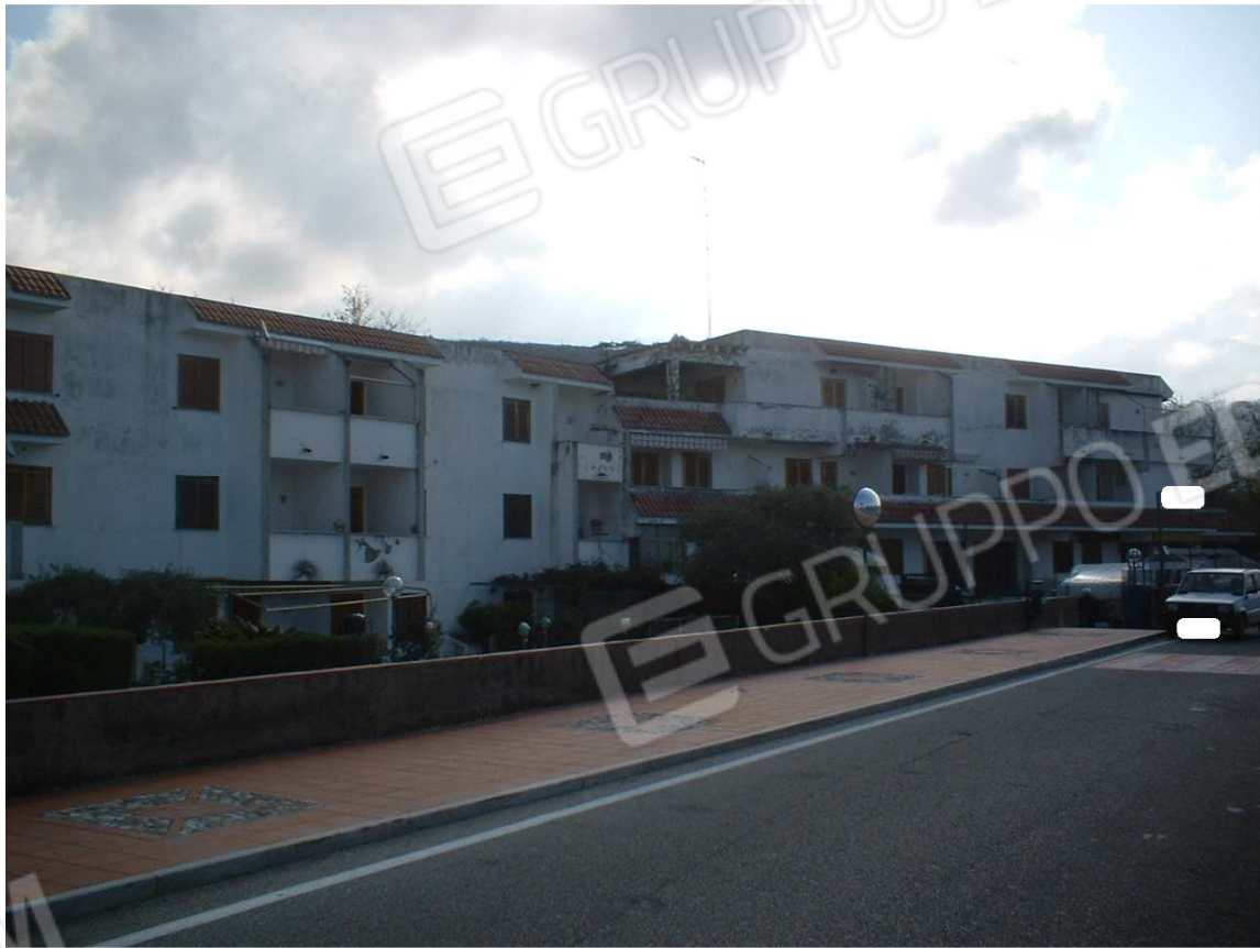
Foto 1- Facciata Ovest del fabbricato
