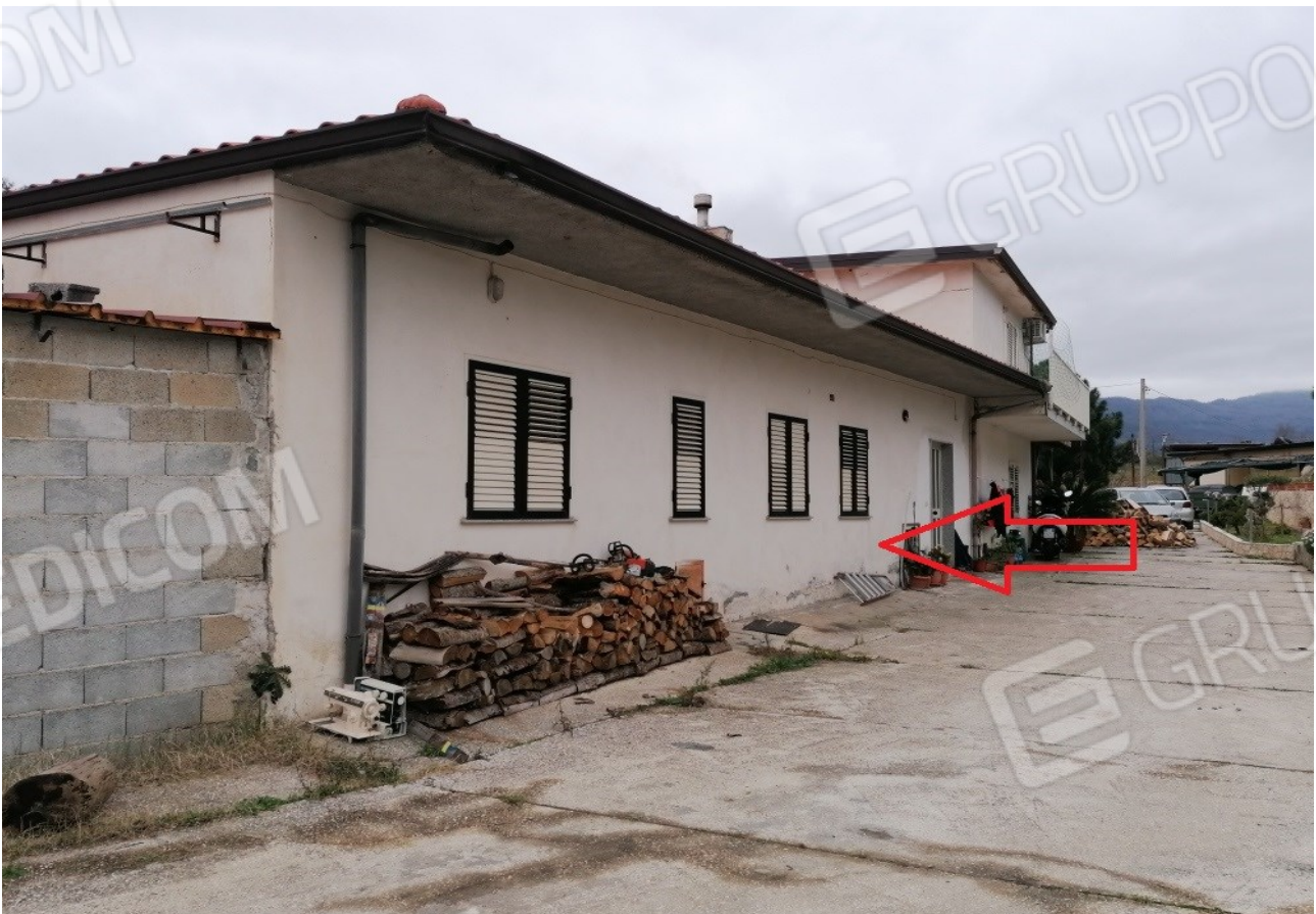
Foto n° 12 – Vista esterna con prospetto est degli immobili direzione nord –
