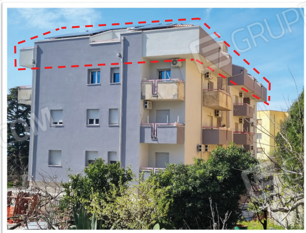
Foto 2 - Vista prospetto Sud/Est - Indicazione immobile Sub 32
