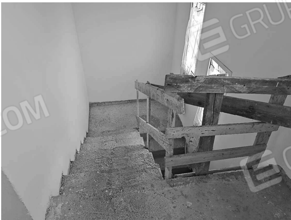
Foto n. 12 – vano scala di collegamento tra piano terra e piano primo
