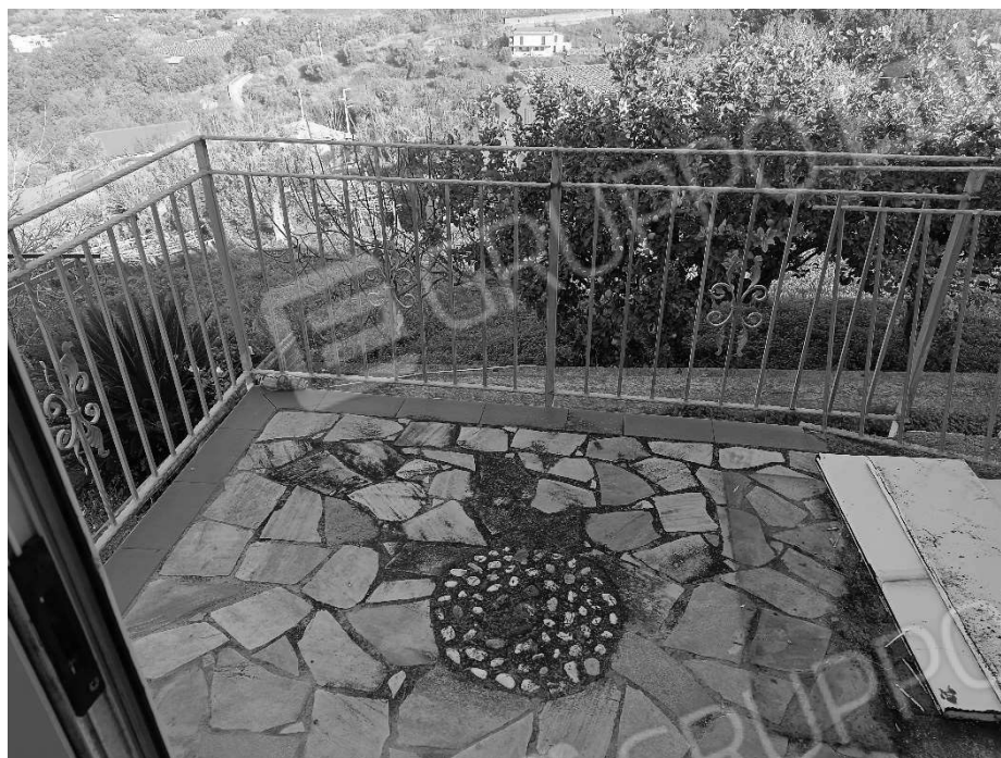
Foto n. 21 – Terrazzo piano primo
