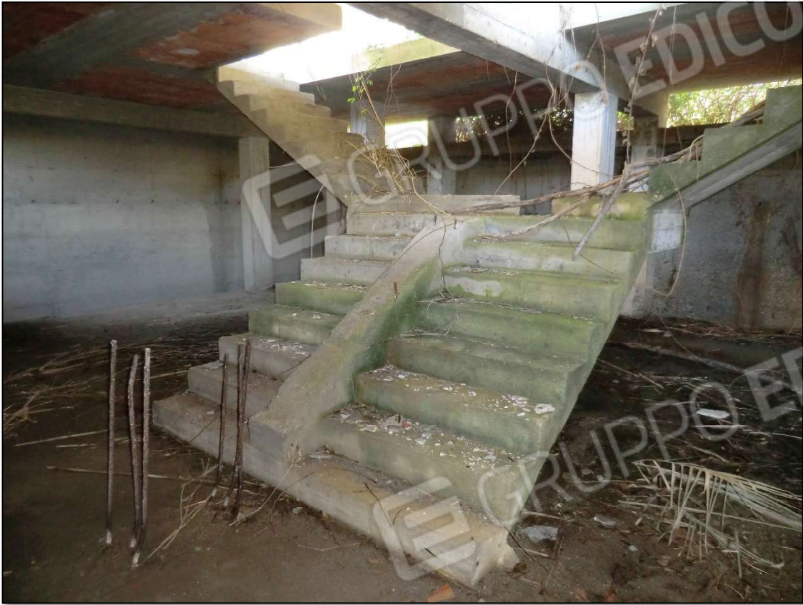
Foto 11_piano interrato lato nord
