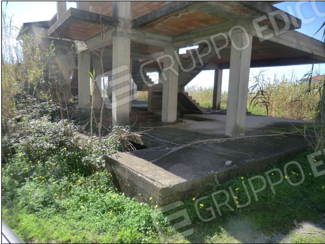
Foto 15_piano terra vista nord est
