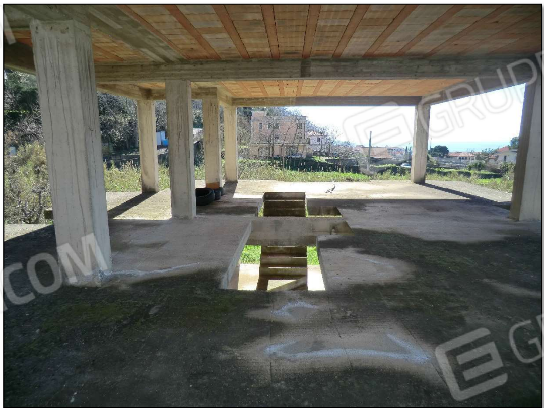
Foto 16_piano primo vista verso sud
