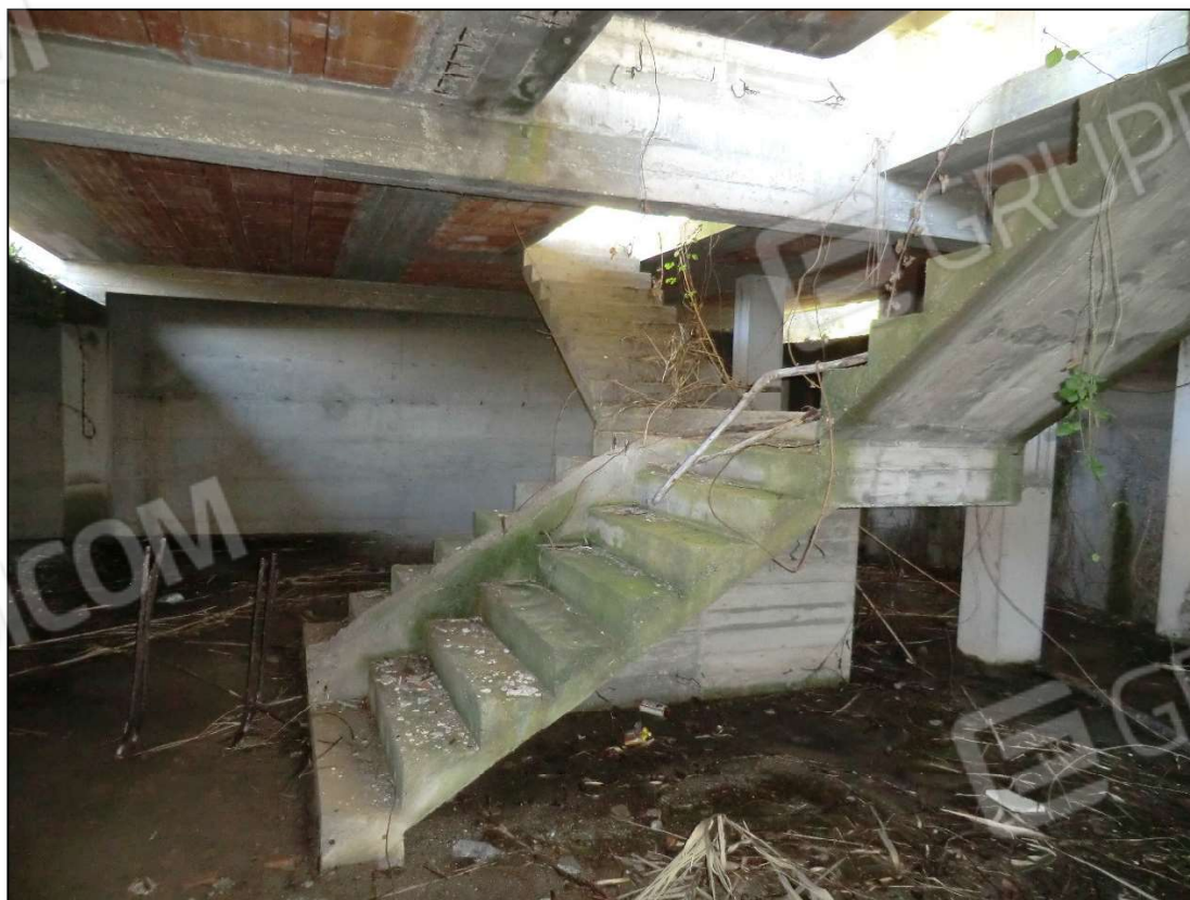
Foto 10_piano interrato lato nord
