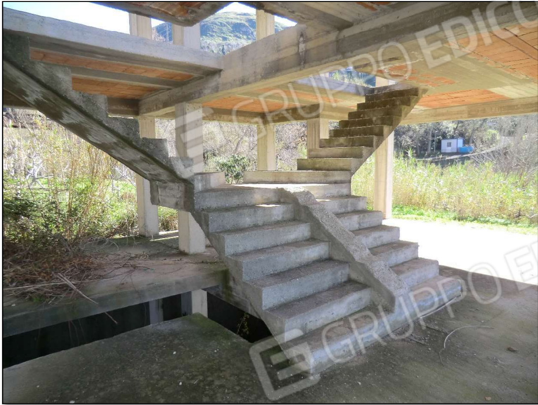
Foto 13_piano terra vista verso sud
