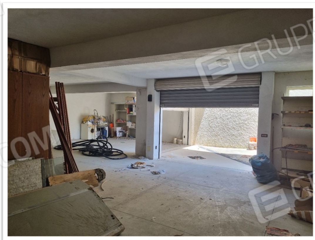
Foto 10 – Vista locale interno
