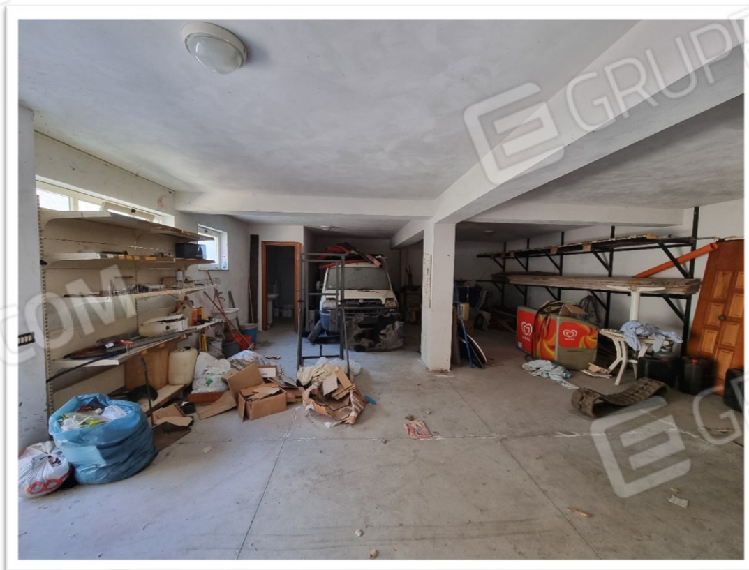
Foto 4 – Vista locale interno
