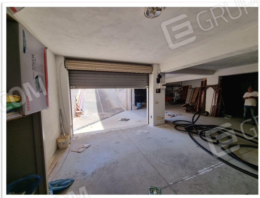
Foto 8 – Vista locale interno
