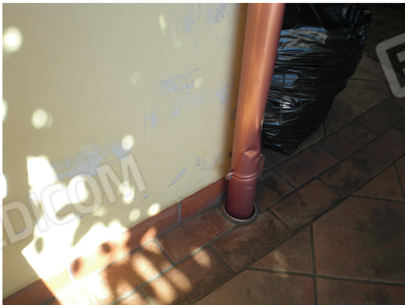
FOTO 9 – particolare parete esterna cucina
