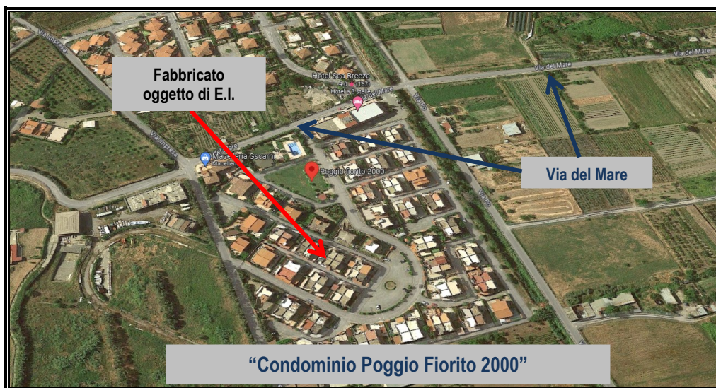
Foto aerea che documenta il "Condominio Poggio Fiorito 2000" in località Foresta - Scalea (Cs)
