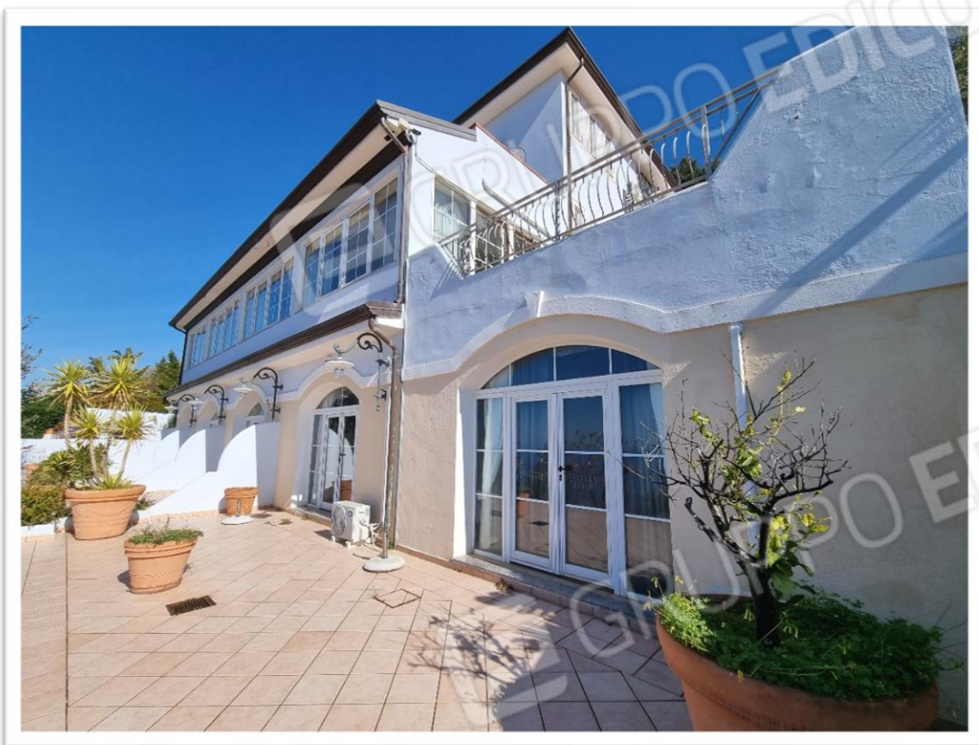
Foto 11 – Particolare prospetto Ovest
