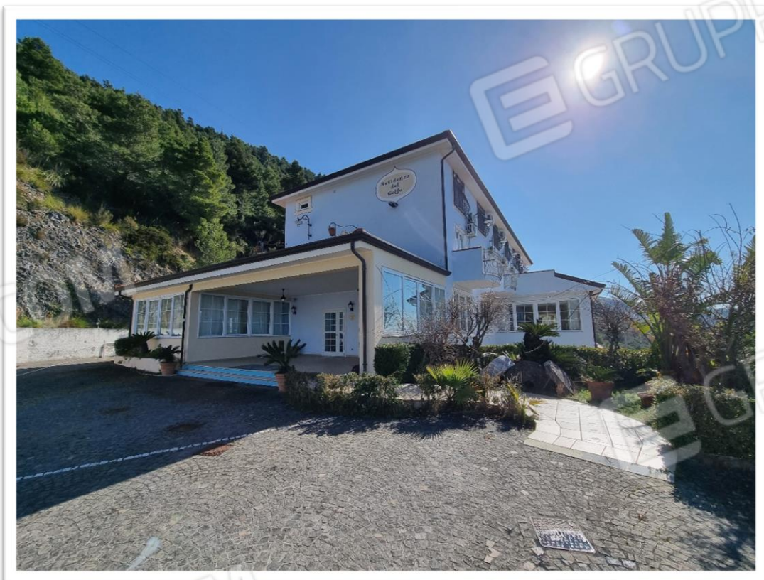
Foto 4 - Vista prospetto Nord/Ovest – ingresso principale
