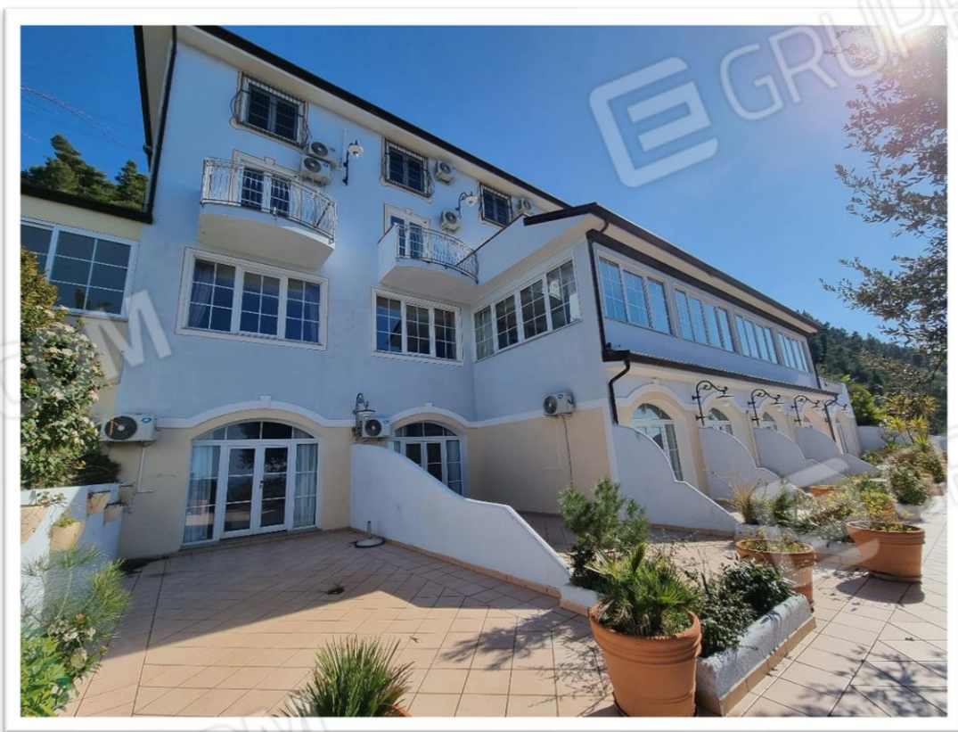
Foto 10 – Vista prospetto Ovest
