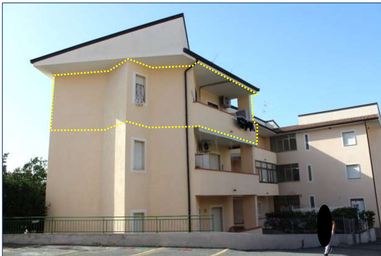
9 - Fabbricato con indicazione dell'unità immobiliare n° 1.2 in procedimento – Vista lato Nord/Est
