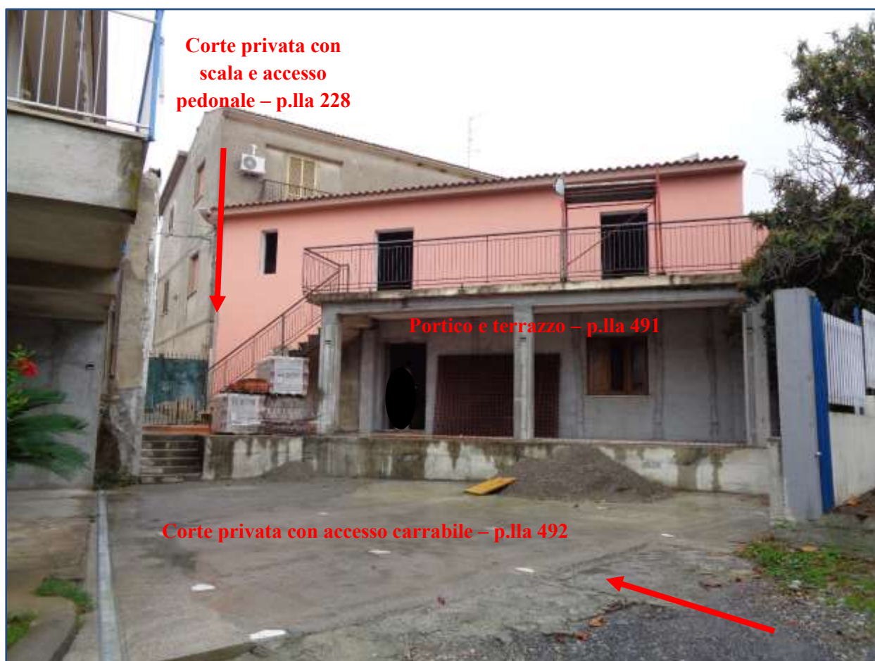
5 –Portico e terrazzo occupanti la p.lla n. 491, corti private con accesso carrabile e pedonale – p.lle nn. 492-228
