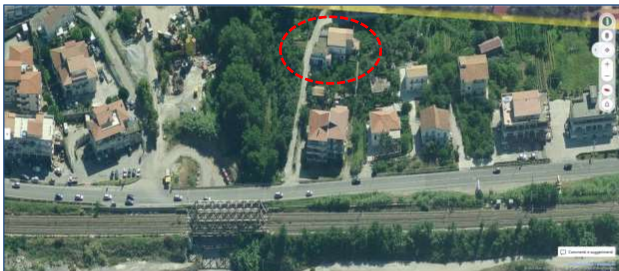
26, 27- Viste satellitari del corpo di fabbrica del quale fa parte l’unità immobiliare n. 3
