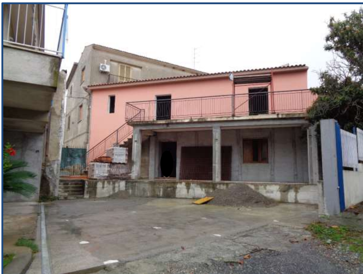
3 - Vista del prospetto principale – visibile il portico con il soprastante terrazzo e la scala esterna comunicante.
