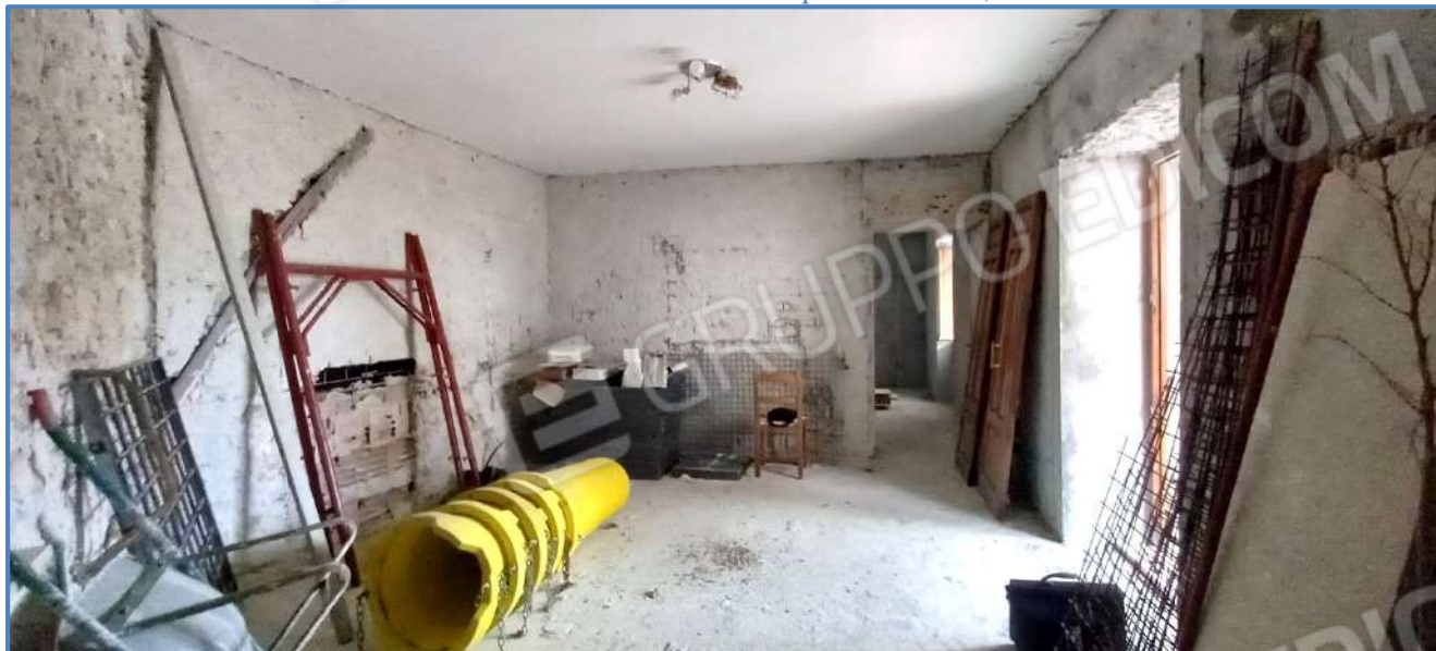
1.32 – SOPRALLUOGO DEL 06/12/2024 – locale di cui alla p.lla 44 – P.T., rimasto allo stato rustico
