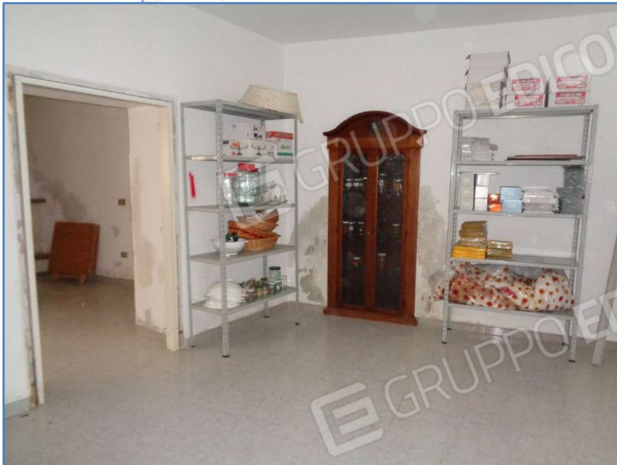
1.38 – Vano di cui alla p.lla 45 sub 6, P.T.
