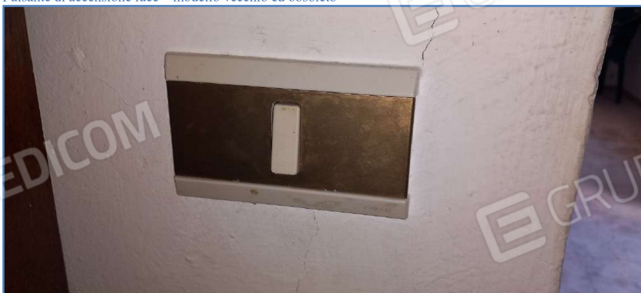
Pulsante di accensione luce – modello vecchio ed obsoleto
