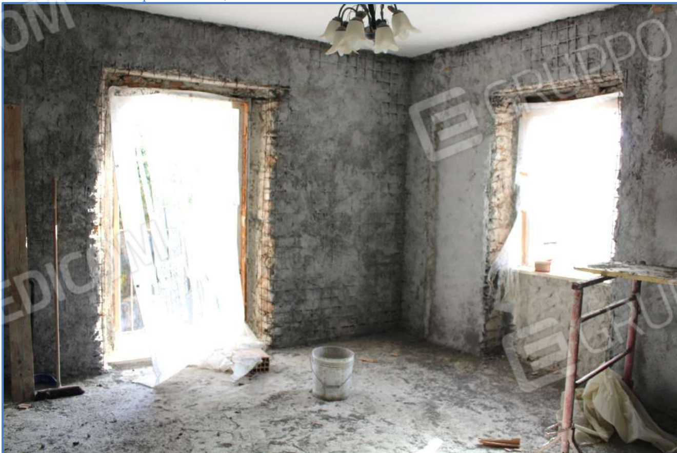
1.31 – Vano di cui alla p.lla 45 sub 5, P. 1°
