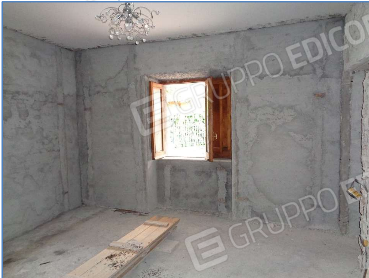
1.36 – Secondo locale di cui alla p.lla 44 – P.T.
