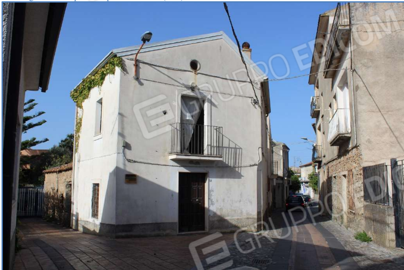
1.6 – Ingresso dalla presunta particella n. 46 (P.T.)
