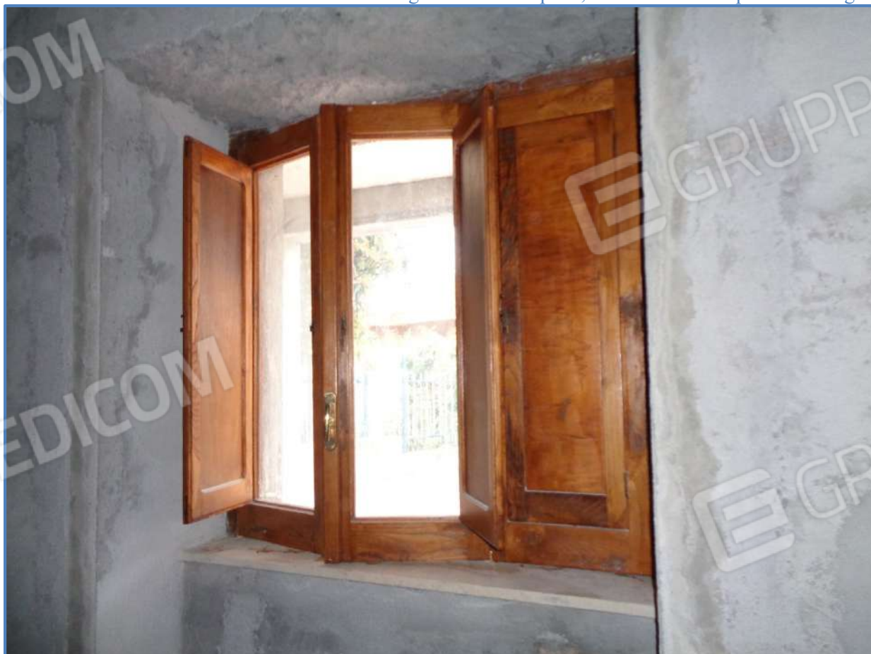
1.37 – Particolare vista sull'infisso con anta in legno e vetro semplice, dotato di scuri in pannelli di legno
