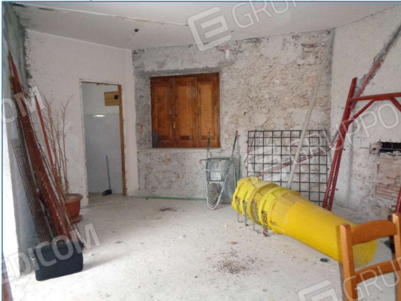
1.33 – Locale di cui alla p.lla 44 – P.T., rimasto allo stato rustico
