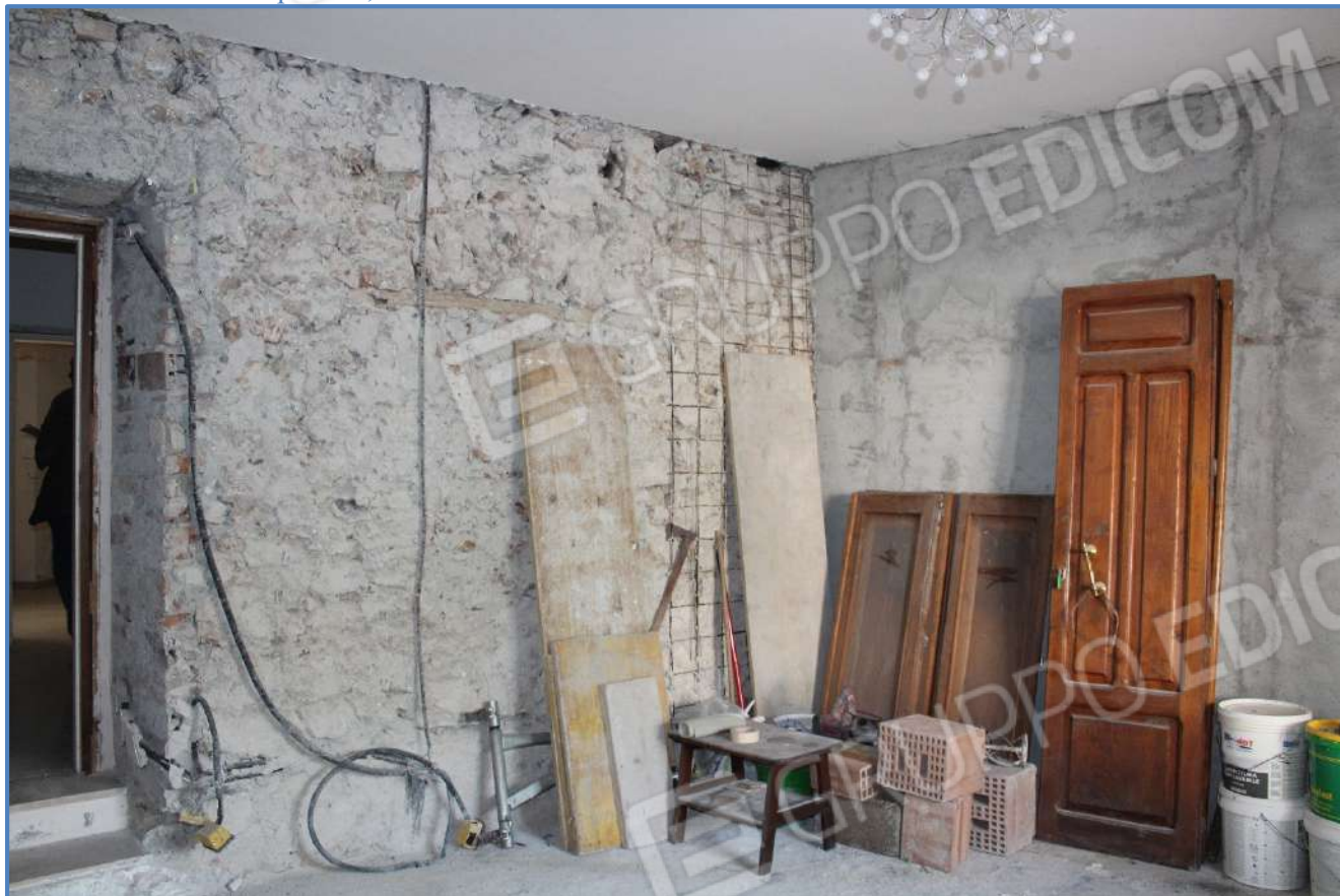
1.24 – vano di cui alla p.lla 44, P.T. – locale allo stato rustico
