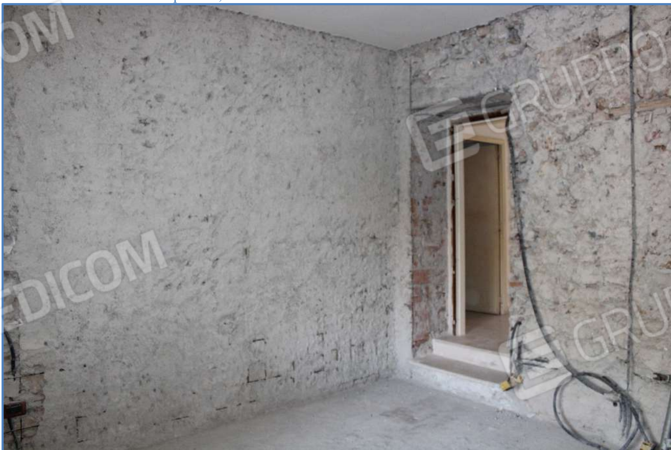
1.23 – Altro vano di cui alla p.lla 44, P.T. – locale allo stato rustico
