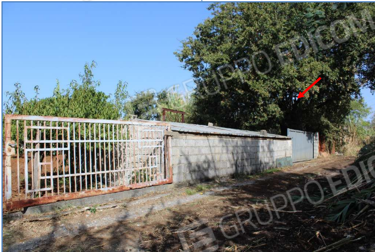
3.7 – Particella di terreno n. 491 – Porzione di terreno occupata e resa inaccessibile
