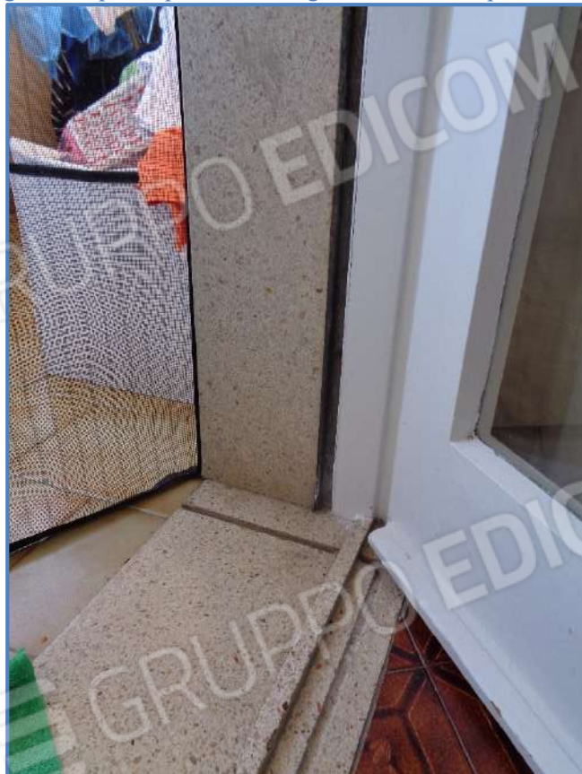
2.10, 2.11 – Porta balcone in legno verniciato e vetro singolo semplice; particolare soglia e imbottito in pietra
