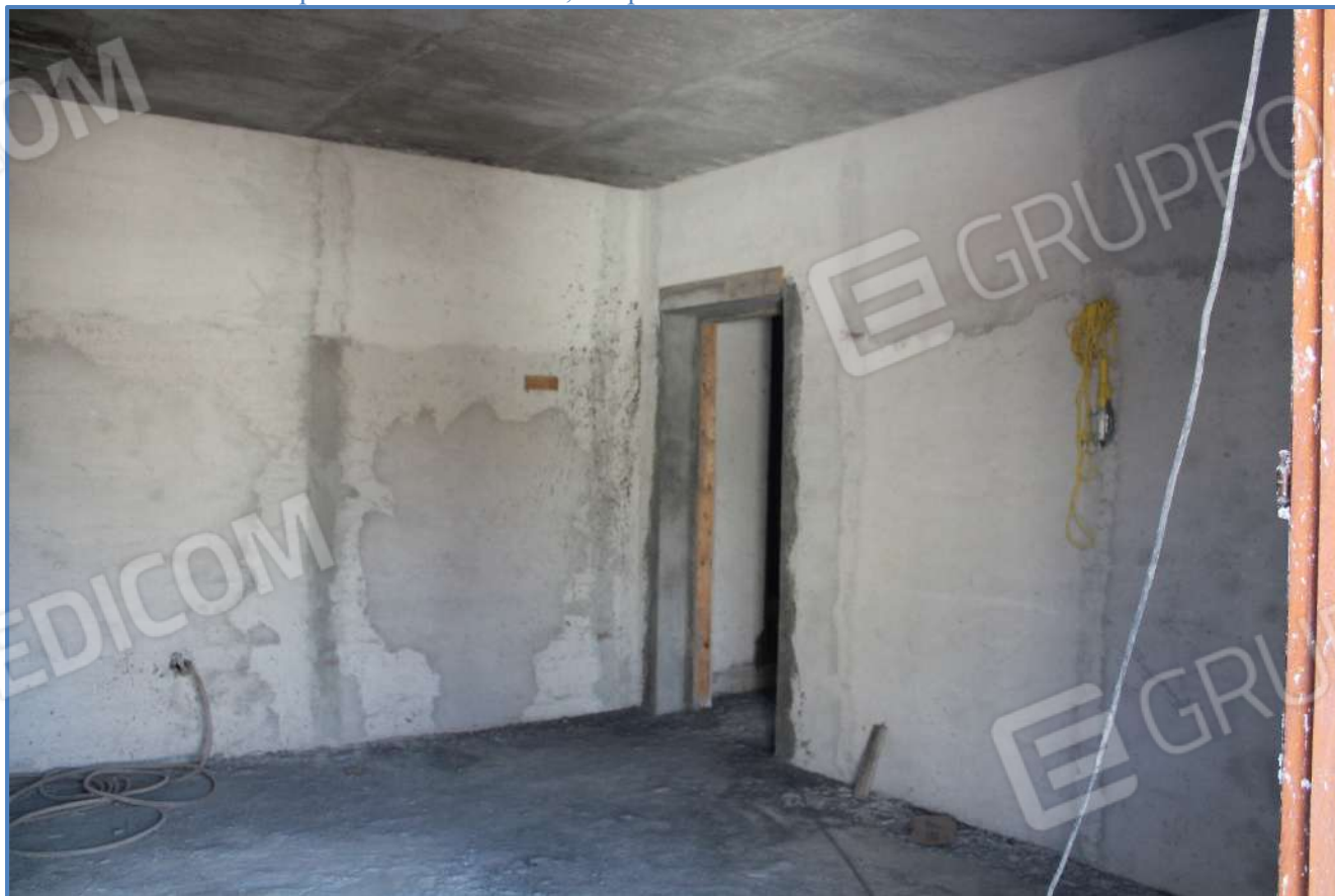
1.28 – Locale di cui alla p.lla 44 – Piano Primo, sempre allo stato rustico
