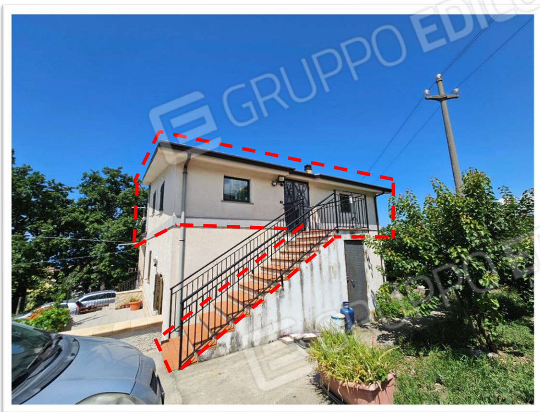
Foto 1 - Vista prospetto Sud/Est - Indicazione immobile - - -
