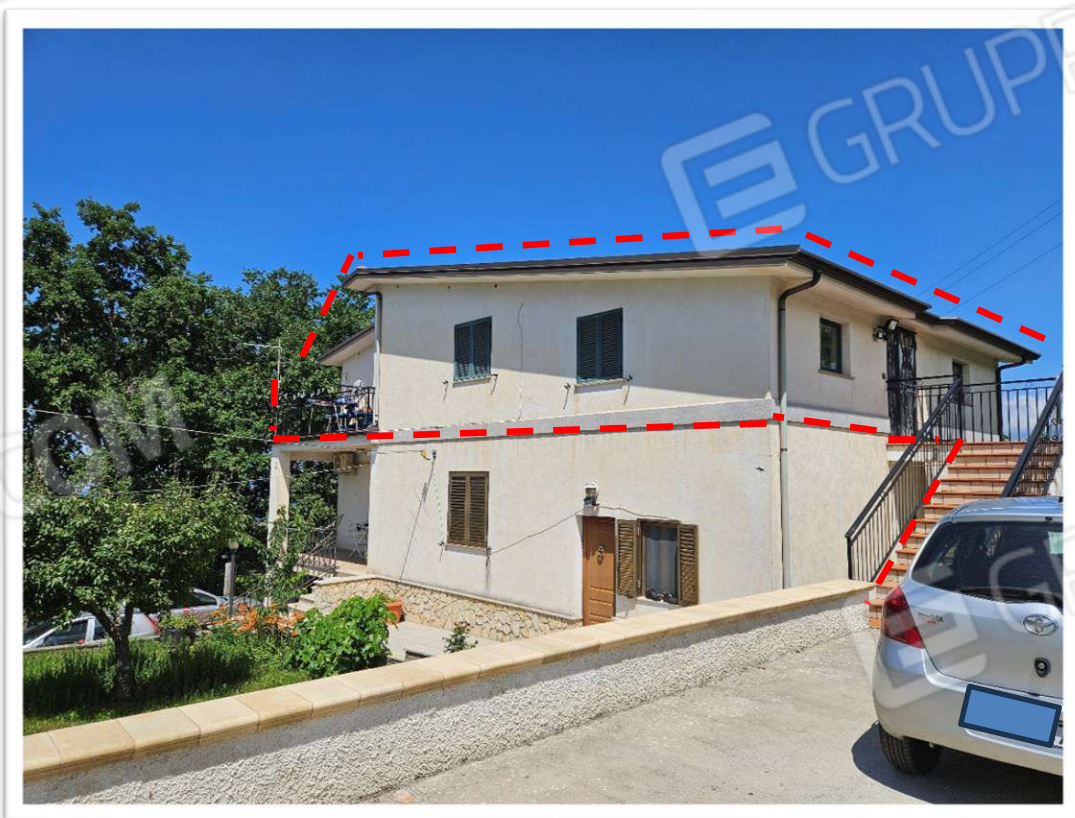
Foto 2 - Vista prospetto Sud/Est - Indicazione immobile - - -
