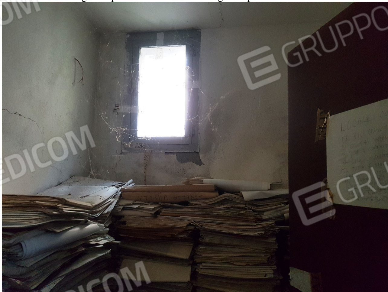
FOTO 47 interno Foglio 40 p.la 728 Sub.1 e sub.2 - Foglio 40 p.la 49 Sub.4
