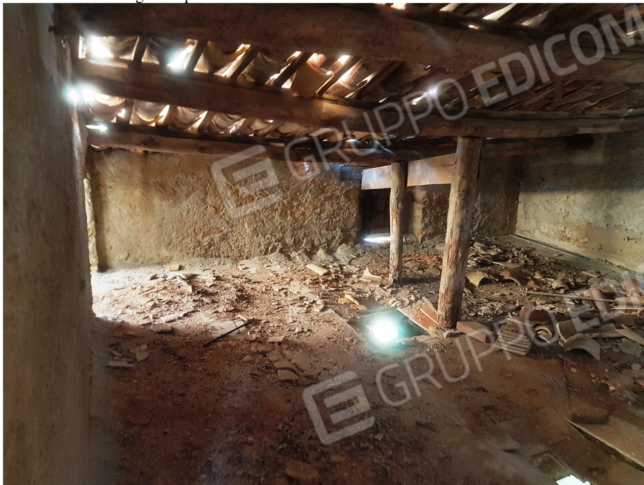
FOTO 66 interno Foglio 40 p.la 49 Sub.5
