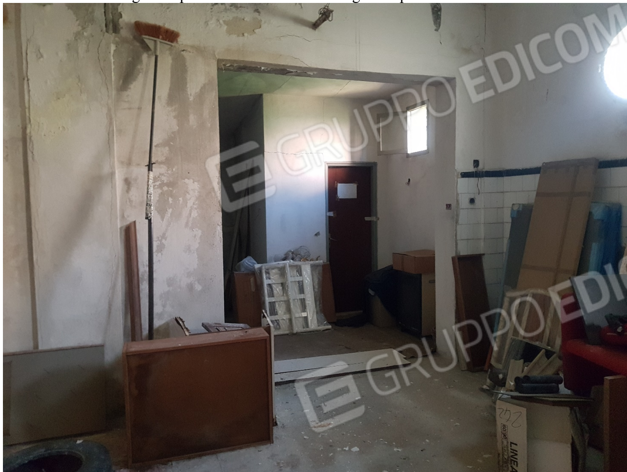
FOTO 44 interno Foglio 40 p.la 728 Sub.1 e sub.2 - Foglio 40 p.la 49 Sub.4
